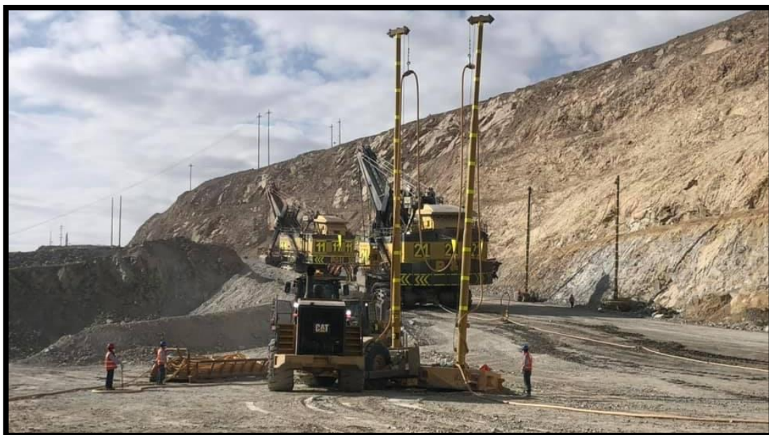
Figura 15. Traslado de equipos de carguío por disparo
