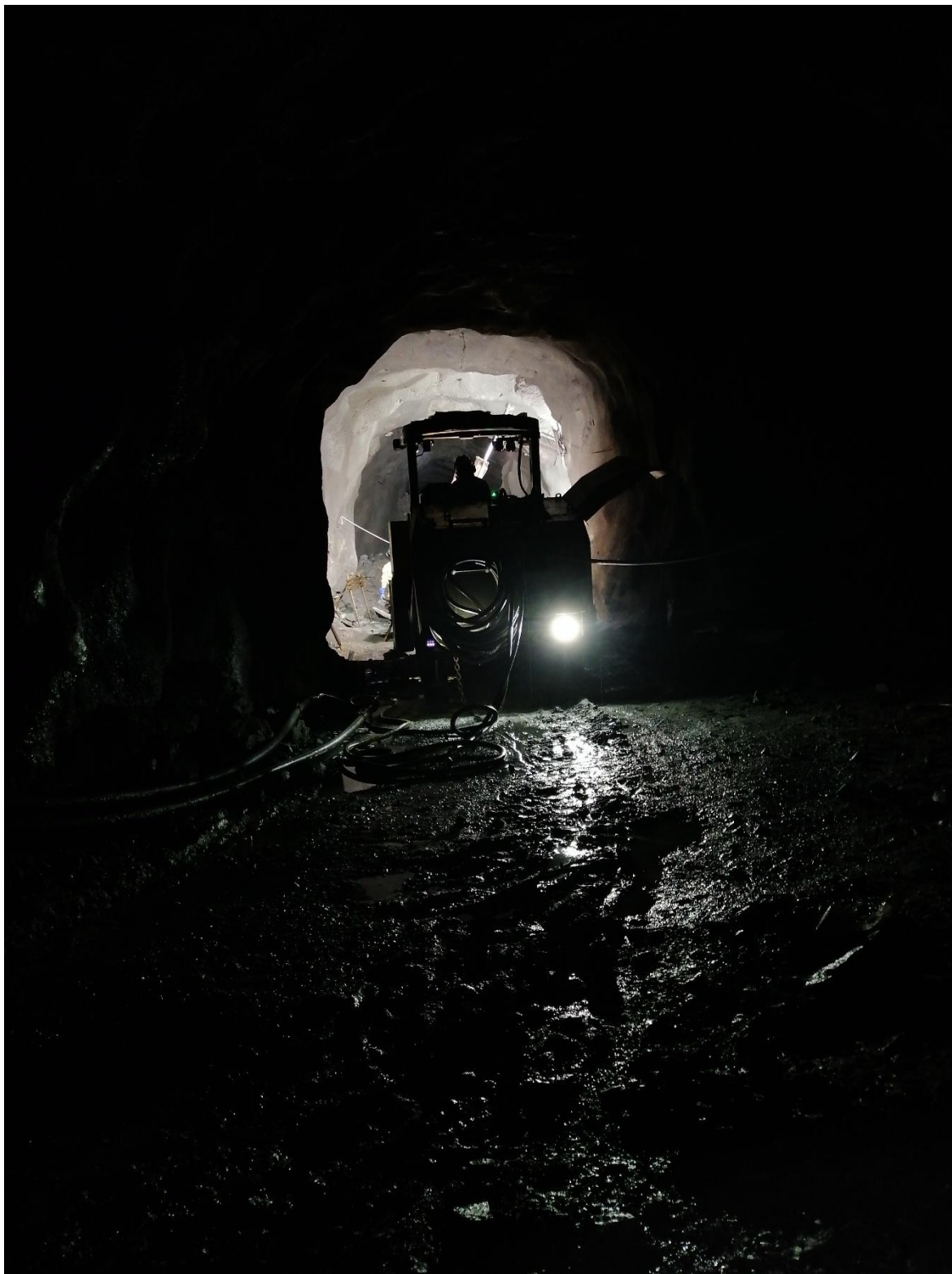
Figura E.1. Perforación de taladros largos con equipo Simba S7
