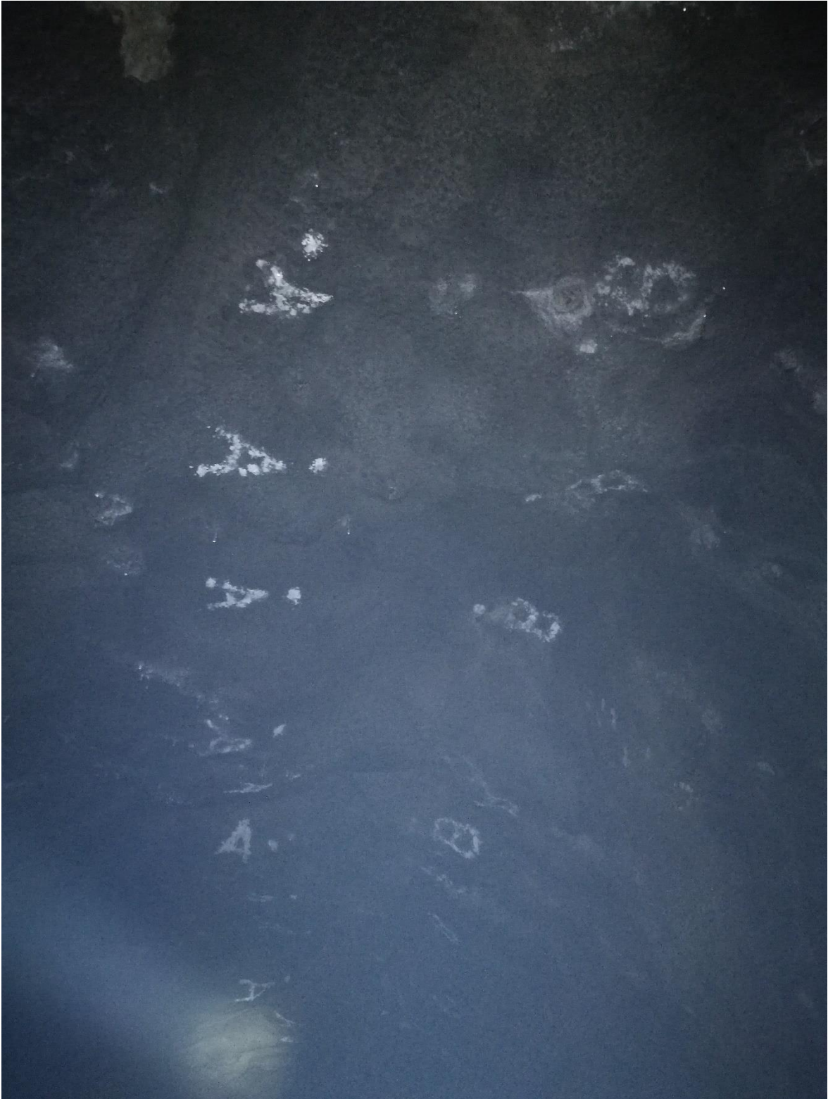
Figura E.4. Secciones en la corona para la perforación con equipo Simba
