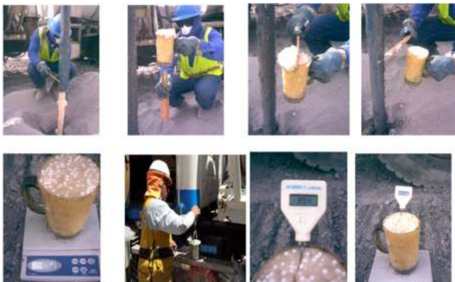
Figura 17 Control de calidad mediante medición de densidades en campo. Fuente: Elaboración propia.
