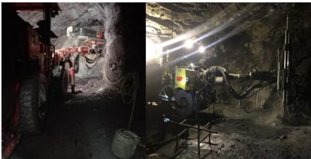
Figura 4,10: Equipo de perforación – Simba S1D Fuente: Elaboración propia
