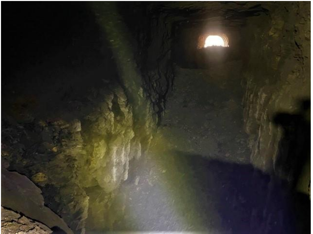
Figura 7,11: Resultado de la voladura Fuente: Elaboración propia
