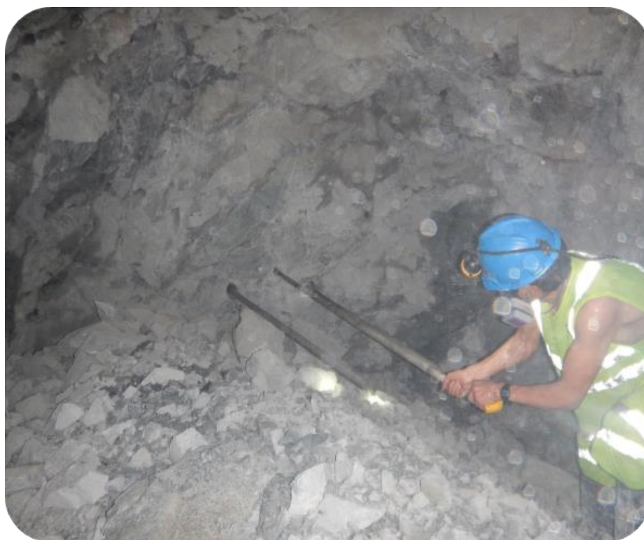
Figura 4,17: Monitoreo de la desviación de los taladros Fuente: Elaboración propia
