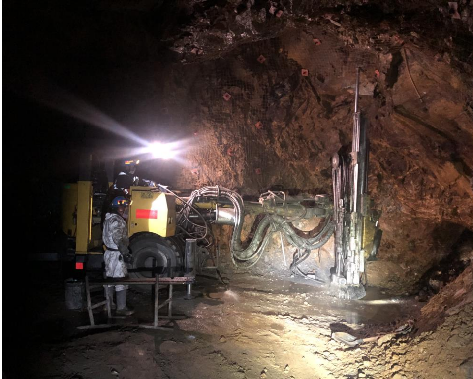
Figura 7,9: Perforación del tajeo 12m – Equipo Simba T1D Epiroc Fuente: Elaboración propia
