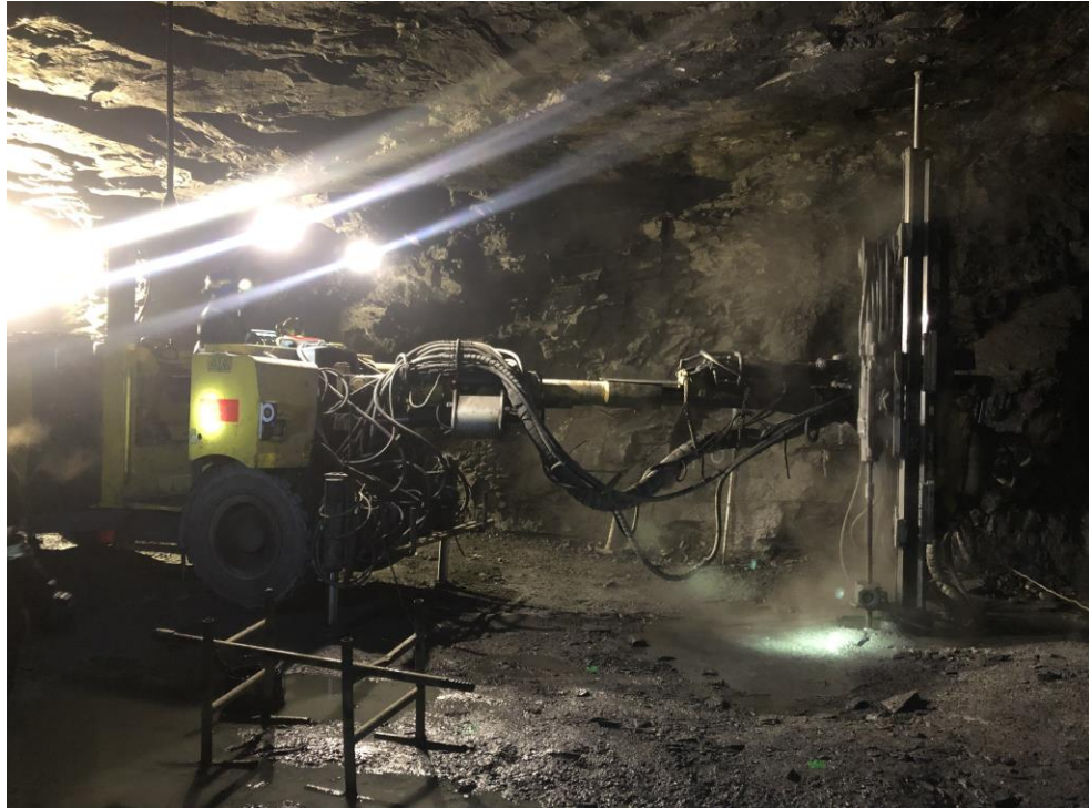
Figura 7,3: Perforación de taladros de tajeo 14' - Equipo Simba T1D Epiroc Fuente: Elaboración propia
