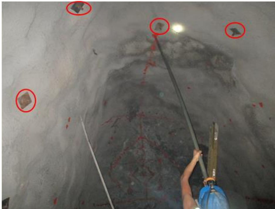
Figura 6,3: Inspección de instalación de pernos Fuente: Elaboración propia
