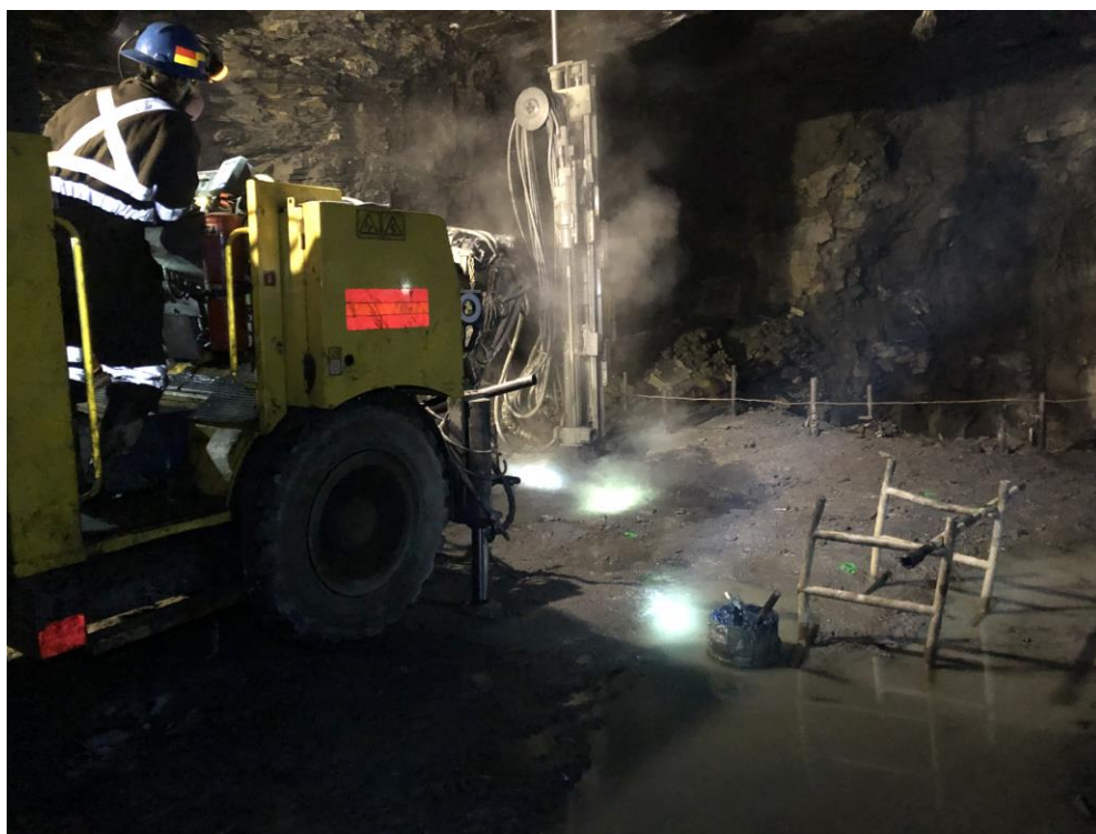
Figura 3,3: Perforación de tajeo – Equipo Simba T1D Epiroc Fuente: Elaboración propia
