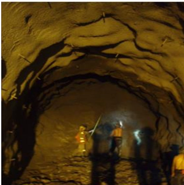
Figura 6,2: Supervisando aplicación de shotcrete
