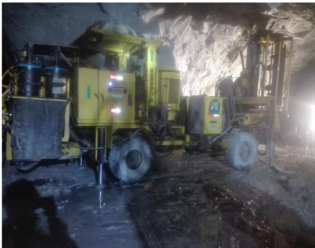
Figura 4,1: Perforación de tajeo – Equipo Simba H 1257 Atlas Copco Fuente: Elaboración propia
