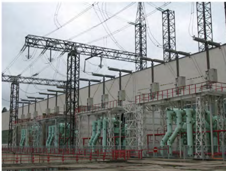
Figura Nº 2.5: Aplicación Interruptor 420 kV-Seccionador
