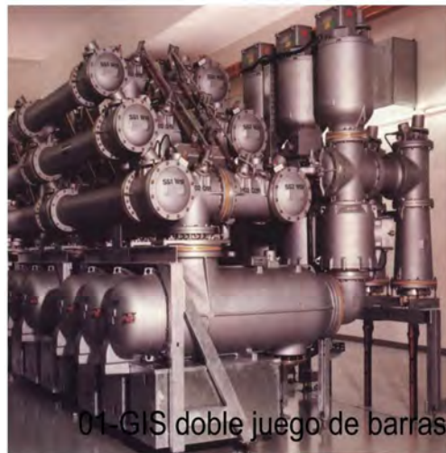
Figura Nº 3.23: Subestación GIS – Doble Barra
