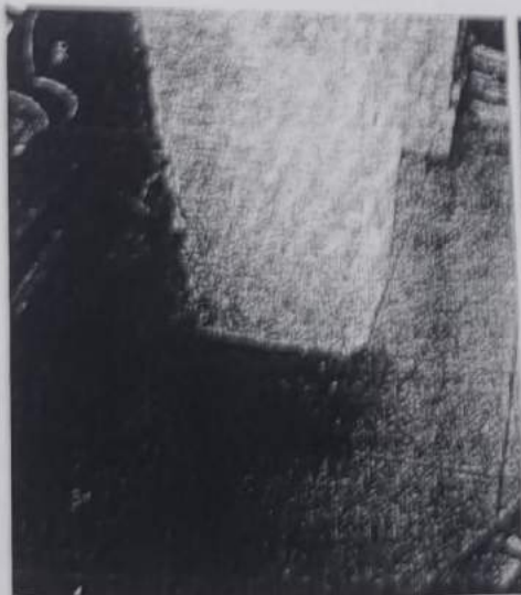
Edificación 3, nótese los signos de un mal procedimiento de encofrado.
