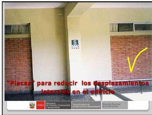
IMAGEN E25. Reforzamiento de columnas para disminuir la fuerza sísmica.
