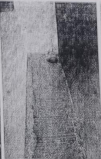
Edificación 3, nótese los signos de un mal procedimiento de encofrado.
