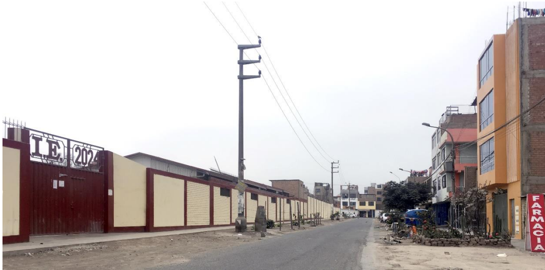
Gráfico N° 5 Vista del Muro opaco, percepción de calles desoladas.
