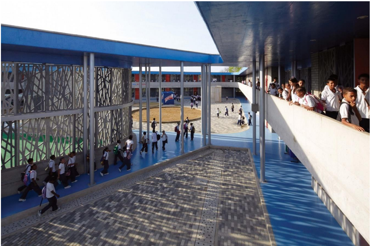
Ilustración 5 Vista interior I. E. For del campo, Colombia Fuente: archdaily.com
