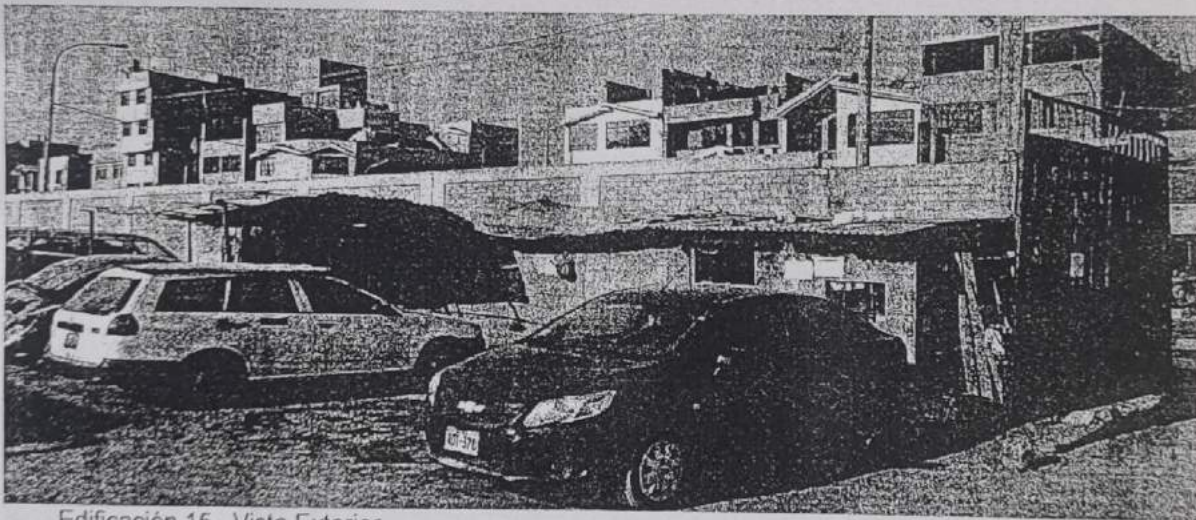
Edificación 15_ Vista Exterior
