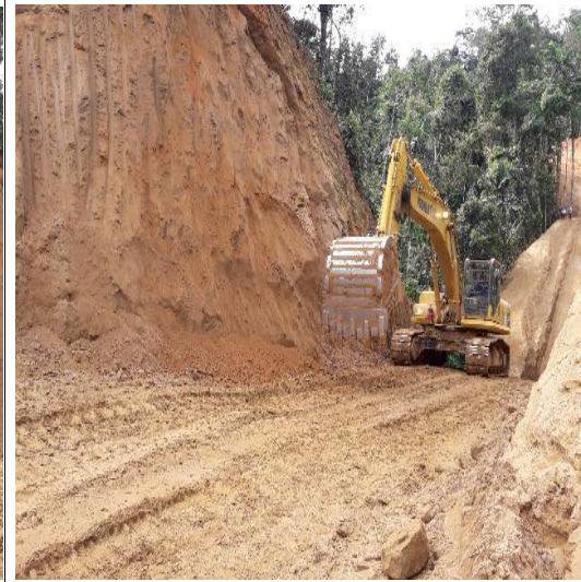
Movimiento y conformación de suelo.
