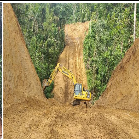
Movimiento y conformación de suelo.
