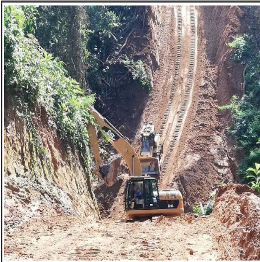
Mantenimiento del DDV.
