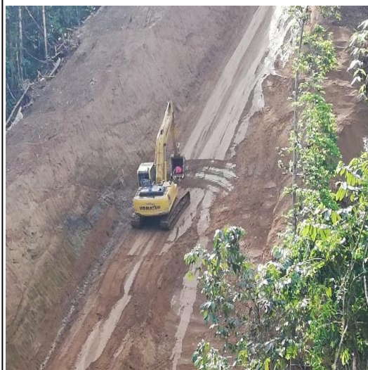
Conformación y compactación del DDV.
