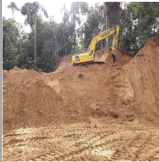
Movimiento y conformación de suelo.
