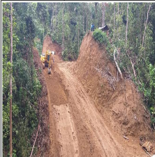
Movimiento y conformación de suelo.
