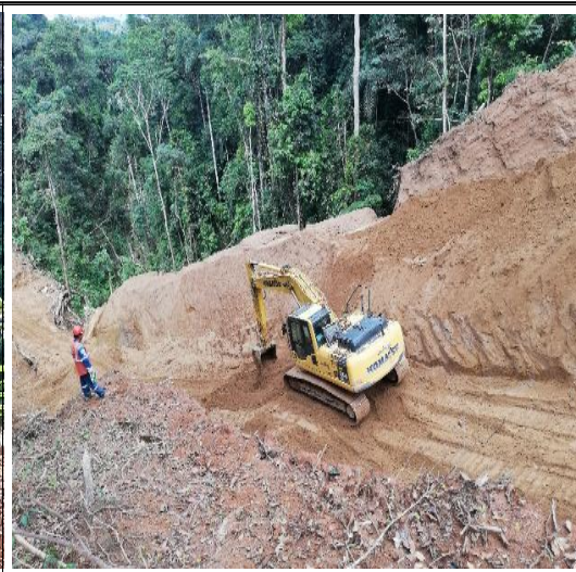
Corte y conformación del DDV.
