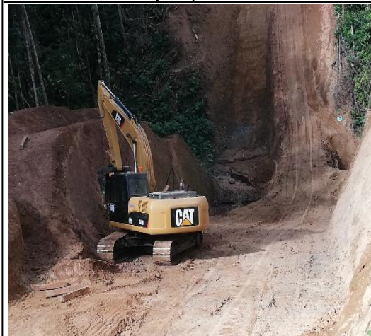
Mantenimiento del DDV.
