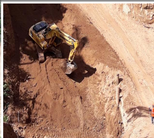
Corte y conformación del DDV.
