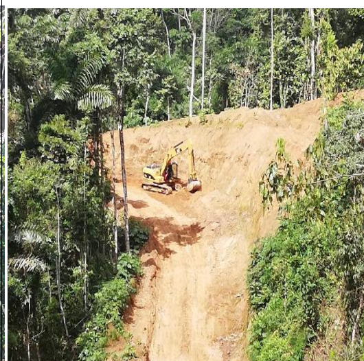
Mantenimiento del DDV.
