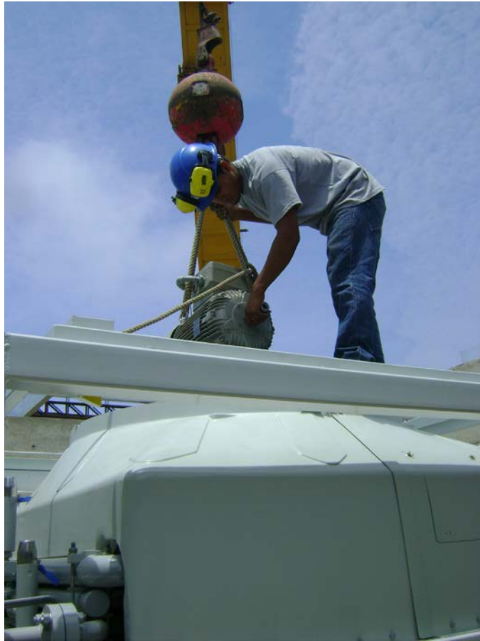
Figura 4.7. Instalación del motor del ventilador.
