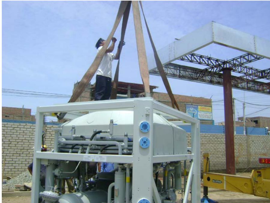
Figura 4.5. Izamiento del compresor.
