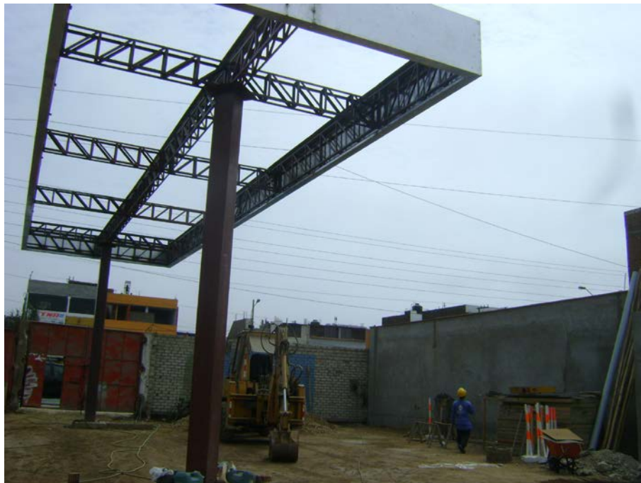
Figura 4.1. Construcción de Grifo de GNV.
