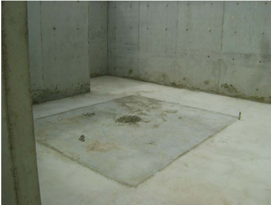
Figura 4.3. La verificación de la plenitud se realiza para este piso donde será ubicado el compresor.
