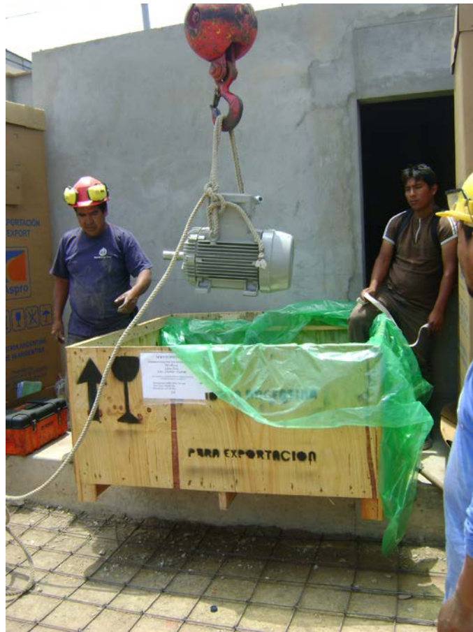
Figura 4.6. Izamiento del motor del ventilador.
