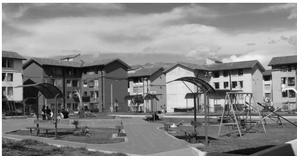
Conjunto habitacional Pachacútec, 1983
