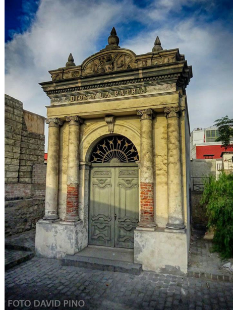
FOTO 9. CAPILLA DE SANTA BÁRBARA
