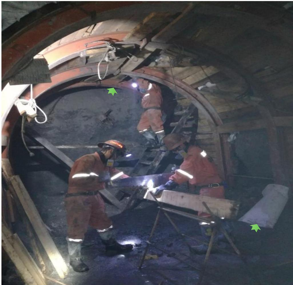
Figura 31 Entablado y empaquetado de corona
