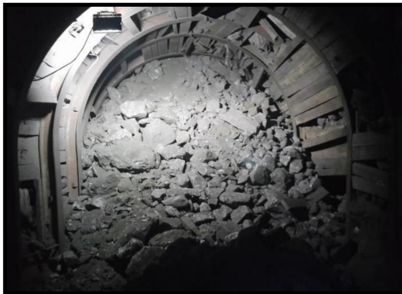
Figura 46 Resultado de la detonación y el Plasteo de Cimbras
