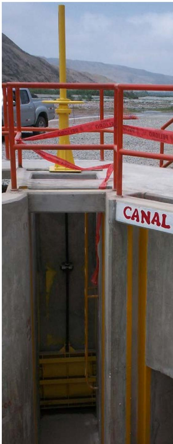
*Figura 3.7* Montaje en obra del sistema de izaje en el canal desripiador.
