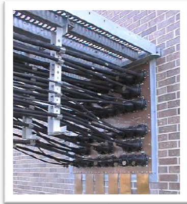
Figura 3.9 Entrada de cables a caseta o cuarto de comunicaciones
