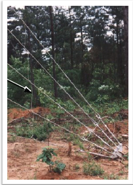
Figura 3.12 Fotografías de Vientos a tierra en Motorola R56
