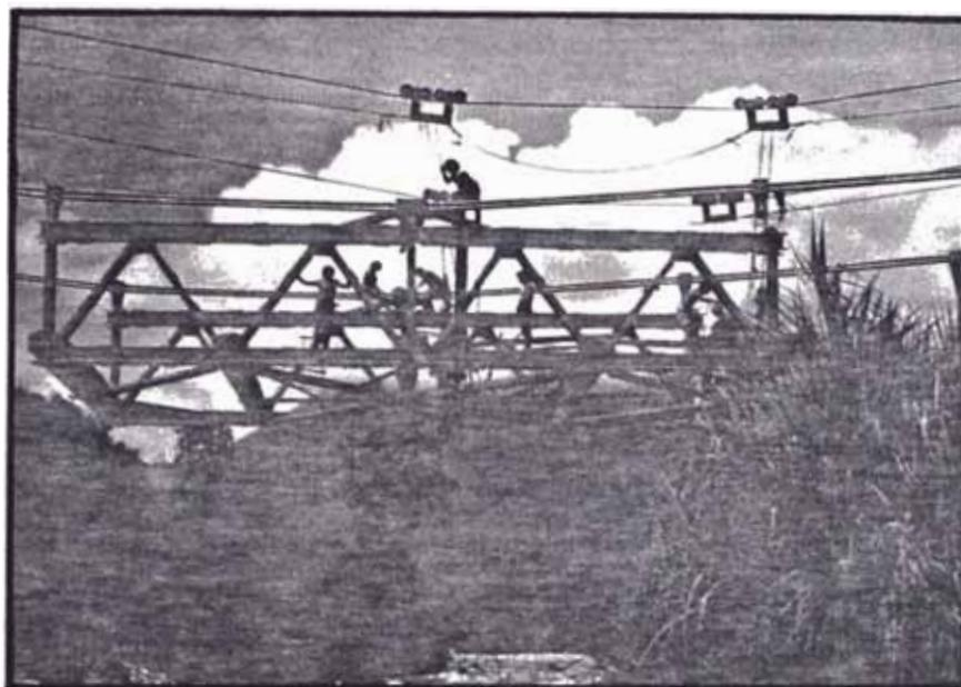
En la Fig. N° 72 se puede observar a la Viga de Rigidez totalmente conformada.
