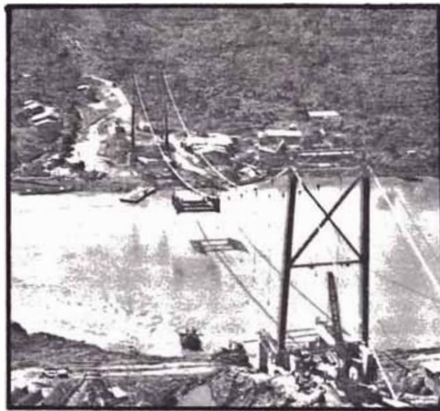
En la Fig. Nº 68 se aprecia el primer "módulo" lanzado.
