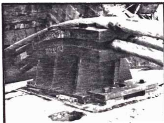
su relativo poco peso permite que su colocaci3n se pueda realizar con suma facilidad solamente con la ayuda de una grúa pequeña 3 con un cargador frontal Para su montaje se deber3 tener especial cuidado en guiarse de las instrucciones dadas por la Waagner Biro (Fig. N3 34), debiendo rechequear tanto el alineamiento as3 como su nivel.
