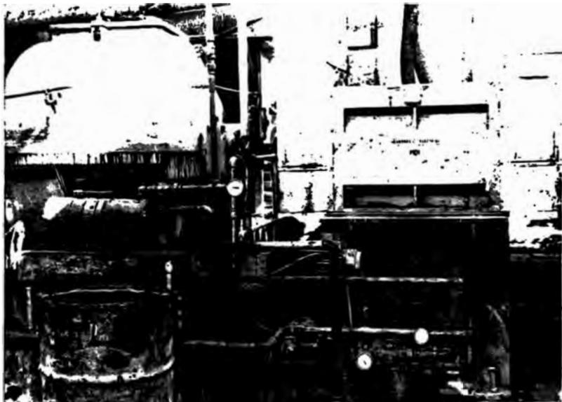
**MOTOR DEL "BAMBURY" DE 500 HP , OBSERVE EL REDUCTOR DE VELOCIDAD Y LOS SISTEMAS DE LUBRICACION**
