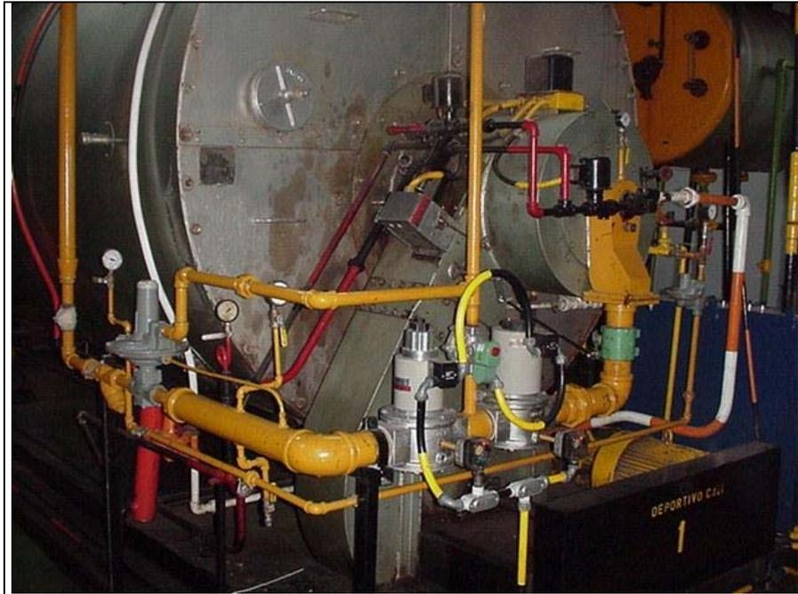
**FIGURA 5.4: Tren de Válvulas**
