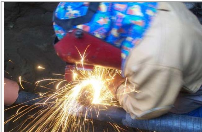
**FIGURA 2.12: Soldadura en zanja para Tubería de Conexión**
