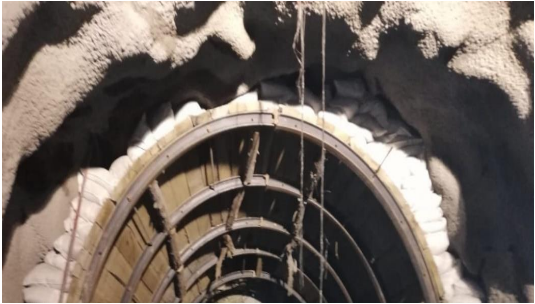
Figura 2,19 Sostenimiento con shotcrete Fuente: Elaboración propia
