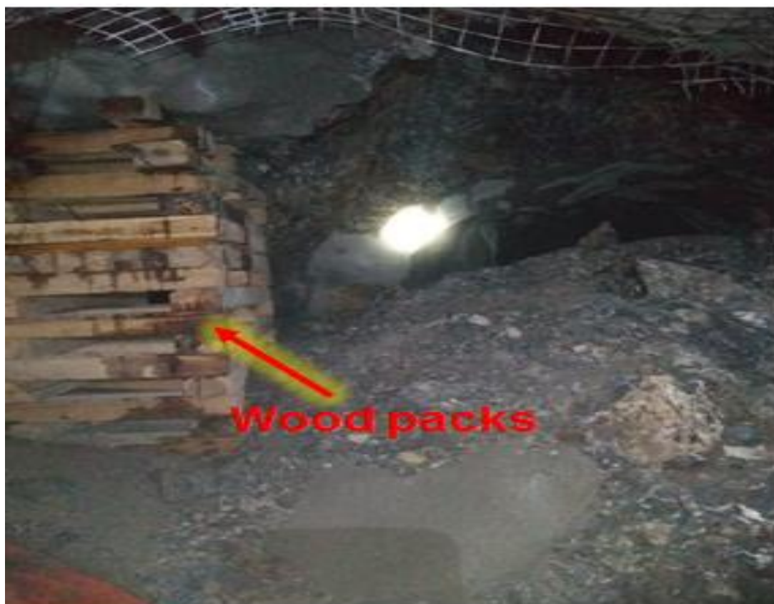
Figura 2,15 Sostenimiento con Wood packs Fuente: Elaboración propia
