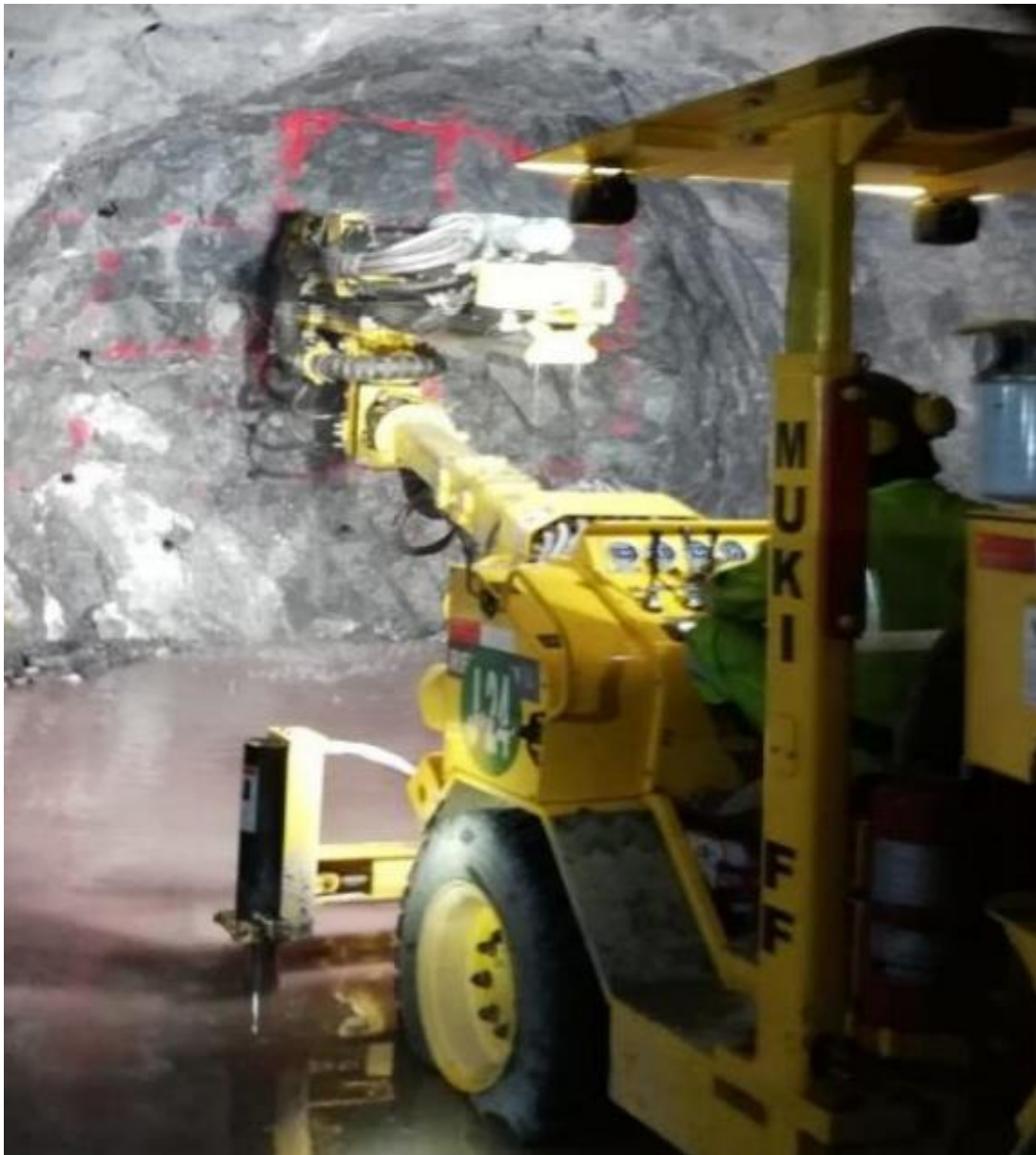
Figura 3,6 Perforación con jumbo de perforación frontal para vetas angostas Fuente: Elaboración propia
