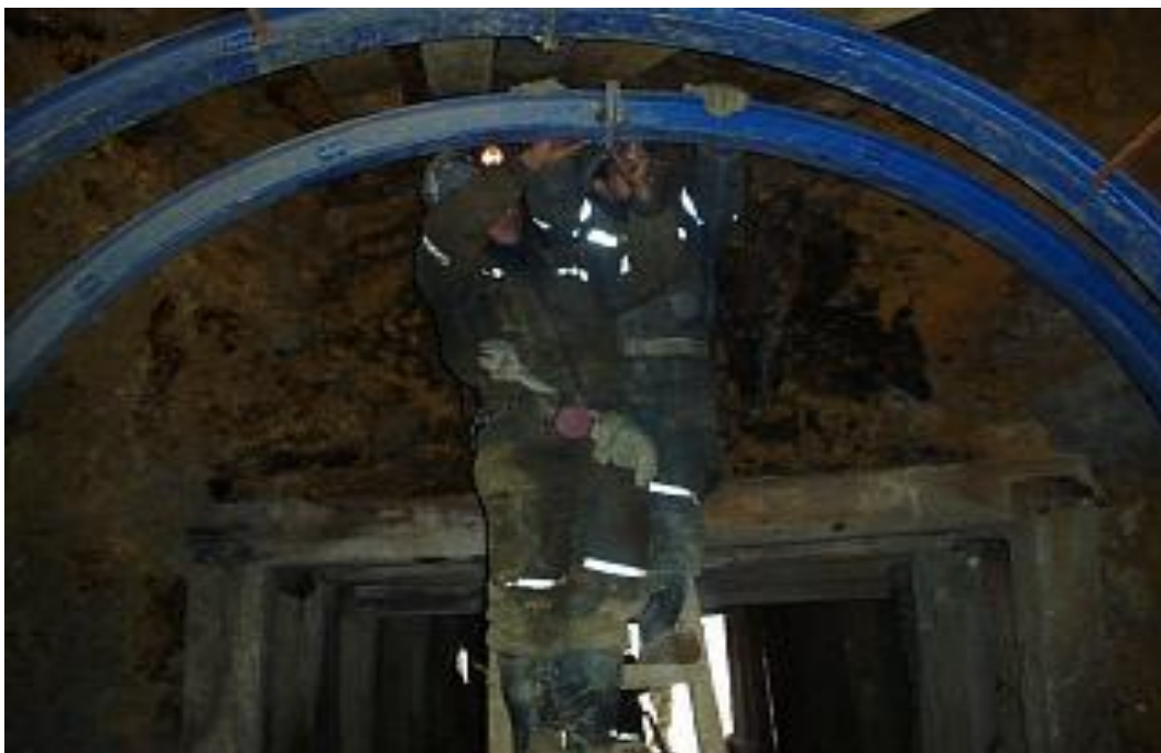
Figura 2,14 Instalación de cimbras Fuente: Elaboración propia
