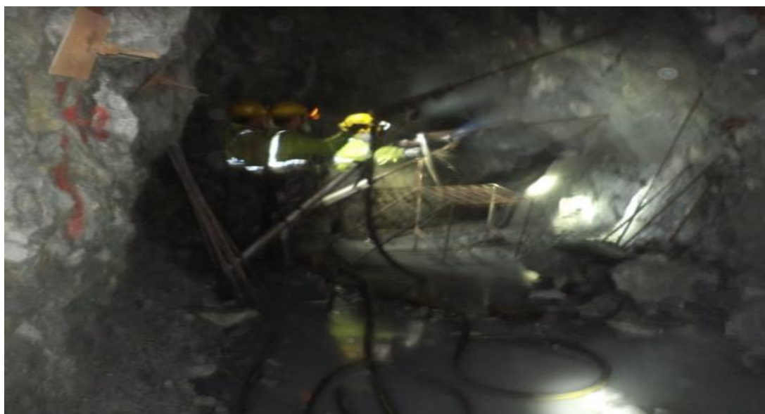
Figura 2,18 Sostenimiento convencional Fuente: Elaboración propia
