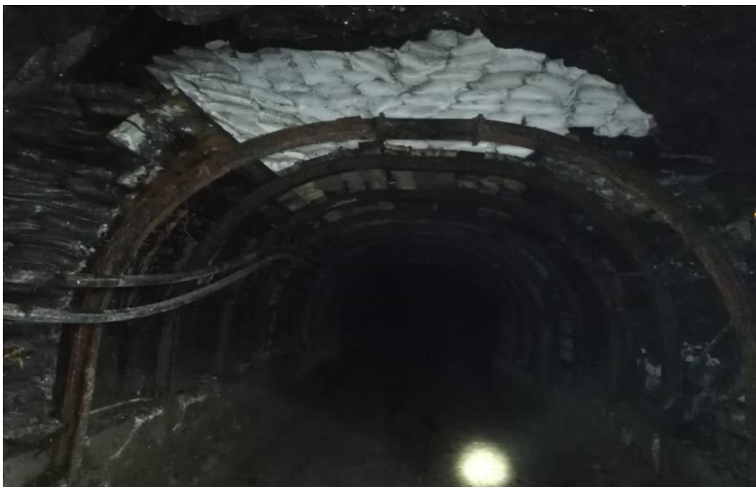
Figura 2,16 Sostenimiento con Cimbras. Fuente: Elaboración propia
