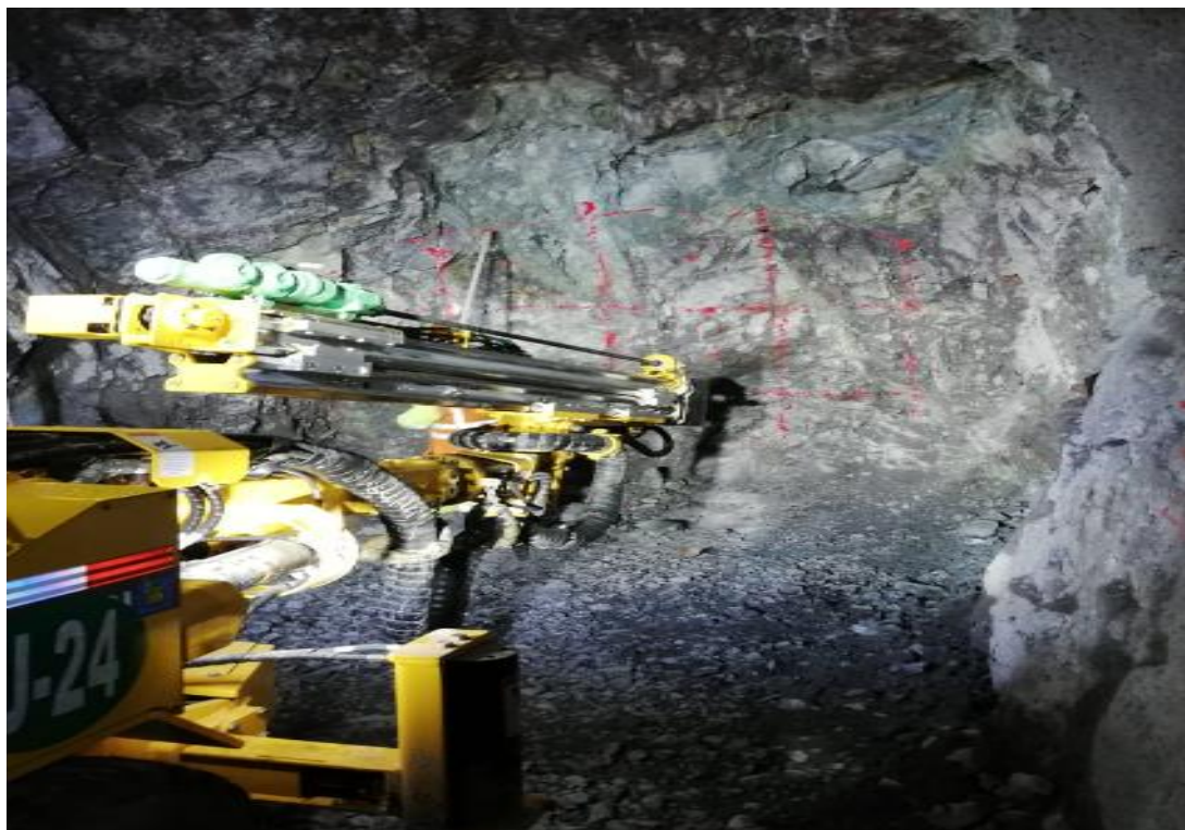
Figura 2,1 Perforación con jumbo Fuente: Elaboración propia
