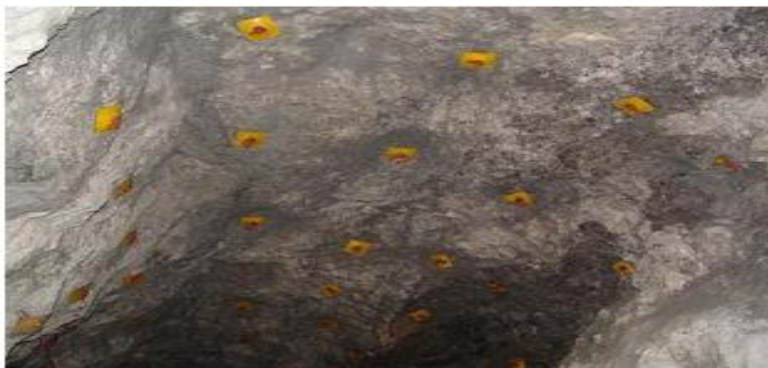
Figura 2,13 Sostenimiento con pernos Fuente: Elaboración propia
