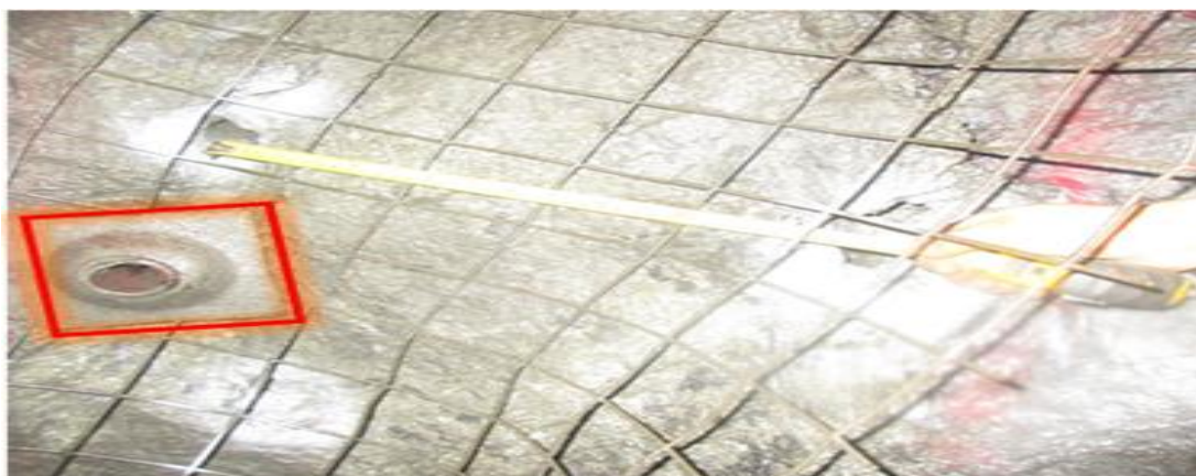
Figura 2,17 Sostenimiento con split set y mallas Fuente: Elaboración propia
