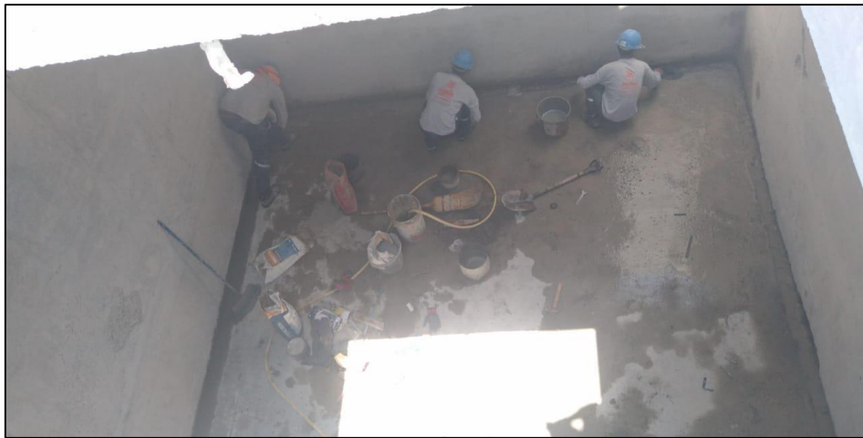
Figura 4.2.19. Impermeabilizado interior de cámaras de bombeo. Fuente: Elaboración propia.
