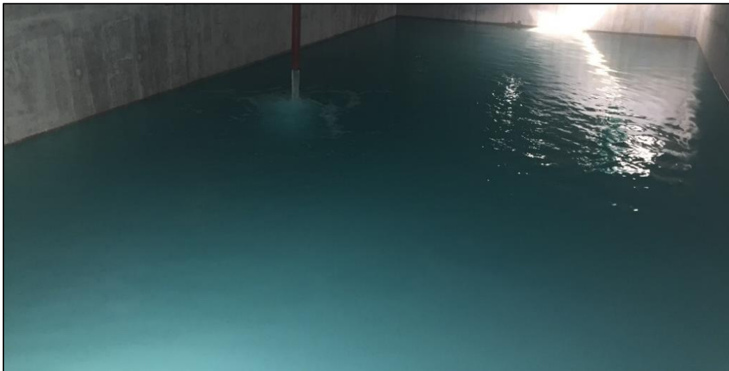
Figura 4.1.30. Llenado de tanque equalizador para prueba de estanqueidad. Fuente: Elaboración propia.
