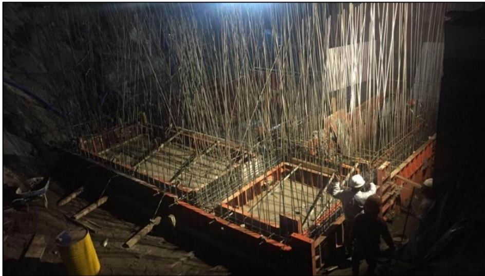
Figura 4.2.6. Encofrado de cimentación de cámaras de bombeo. Fuente: Elaboración propia.
