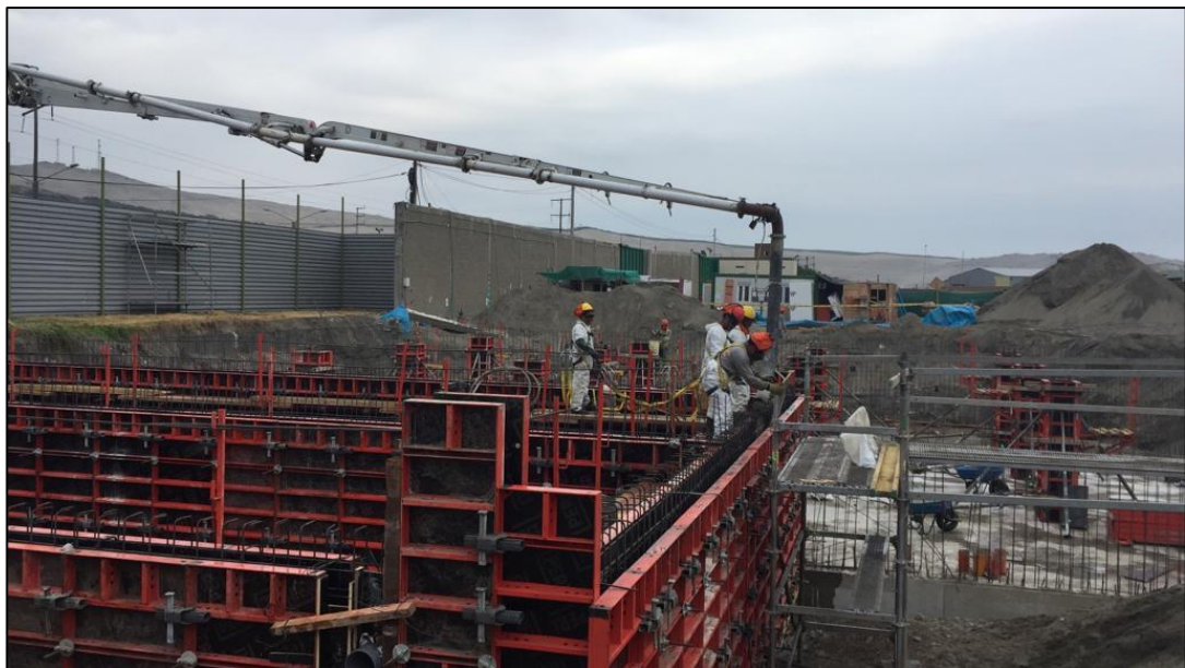
Figura 4.1.19.1. Vaciado de concreto premezclado en muros de tanque equalizador, nótese la posición vertical de la punta de la manguera para el vertido de la mezcla.
