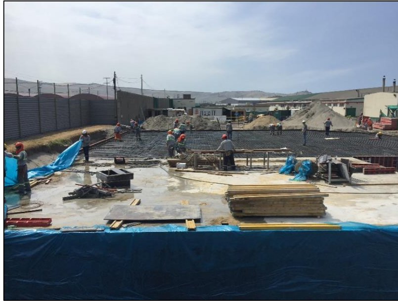
Figura 4.1.27. Curado de losa de techo del tanque equalizador, nótese el agua sobre la superficie de la losa. Fuente: Elaboración propia.
