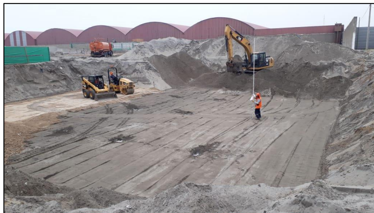
Figura 4.1.6.1. Relleno y compactación de plataforma de terreno natural y material propio. Fuente: Elaboración propia.
