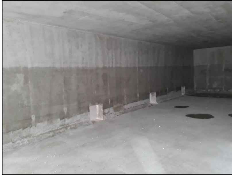
Figura 4.1.29. Interior del tanque equalizador con impermeabilización. Fuente: Elaboración propia.
