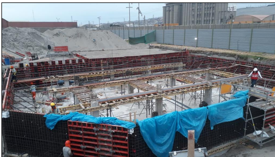
Figura 4.1.22. Proceso de encofrado de vigas en cisterna de agua tratada. Fuente: Elaboración propia.
