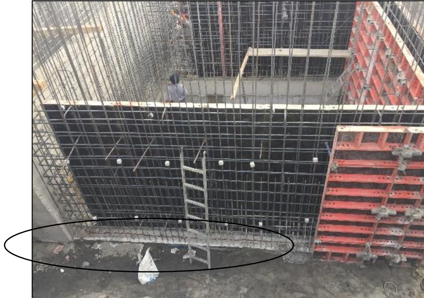
Figura 4.2.10. Sello hidroexpansivo colocado entre el encuentro de la losa de cimentación y la base del muro de cámara de bombeo.
