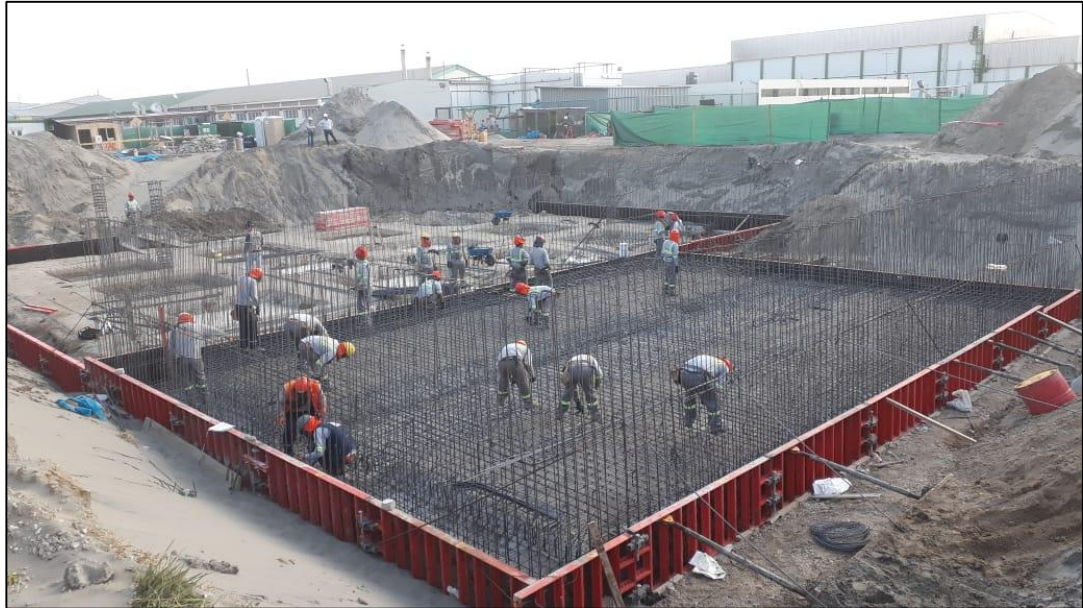
Figura 4.1.9.4. Armado de acero de losa de cimentación en el tanque equalizador. Fuente: Elaboración propia.
