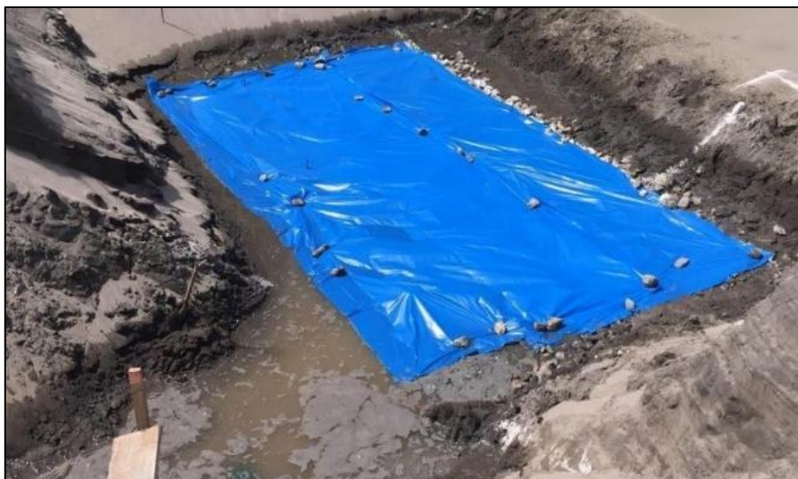
Figura 4.2.3.1. Colocación de cama filtrante por material granular y plástico. Fuente: Elaboración propia
