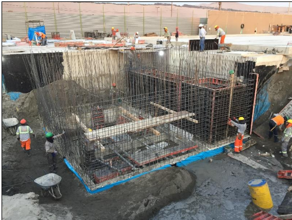
Figura 4.2.9. Armado de acero en muros de cámaras de bombeo, nótese la presencia de aguas del nivel freático.
