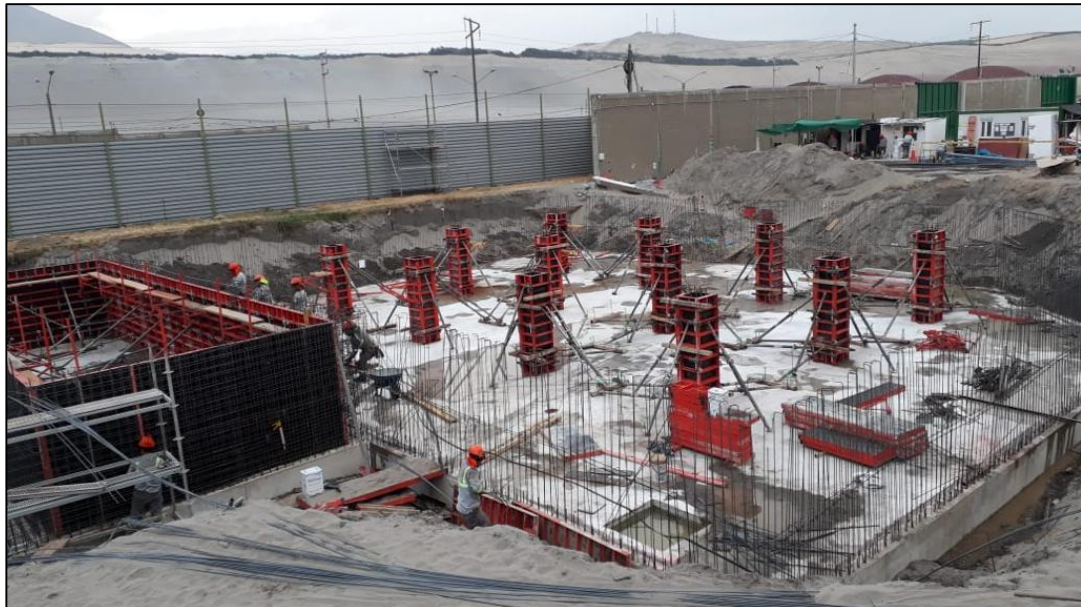
Figura 4.1.18.3. Encofrado de columnas centrales en cisterna de agua tratada. Fuente: Elaboración propia.
