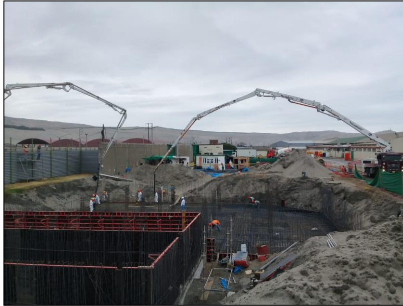
Figura 4.1.11.2. Vaciado de losa de cimentación de cisterna de agua tratada. Fuente: Elaboración propia.
