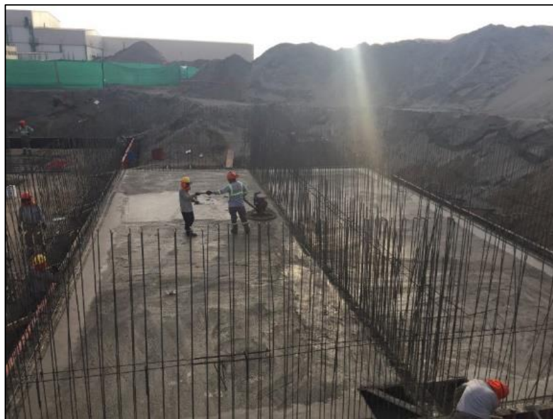
Figura 4.1.12.1. Acabado de losa de piso en tanque equalizador con alisadora. Fuente: Elaboración propia.
