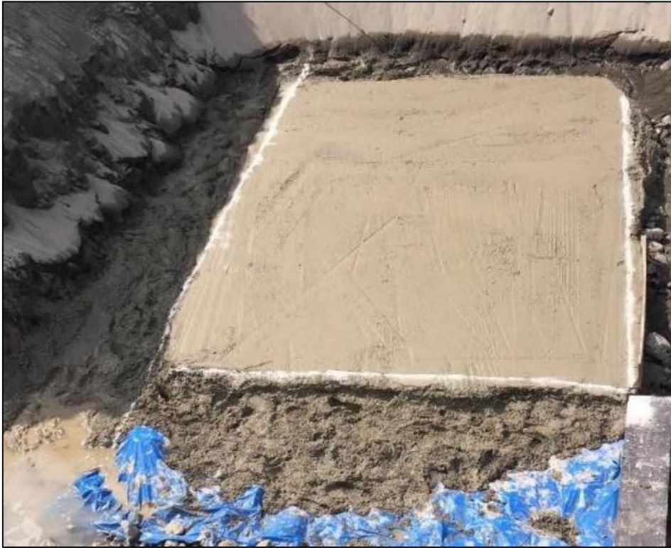
Figura 4.2.3.2. Vaciado de solado sobre la cama de roca y plástico. Fuente: Elaboración propia
