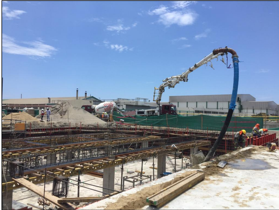
Figura 4.1.19.2. Vaciado de concreto premezclado en muros de cisterna de agua tratada, mediante camión mixer y bomba pluma. Fuente: Elaboración propia.
