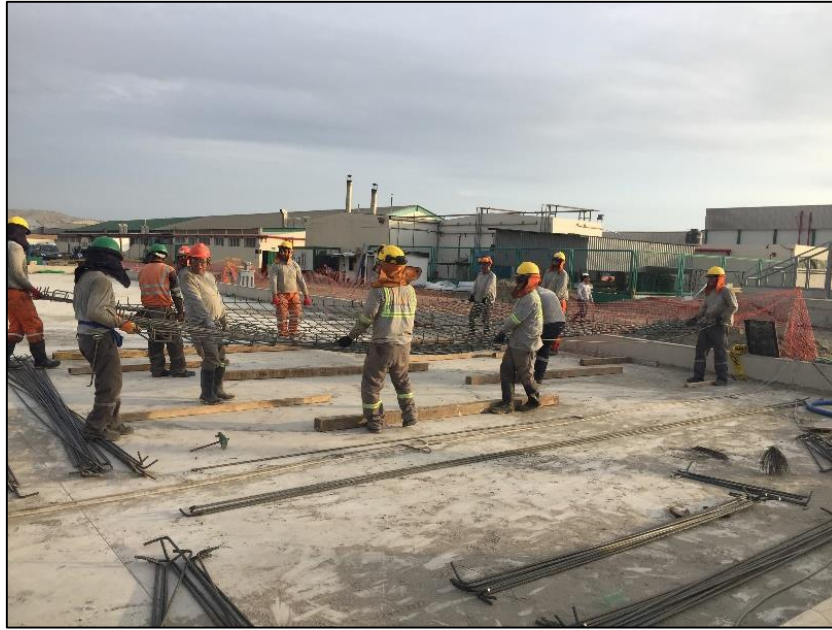
Figura 4.2.15. Armado de la malla inferior de la losa de las cámaras de bombeo. Fuente: Elaboración propia.
