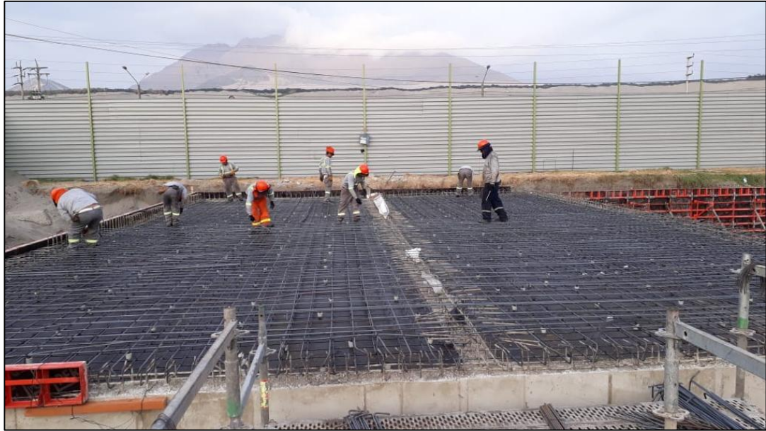
Figura 4.1.23.2. Colocación de acero en losa de techo de tanque equalizador. Fuente: Elaboración propia.
