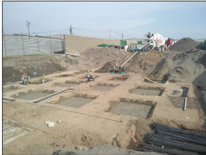
Figura 4.1.8. Vaciado de solados para uñas de cimentación y zapata de columnas centrales en cisterna de agua tratada. Fuente: Elaboración propia.
