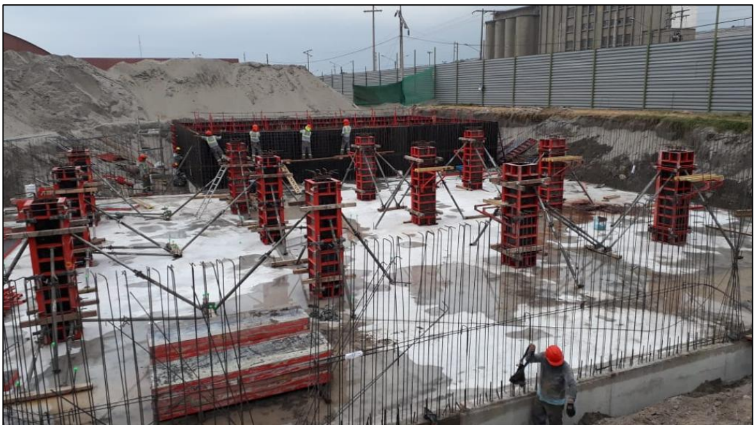
Figura 4.1.13. Losa de cisterna de agua tratada con pequeños charcos de agua debido al curado constante del elemento. Fuente: Elaboración propia.
