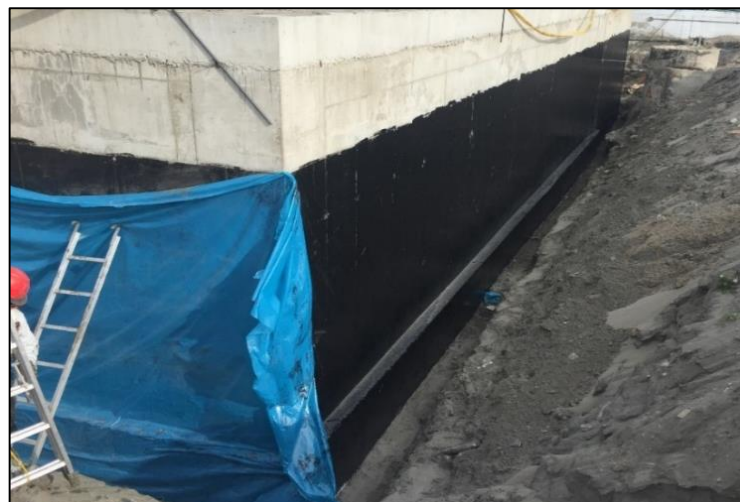
Figura 4.1.28. Impermeabilización exterior del tanque equalizador. Fuente: Elaboración propia.
