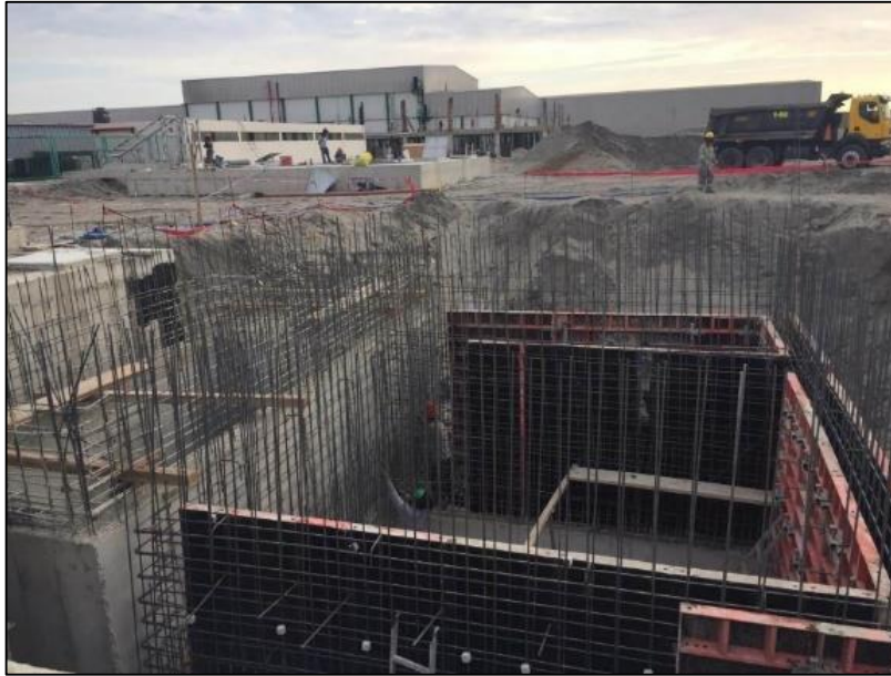
Figura 4.2.11. Encofrado de muros de cámaras de bombeo de agua residual y su caudalímetro. Fuente: Elaboración propia.
