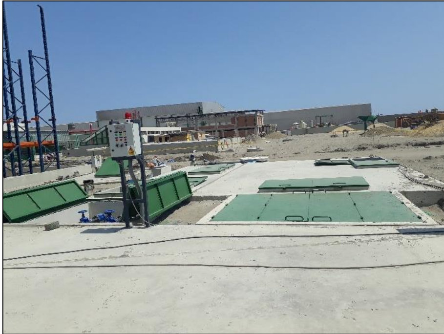
Figura 4.2.21. Vista de las cámaras de bombeo a nivel de suelo posterior al relleno. Fuente: Elaboración propia.
