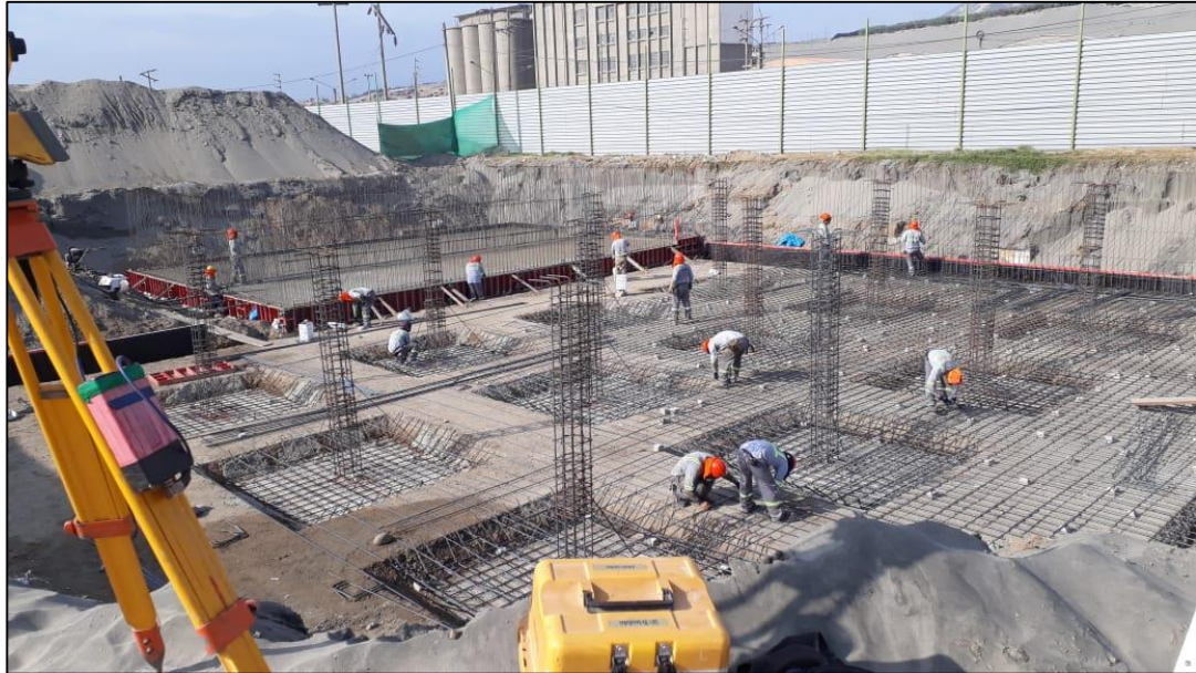
Figura 4.1.9.2. Armado de losa de cimentación en cisterna de agua tratada. Fuente: Elaboración propia.
