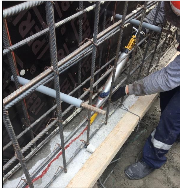
Figura 4.1.16. Colocación de sello hidroexpansivo SikaSwell@S-2 en muro de cisterna de agua tratada. Fuente: Elaboración propia.
