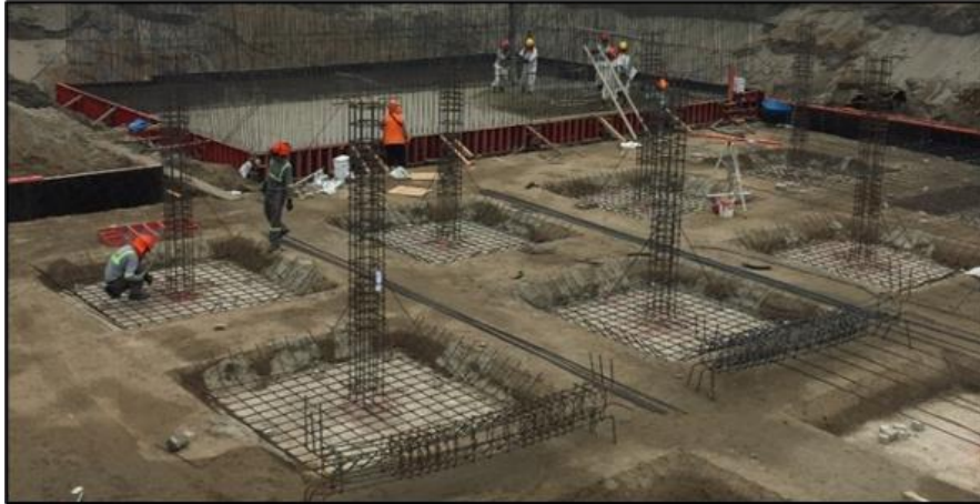
Figura 4.1.15. Colocación de acero corrugado en columnas centrales de cisterna de agua tratada.
