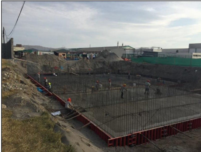
Figura 4.1.14. Colocación de acero corrugado en muros de cisterna de agua tratada y tanque ecualizador.
