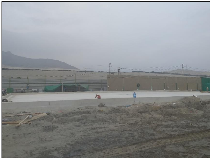
Figura 4.1.32. Vista de la cisterna de agua tratada a nivel de suelo posterior al relleno. Fuente: Elaboración propia.
