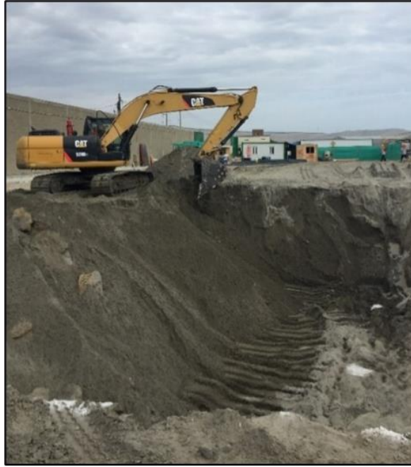
Figura 4.1.3. Excavación masiva de la cisterna de agua tratada de 100 m 3 . Fuente: Elaboración propia.
