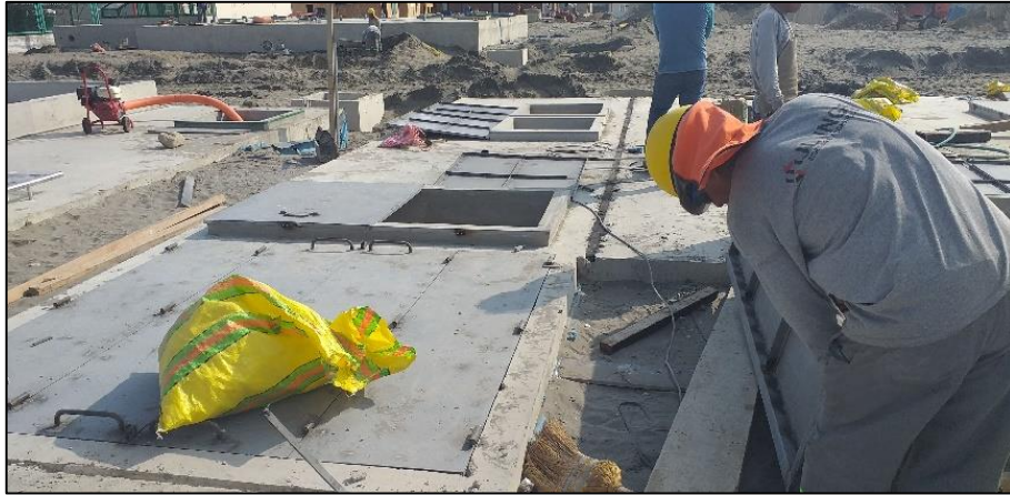
Figura 4.2.22. Instalación de tapas metálicas de inspección en cámaras de bombeo. Fuente: Elaboración propia.
