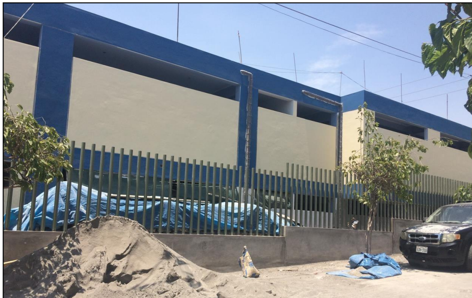
Figura N° IV.27 Pintado de fachada e instalación de cerco perimétrico.
