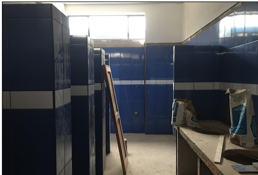
Figura N° IV.29 Instalación de mayólicas en baños.
