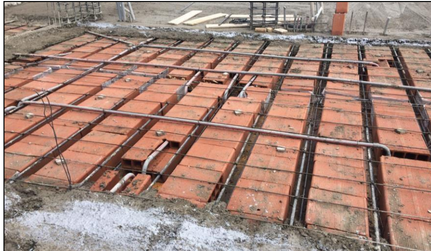
Figura N° IV.24 Instalación de tuberías dentro de losa.
