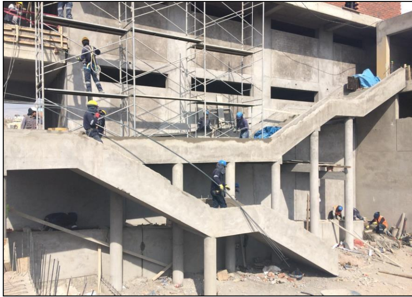
Figura N° IV.26 Encofrado y colocación de acero de escalera y losa.
