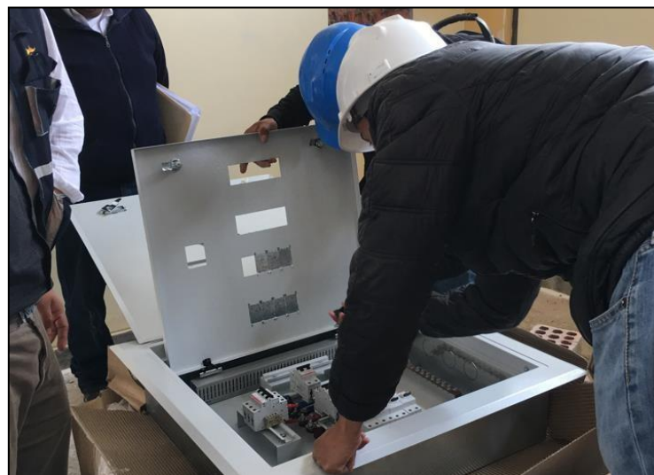
Figura N° IV.31 Revisión de tablero.
