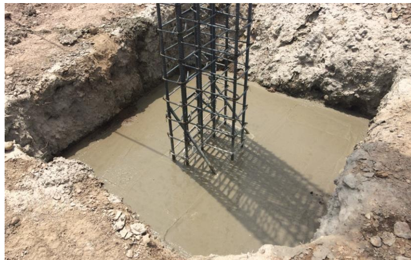
Figura N° IV.5 Control de acero y concreto en zapata.
