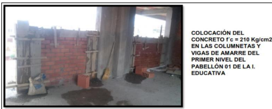
Figura N° IV.15 Control de concreto en columnetas y vigas de amarre.
