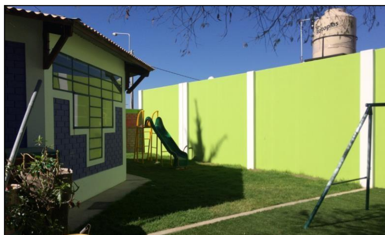
Figura N° IV.18 Control de acabados en el área del Inicial.
