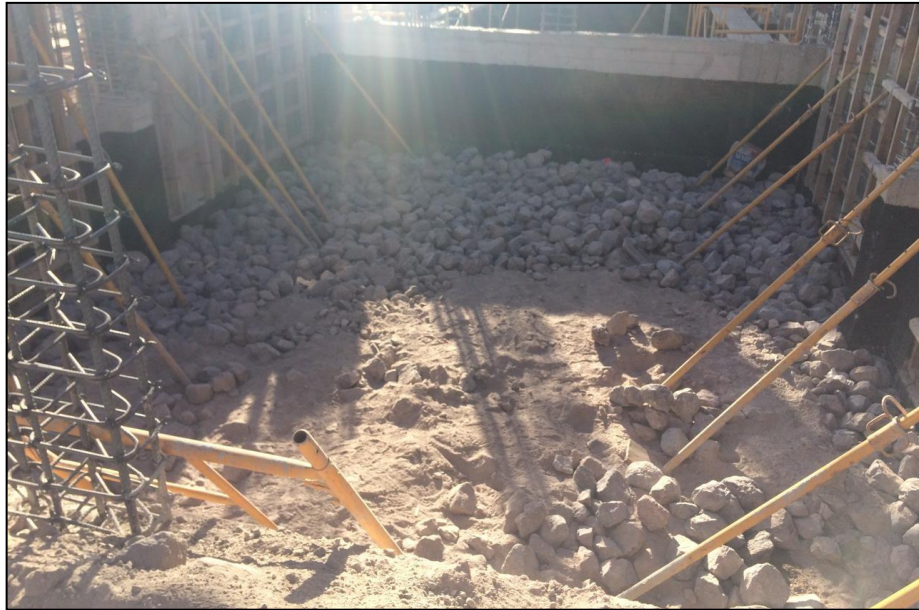
Figura N° IV.23 Control de colocación de acero y encofrado.
