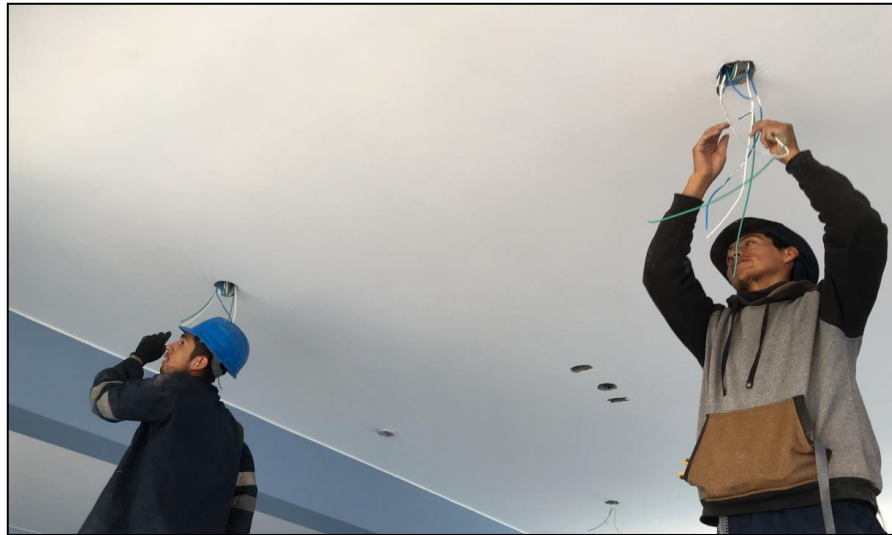
Figura N° IV.30 Instalación cables eléctricos.
