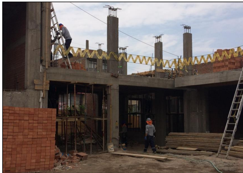
Figura N° IV.11 Control de traslado de materiales en obra.
