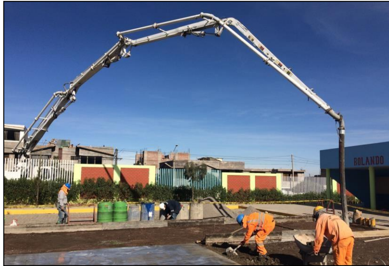
Figura N° IV.2 Control del vertimiento de concreto a losa.
