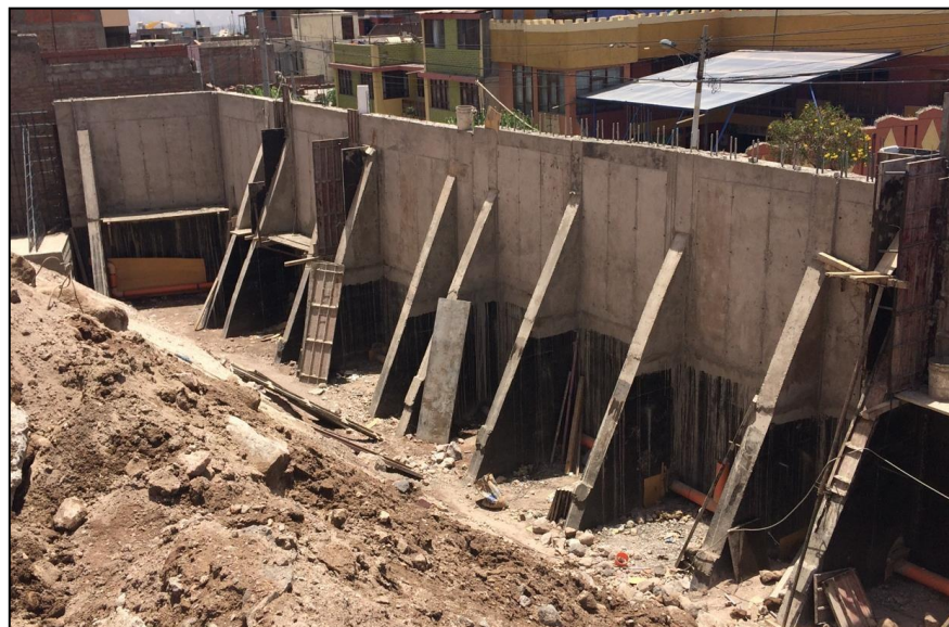
Figura N° IV.9 Control de desencofrado de muros de concreto.
