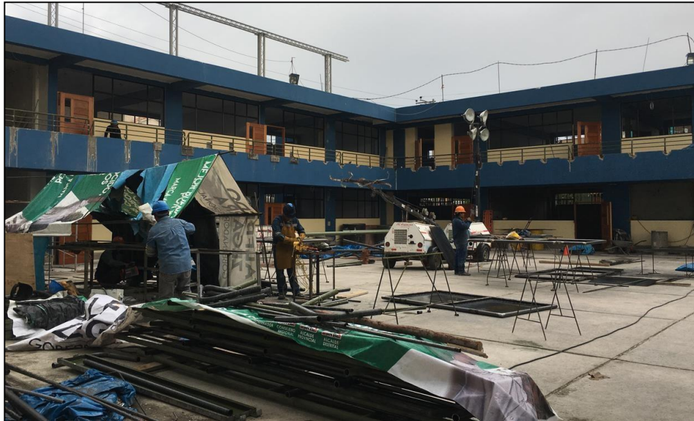
Figura N° IV.28 Instalación de puertas y ventanas.
