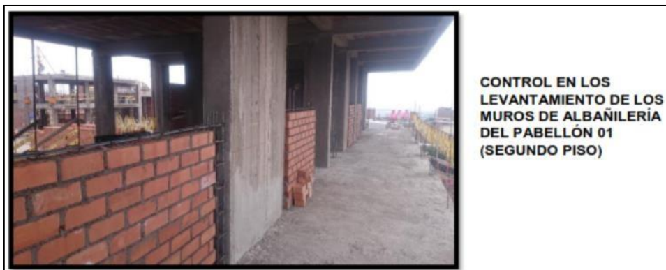
Figura N° IV.14 Control en el levantamiento de muros de albañilería.
