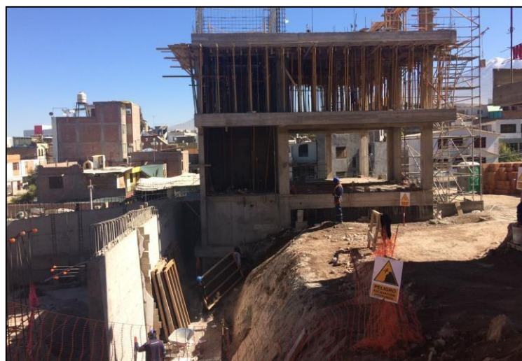
Figura N° IV.21 Control post vaciado de concreto.
