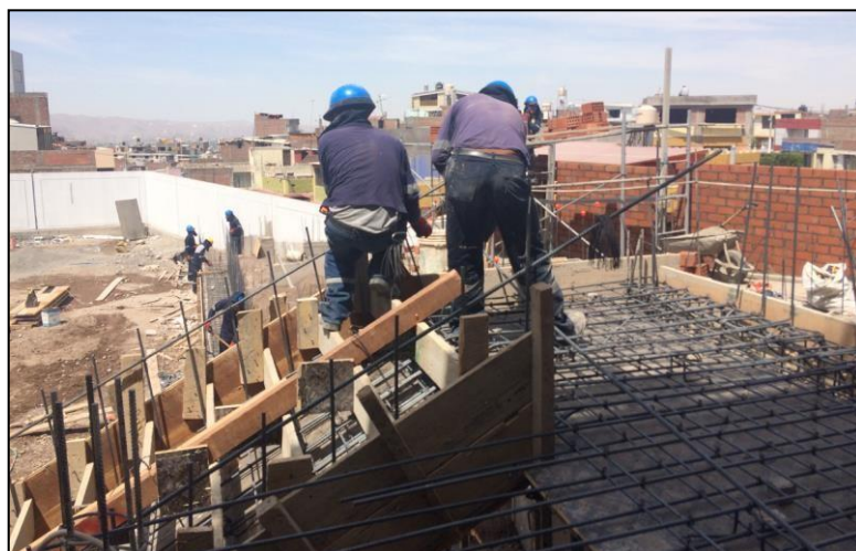
Figura N° IV.25 Encofrado y colocación de acero de escalera y losa.
