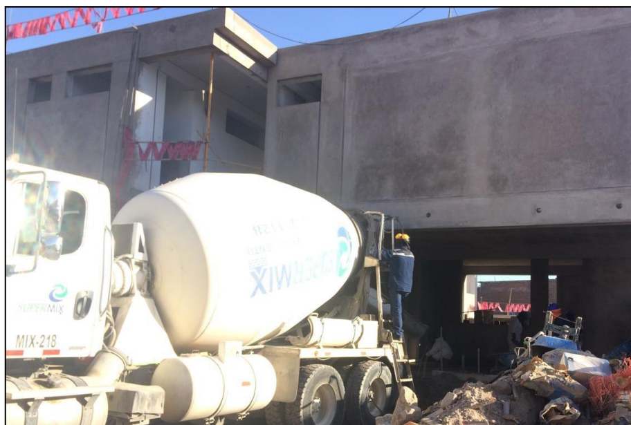
Figura N° IV.22 Control de vaciado de concreto desde un mixer en obra.
