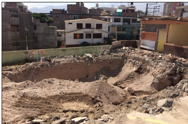
Figura N° IV.3 Control de movimiento de tierras: excavaciones.
