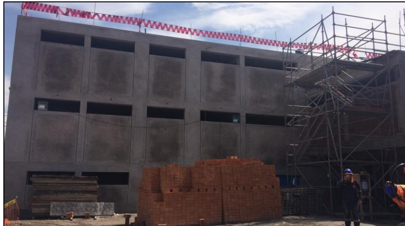
Figura N° IV.17 Control de la estructura al término de los vaciados de concreto.
