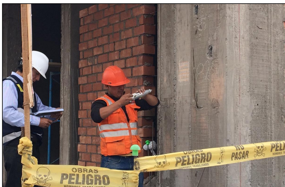
Figura N° IV.13 Ensayo de esclerómetro en muro de concreto.
