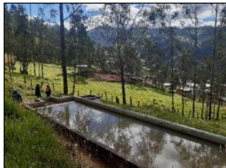
b. Pre-sedimentador
