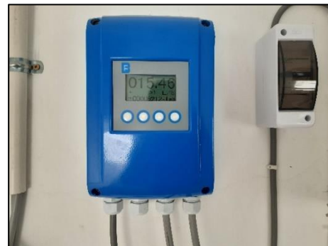
b. Macromedidor de salida
