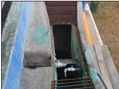
c. Unidad de mezcla rápida
