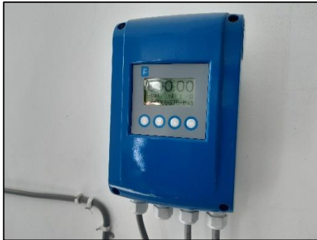
c. Macromedidor en I. impulsión
