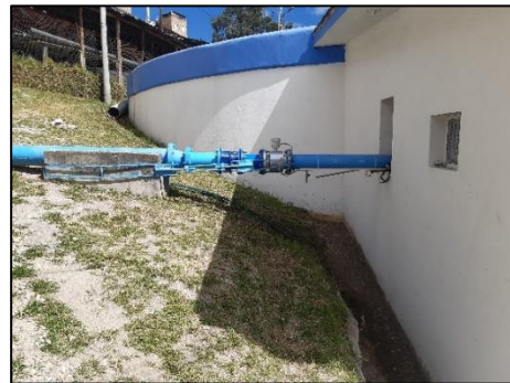
d. Salida con macromedidor
