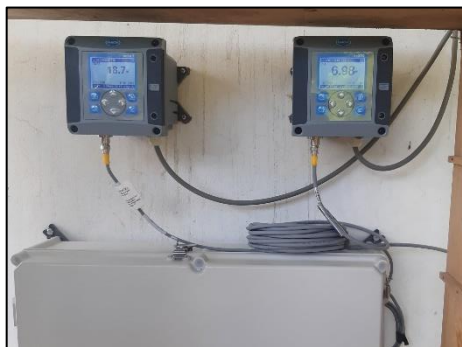
a. Monitoreo en línea de pH y turbidez
