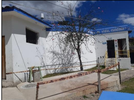
a. Vista de reservorio R-1
