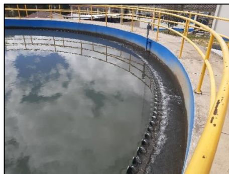
b. Pre-sedimentador
