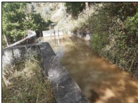
a. Captación Tayca
