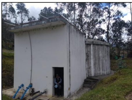
Imagen N° 34: Fotografía del reservorio de agua de San Miguel. Estudio Tarifario de EPS SEDACAJ S.A. para el periodo 2019 – 2024 (2019).
