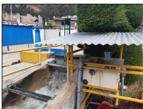
c. Unidad de mezcla rápida
