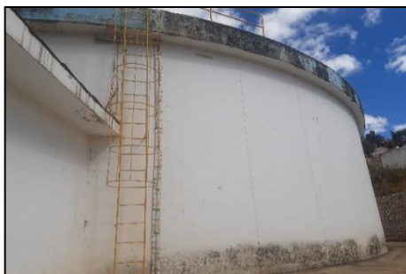
a. Vista de reservorio R-2
