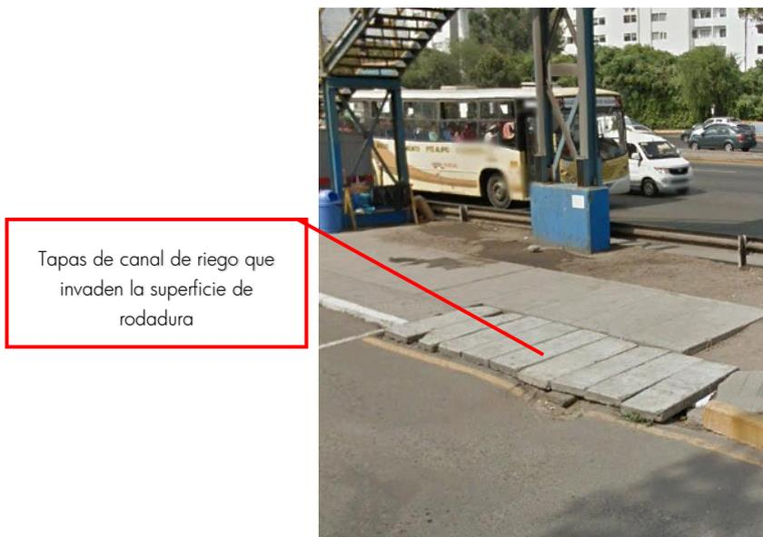
Fotografía 3. Tapas de canal de riego que invaden el pavimento (fuente google Earth).
