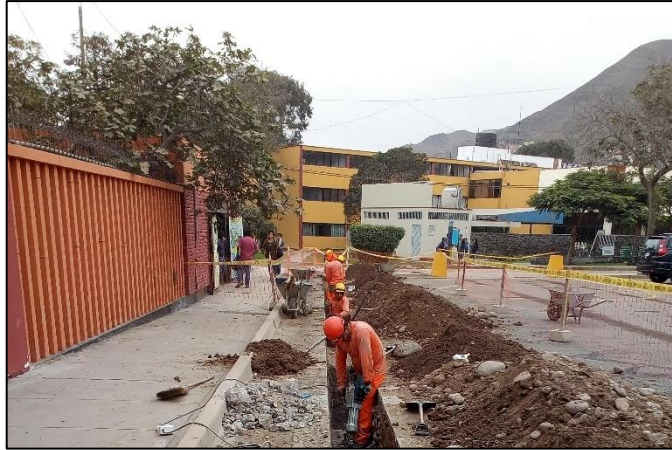
Figura 5.7: Excavación de zanja - red secundaria facultad de Ingeniería Civil.
