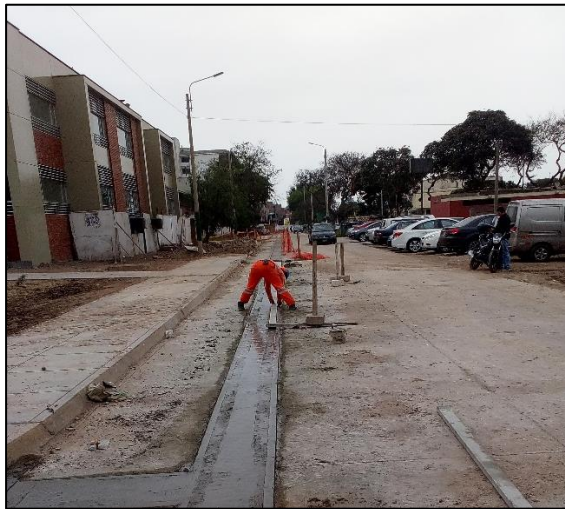
Figura 5.6: Reparación de pista - red primaria de facultad de Ing. Eléctrica Electrónica.
