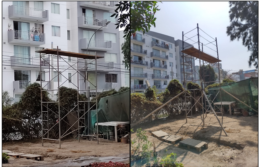
Figura 4.12 Estructura de soporte del sistema sifónico
