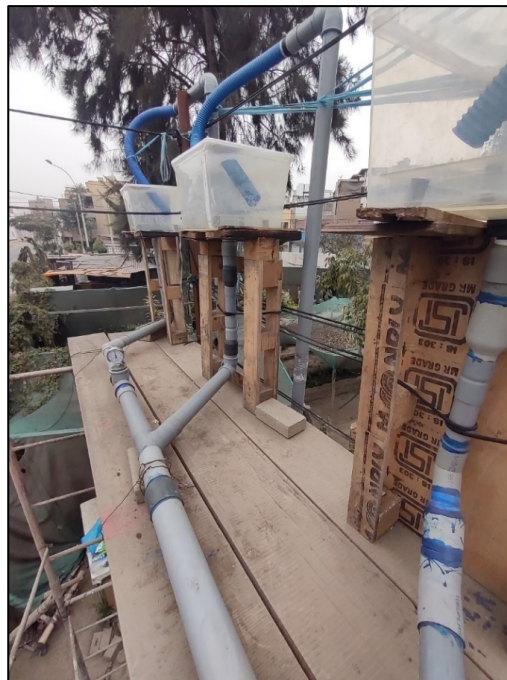
Figura 4.7 Descarga hacia los Contenedores
