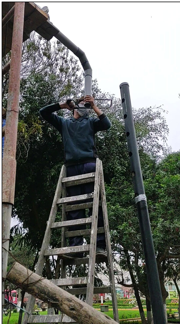
Figura 4.28 Corte de la Bajante Principal
