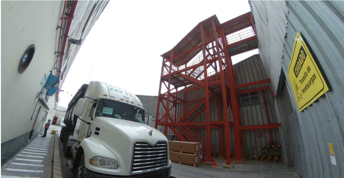
Figura 6.1-41 Escalera construida Fuente: propia
