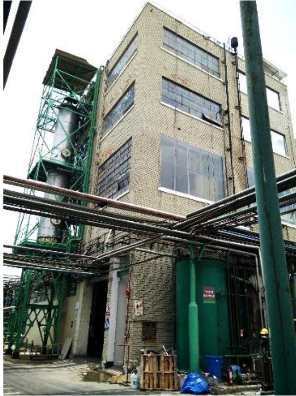
Figura 5.2-8 Fotografía de la fachada norte Fuente: propia
