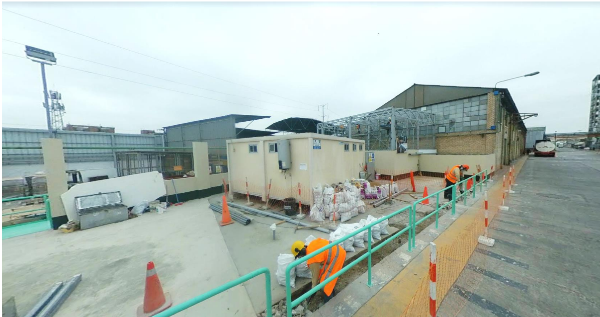
Figura 5.5-7 Fotografía de la zona intervenida en construcción (agosto 2021) Fuente: propia
