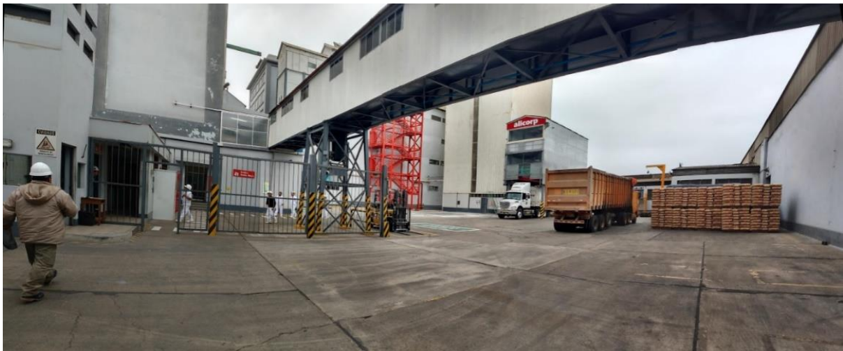
Figura 5.1-4 Patio de maniobras – Molino Santa Rosa Fuente: propia
