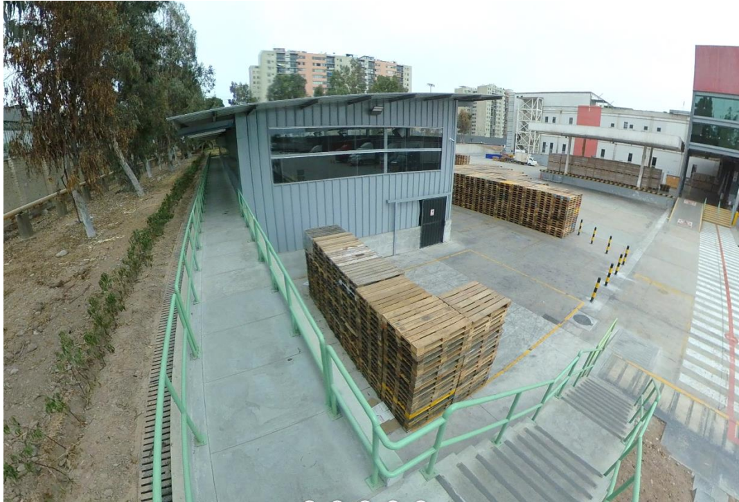
Figura 5.4-9 Pase peatonal elevado Fuente: Propia
