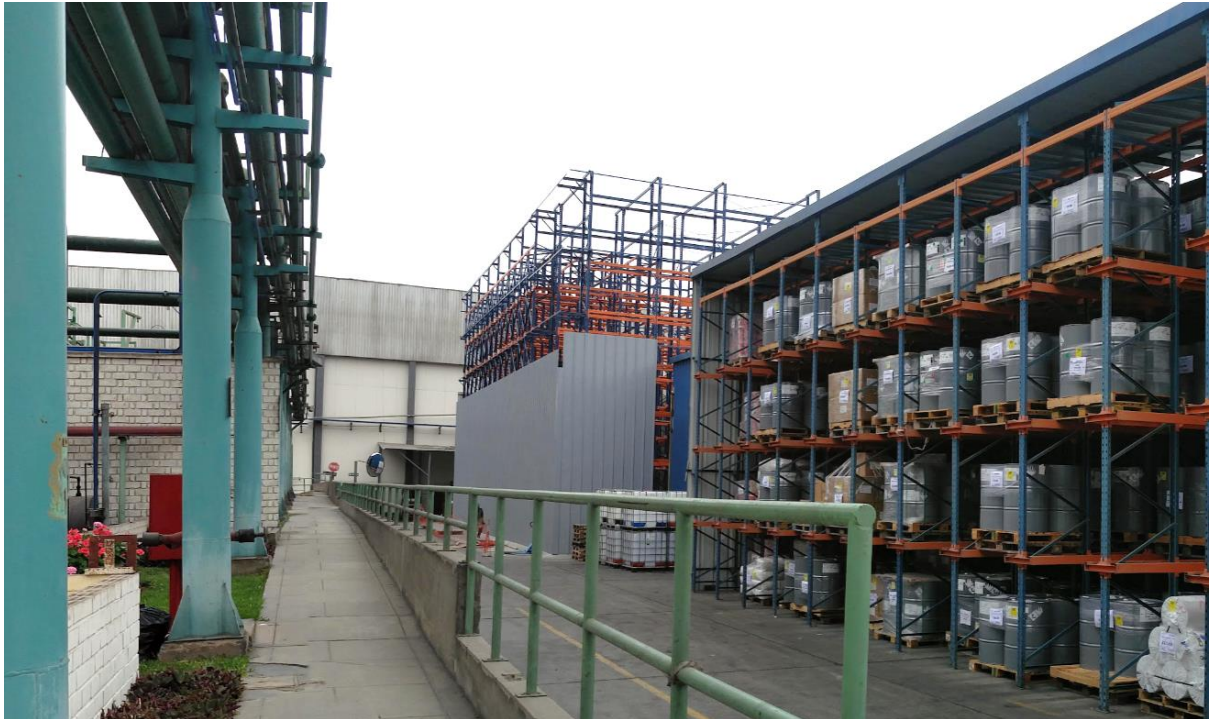
Figura 5.8-7 Almacén autoportante en construcción (2017) Fuente: propia
