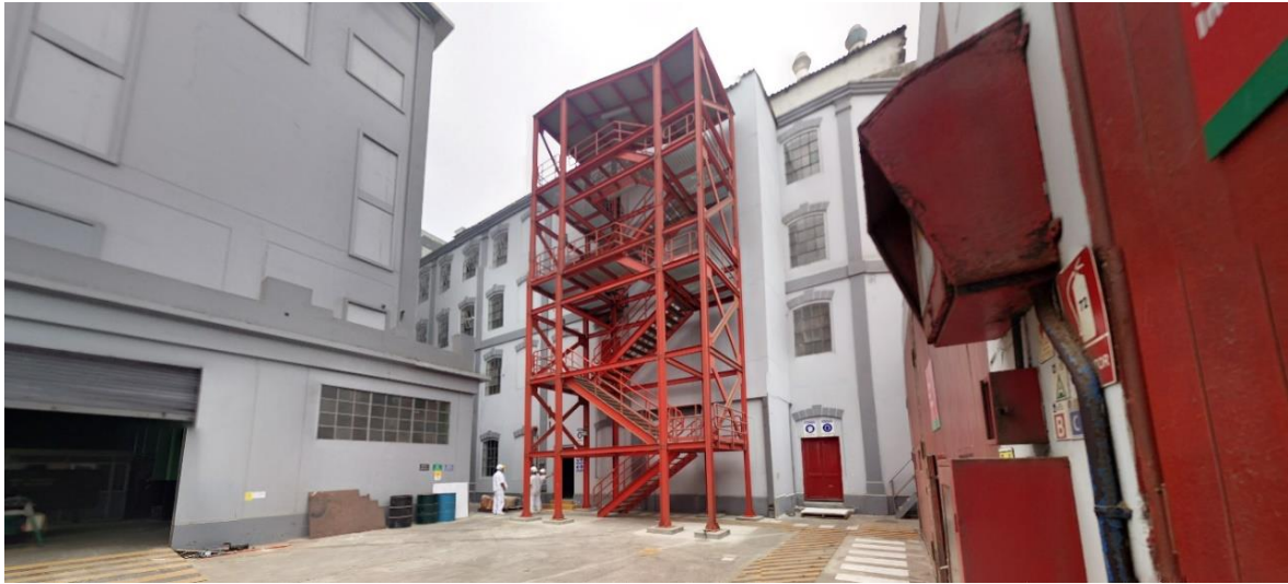
Figura 5.1-11 Fotografía de escalera construida – edificio molino 3 Fuente: propia
