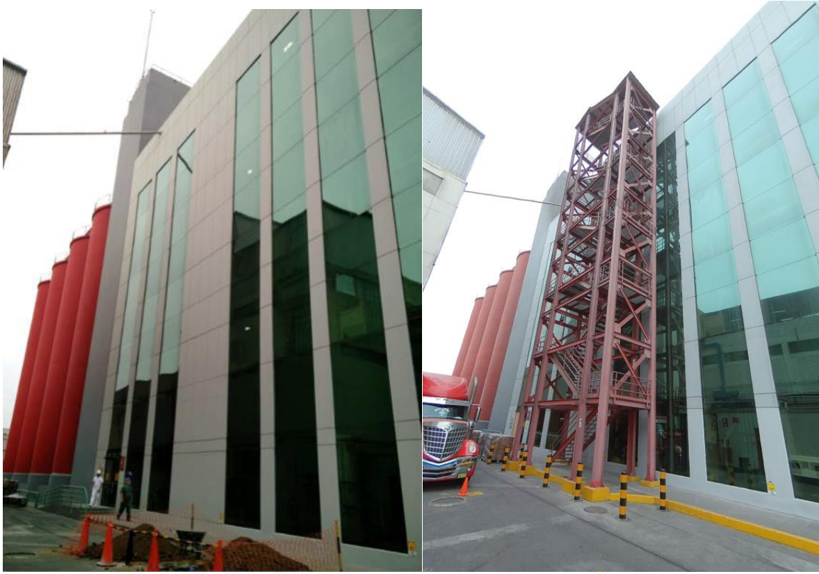
Figura 6.2-15 Escalera construida – comparativa antes y después Fuente: propia
