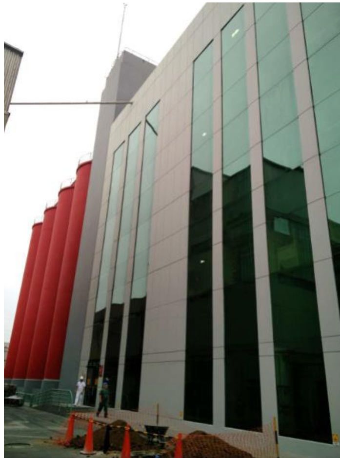
Figura 6.2-6 Fachada Edificio Molino de trigo (2016) Fuente: propia
