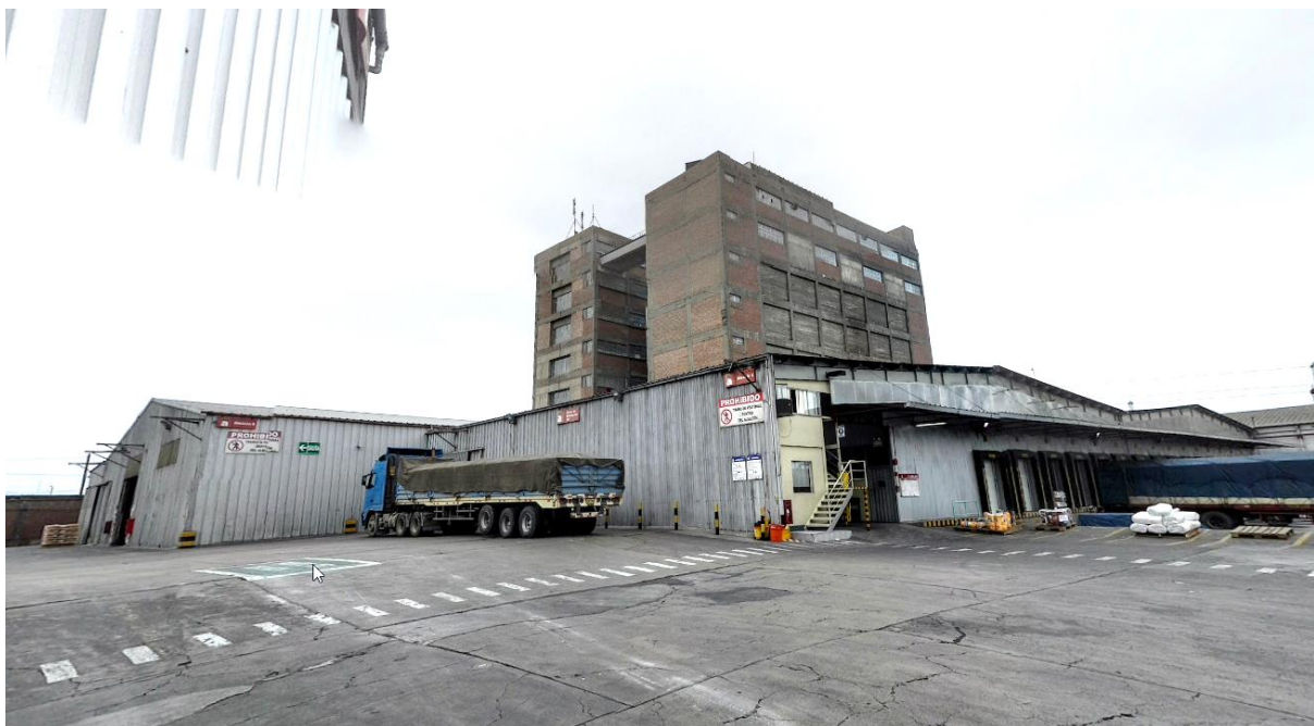
Figura 6.1-5 Edificio Silos de Harina y Edificio Molino de Trigo Fuente: propia
