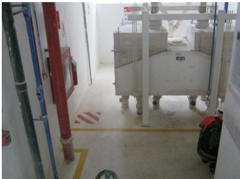
Figura 6.1-12 Edificio silo de harina piso 5 Fuente: propia
