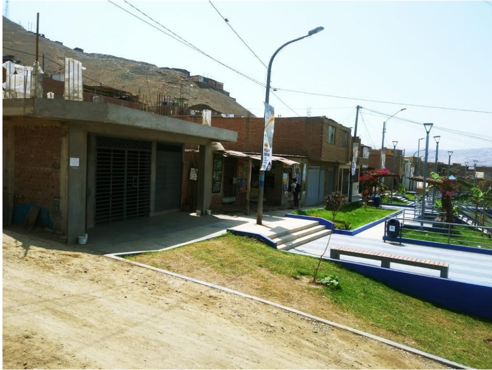
Figura 5.11-7 Primera etapa del primer nivel construida Fuente: propia
