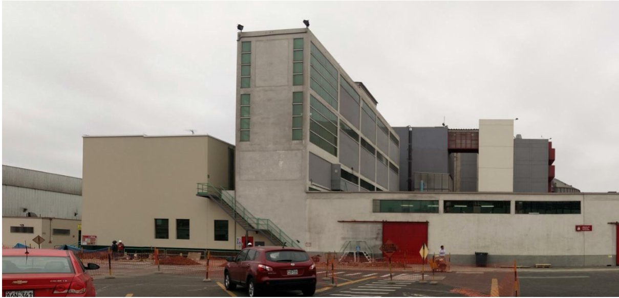
Figura 6.2-24 Fachada de edificio de embolse sin intervención Fuente: propia
