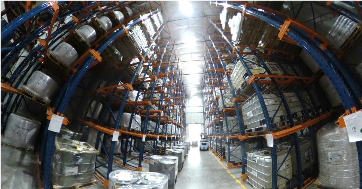
Figura 5.8-1 Almacén autoportante construido (2021) Fuente: propia
