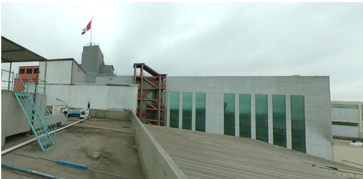
Figura 6.2-16 Escalera construida- azotea Fuente: propia
