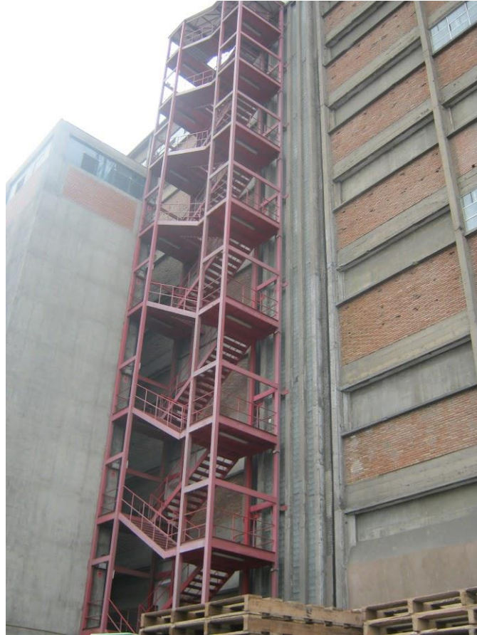
Figura 6.1-7 Escalera de evacuación Edificio de molienda de Trigo Fuente: propia
