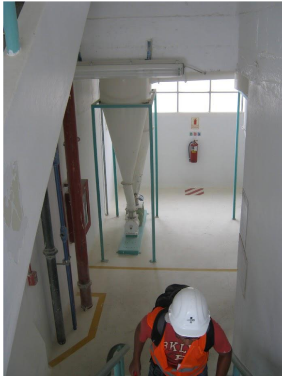
Figura 6.1-11 Edificio silo de harina piso 6 Fuente: propia
