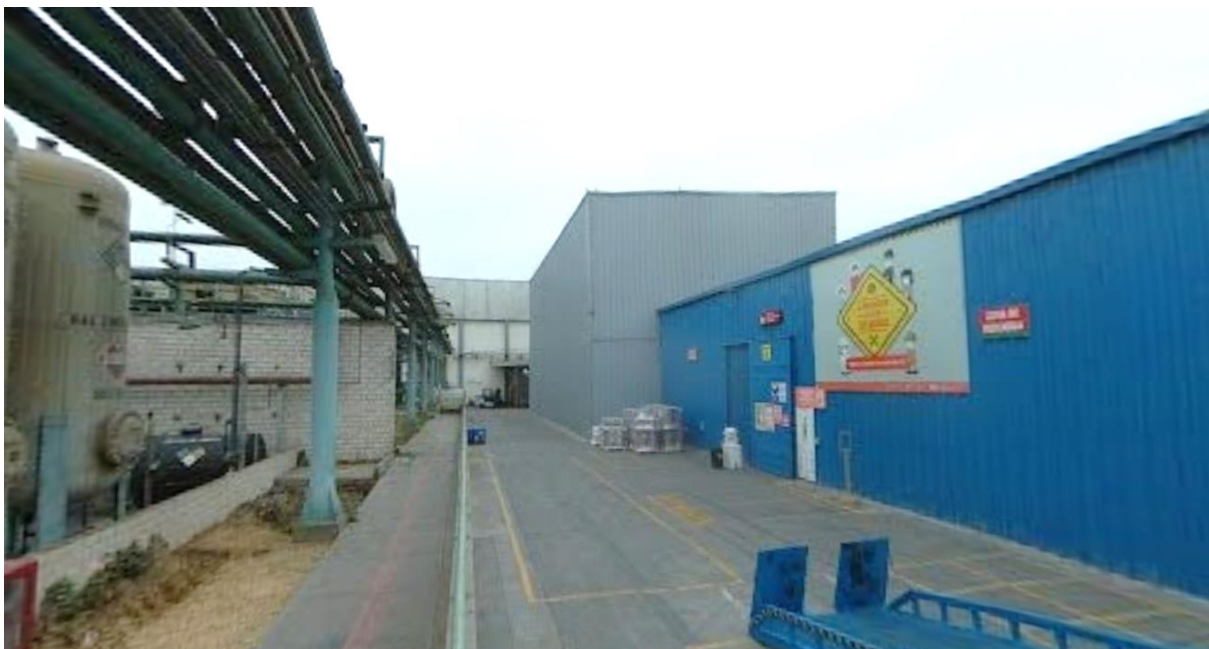
Figura 5.8-8 Almacén construido (2021) Fuente: propia
