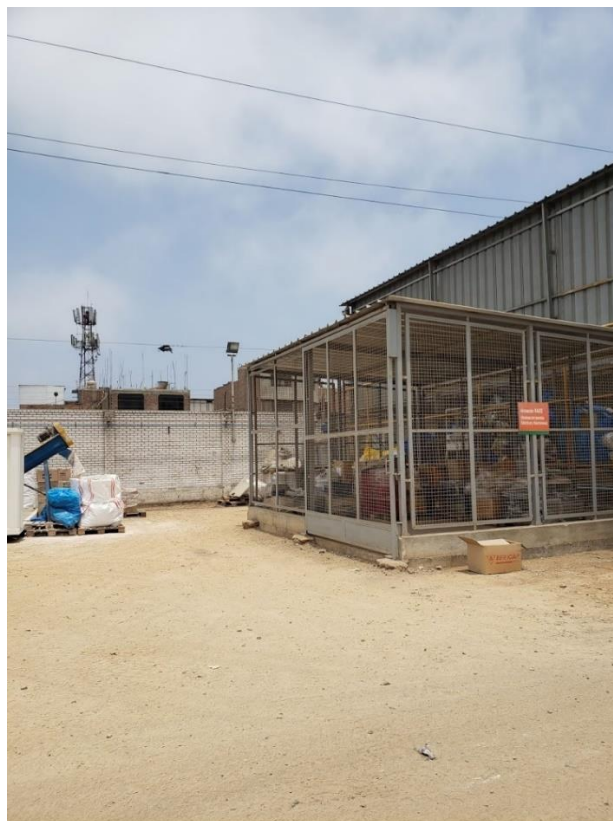
Figura 5.9-7 Almacén construido (2020) Fuente: propia
