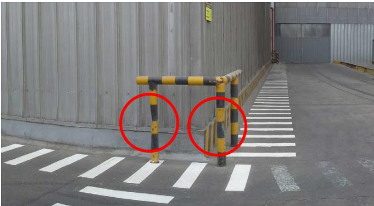
Figura 6.1-29 Abolladuras en barandas protectoras Fuente: propia
