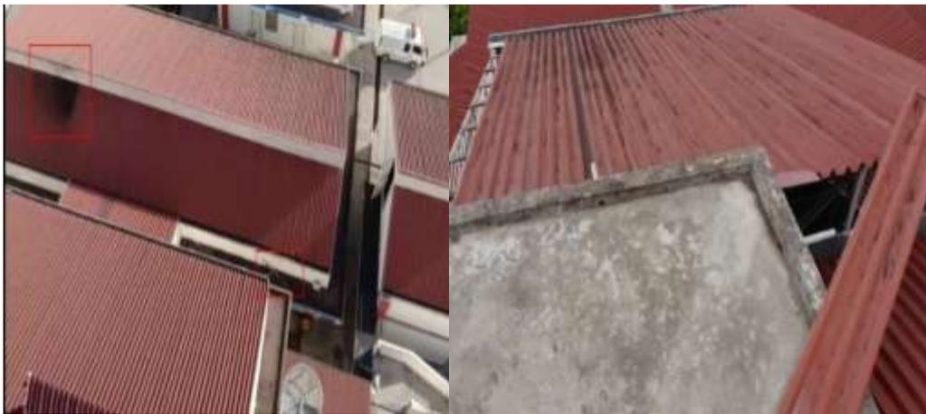
Figura N° 53 Corrosión de las cubiertas
