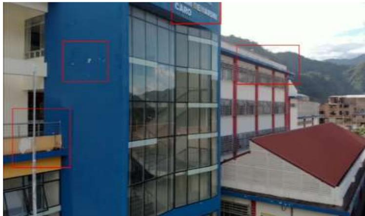
Figura N° 52 Deterioro por la filtración de agua en paredes y canaletas
