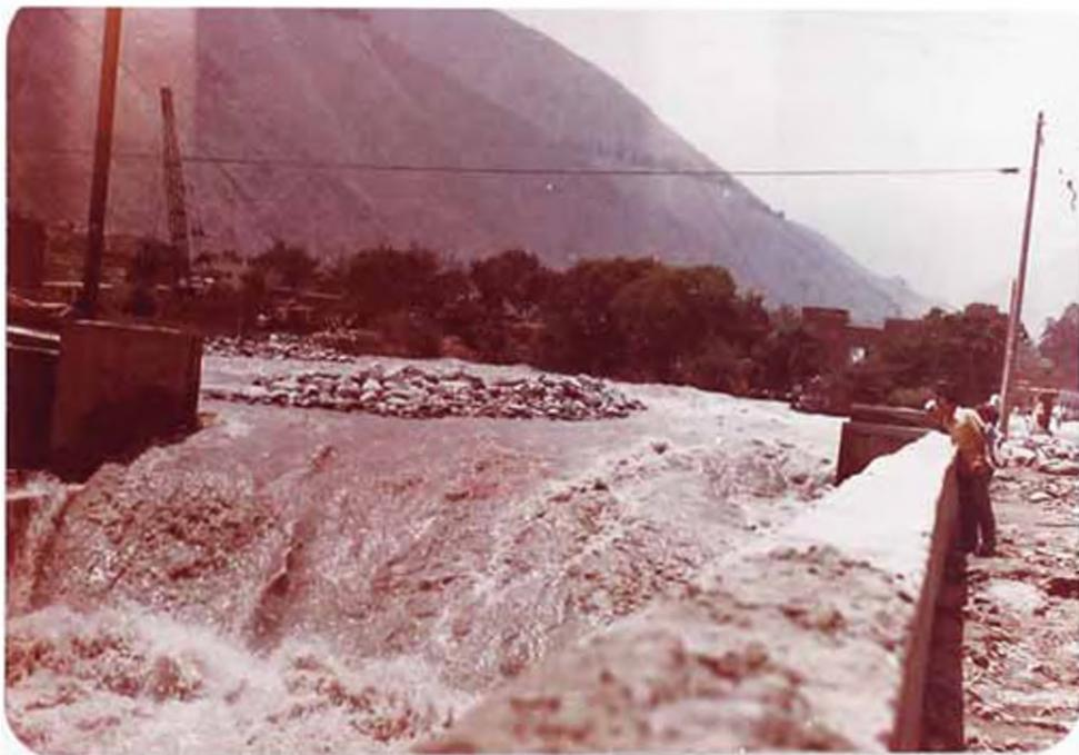
Vista perteneciente a una estructura ( Aliviadero), Boca-toma para la Central de Huanpaní. Se aprecia que el agua había rebalsado el muro, por sedimentación del material.
