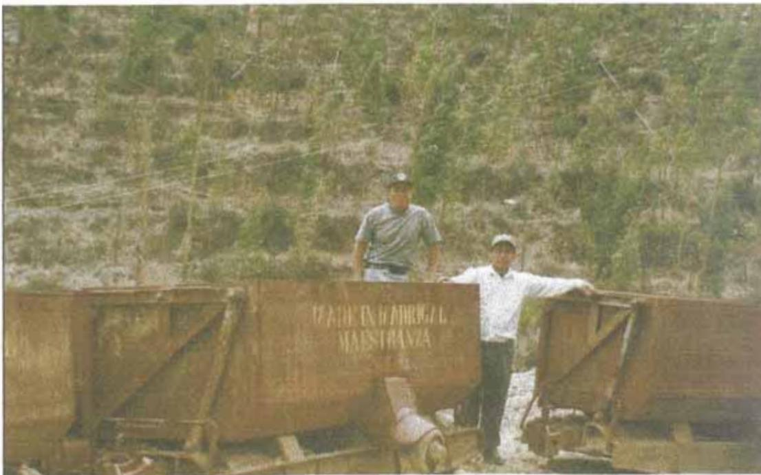
*Foto N° 18: Convoyes de carros Granby, los que eran jalados por locomotoras hasta la chancadora.*
