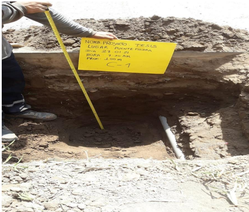
Figura 44 Calicata para extracción de muestra a una profundidad de 1 metro
