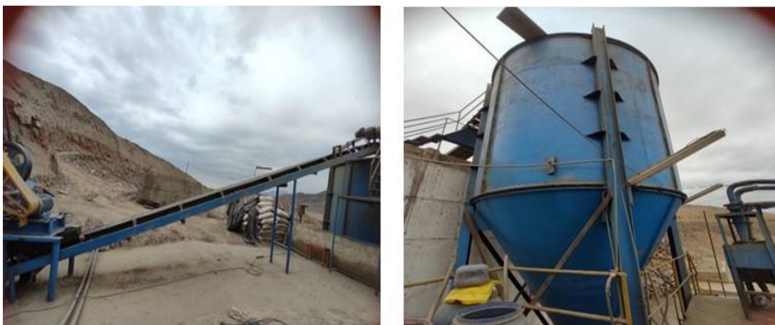
Figura 2.21. Faja transportadora de Chancado Secundario y tolva de finos
