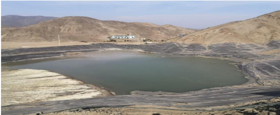
Figura 2.28. Depósito de Relaves de la Planta Concentradora Centenario
