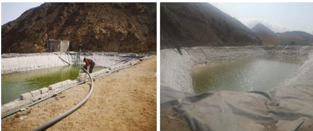
Figura 2.16. Poza N°1 y N°2 de almacenamiento de agua fresca para la Planta Concentradora Centenario
