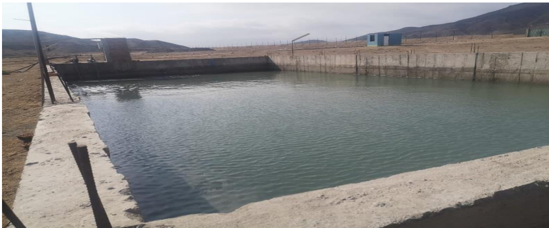
Figura 2.17. Poza de agua de recirculación al proceso
