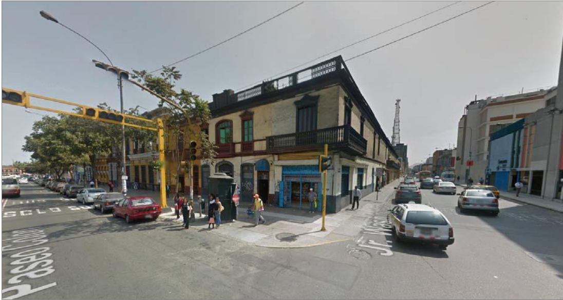
Figura 04: Edificio Colón - Edificio existente
