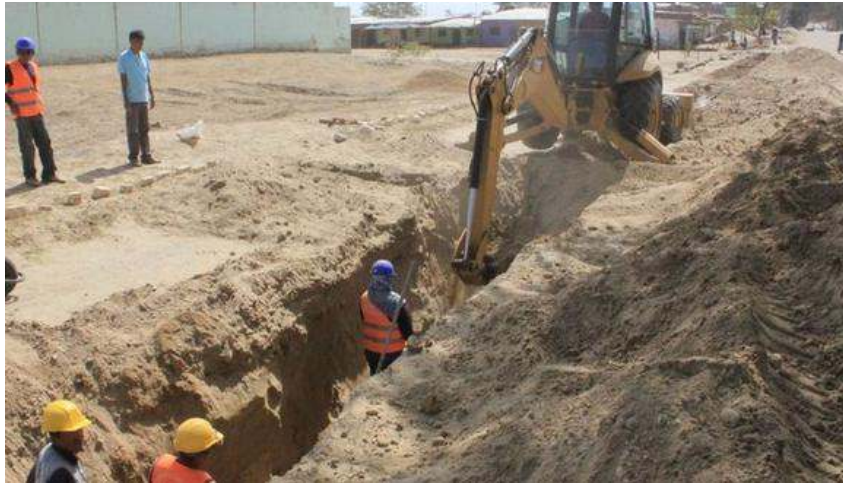
Instalación de redes de alcantarillado para reducir la brecha en acceso a este servicio en las localidades urbanas de Región Piura
