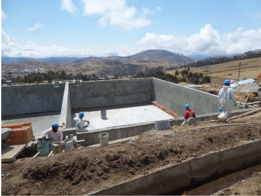
Construcción de planta de tratamiento de agua potable para el mejoramiento de la calidad del servicio de abastecimiento de agua en el ámbito rural.
