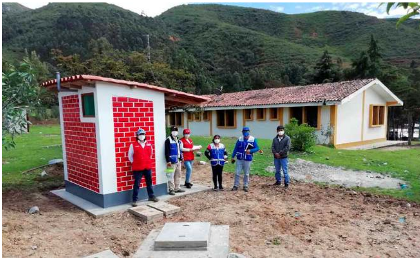
Construcción de unidades básicas de saneamiento en el ámbito rural para la mejora de la calidad de vida de la población en la región Piura.
