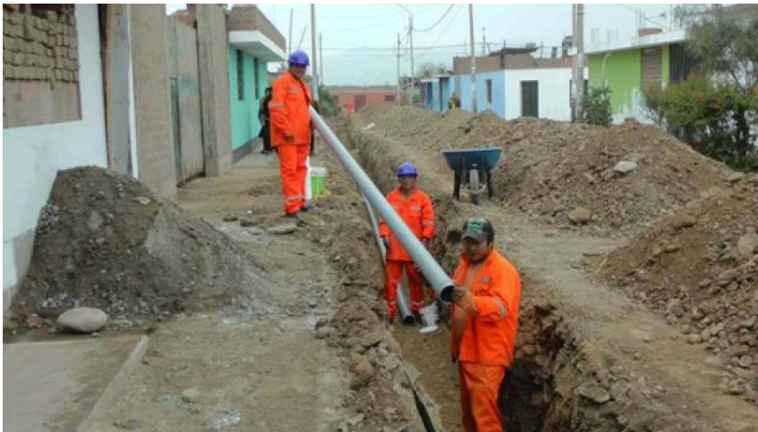
Instalación de redes de agua potable para reducir la brecha en acceso a este servicio en las localidades urbanas de Región Piura
