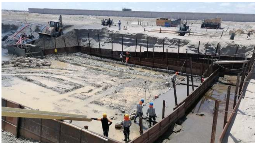
Construcción de la PTAR Parachique que contribuirá a la reducción de la brecha en tratamiento de aguas residuales en la región Piura.
