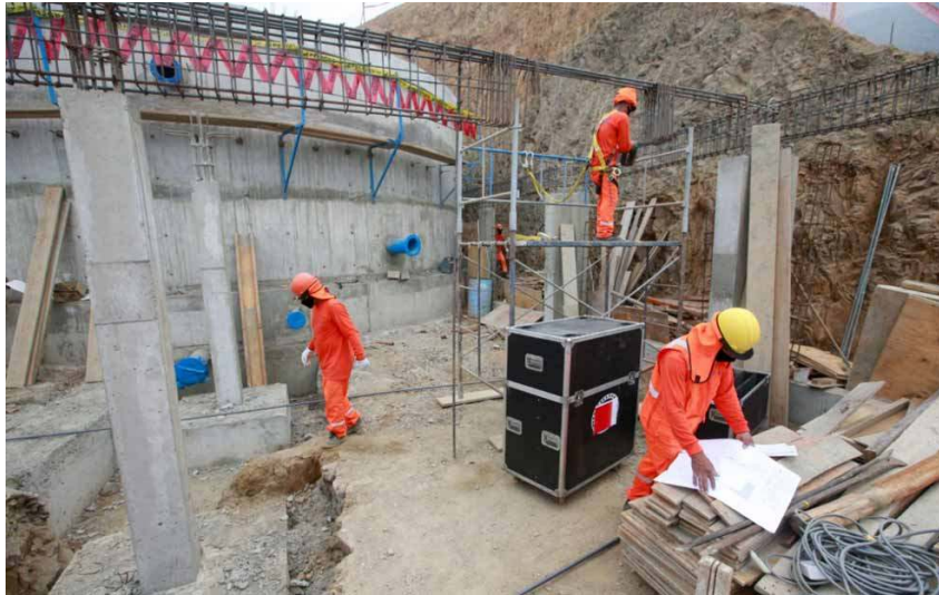
Construcción de reservorio de almacenamiento de agua potable para mejorar la continuidad y la presión en las localidades urbanas de la región Piura
