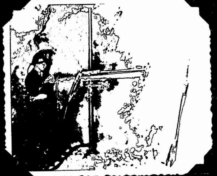
Fig.14.-Montadura de columna neumática
