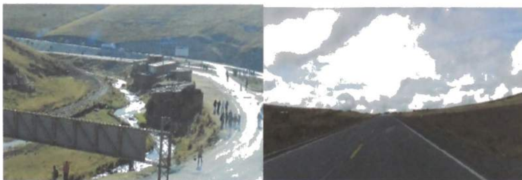
Imagen N° 2. 3.- Fotos tramo Km 0 al Km 6+700
