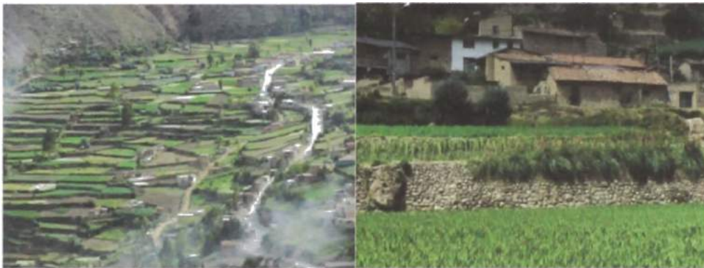
Imagen N° 2. 7.- Fotos del tramo Km 24+100 a Tarma
