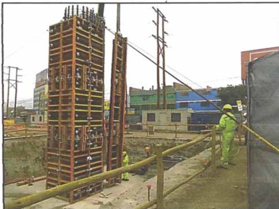
Figura N°5.27: Proceso de encofrado de columnas
