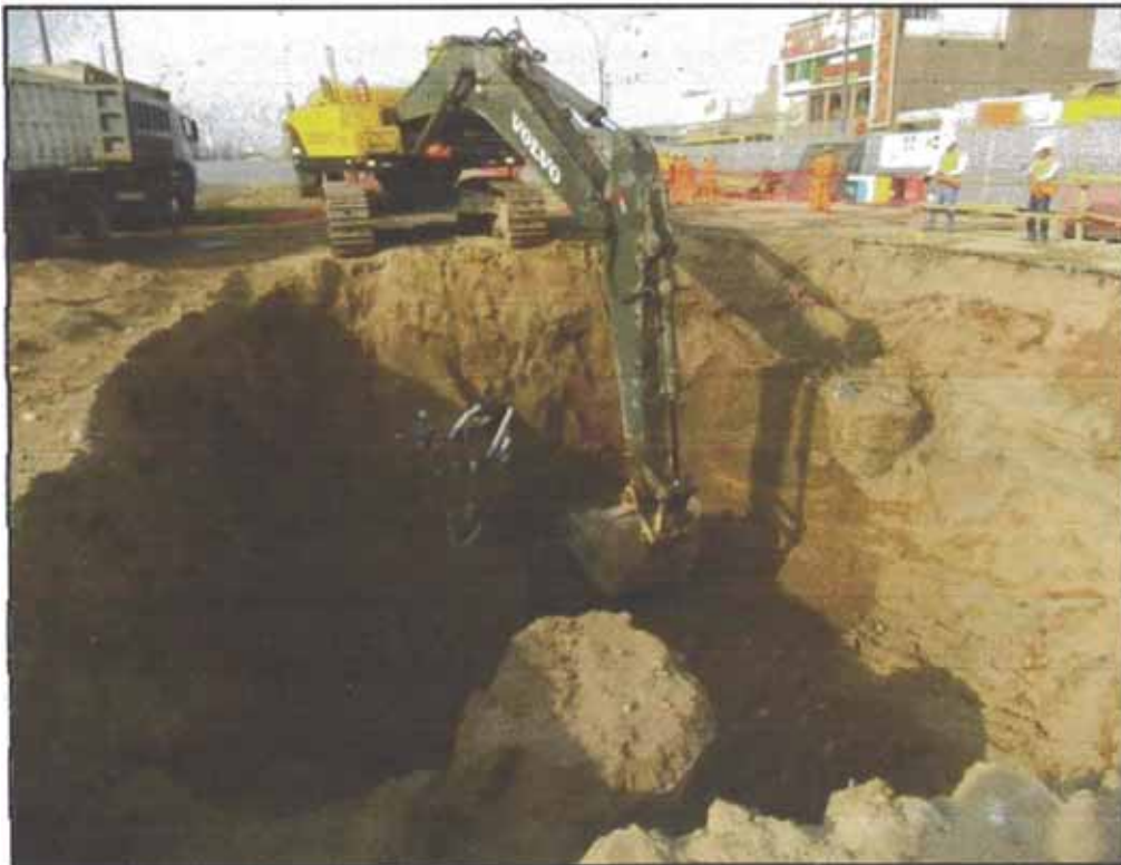
Figura N°5.20: Excavación inicial para zapata con pilotes
