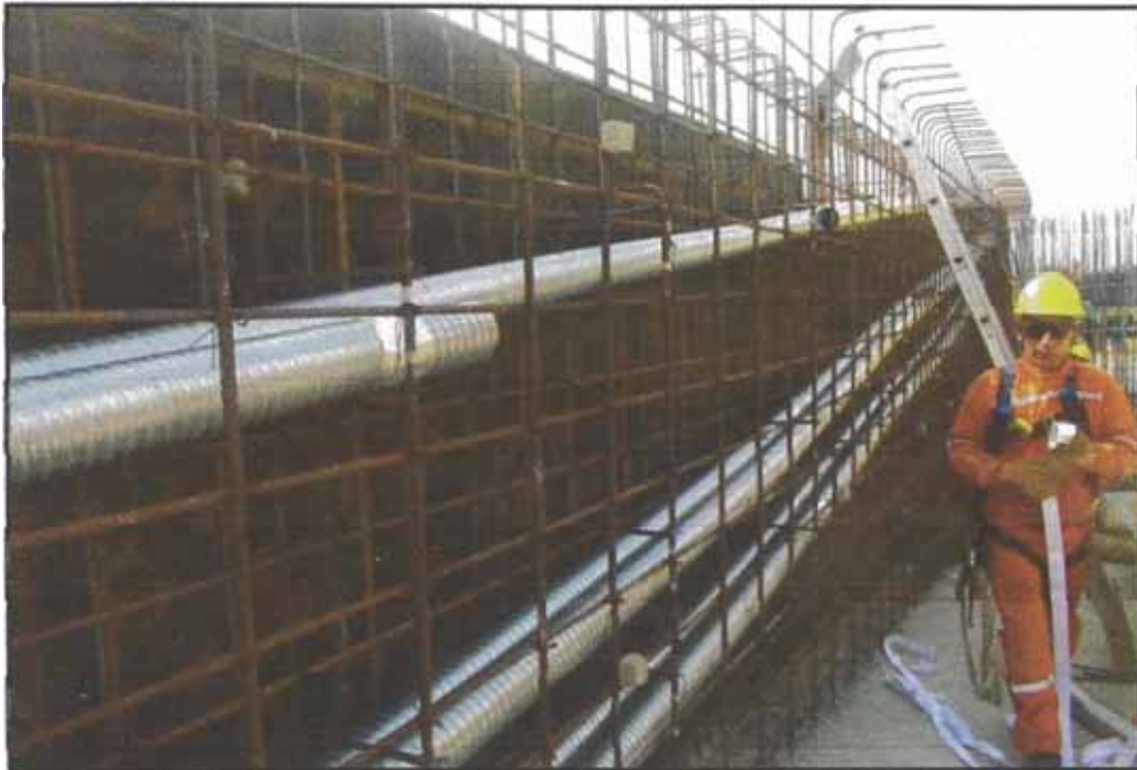
Figura N°5.43: Colocación de ductos de postensado
