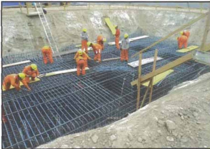
Figura N°5.22: Armadura de acero para zapatas
