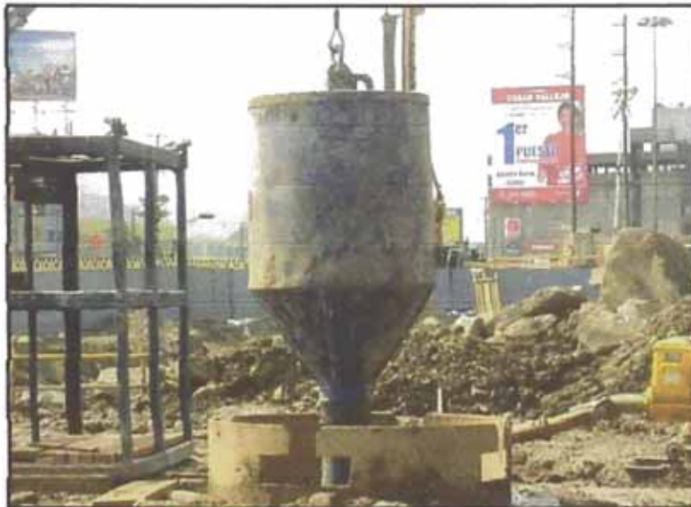
Figura N°5.66: Tuberías tremie
