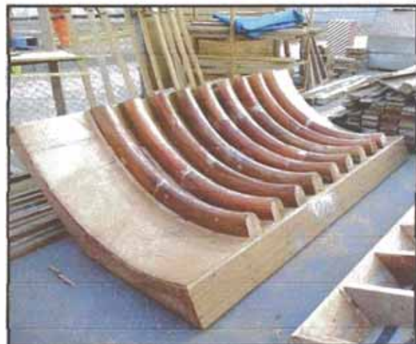
Figura N° 5.91b: Encofrado de madera.
