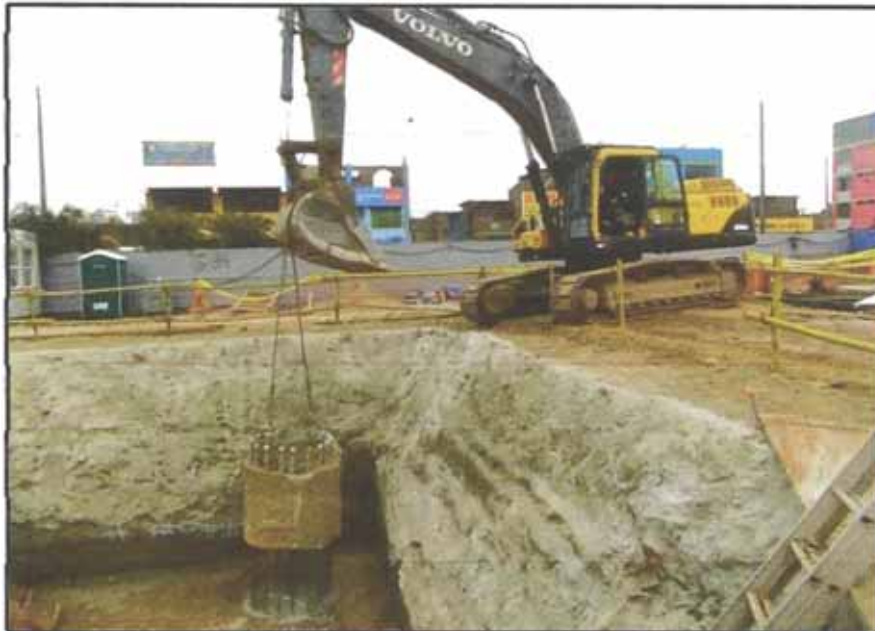
Figura N°5.16: Izaje del cabezal fracturado.
