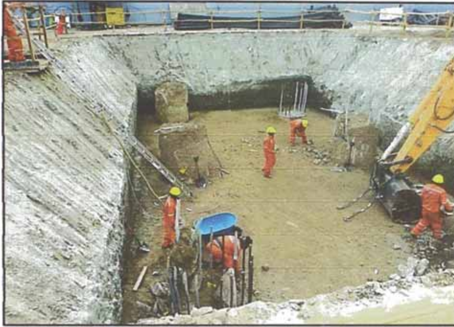
Figura N°5.2: Limpieza y compactación previa al ensayo DPL
