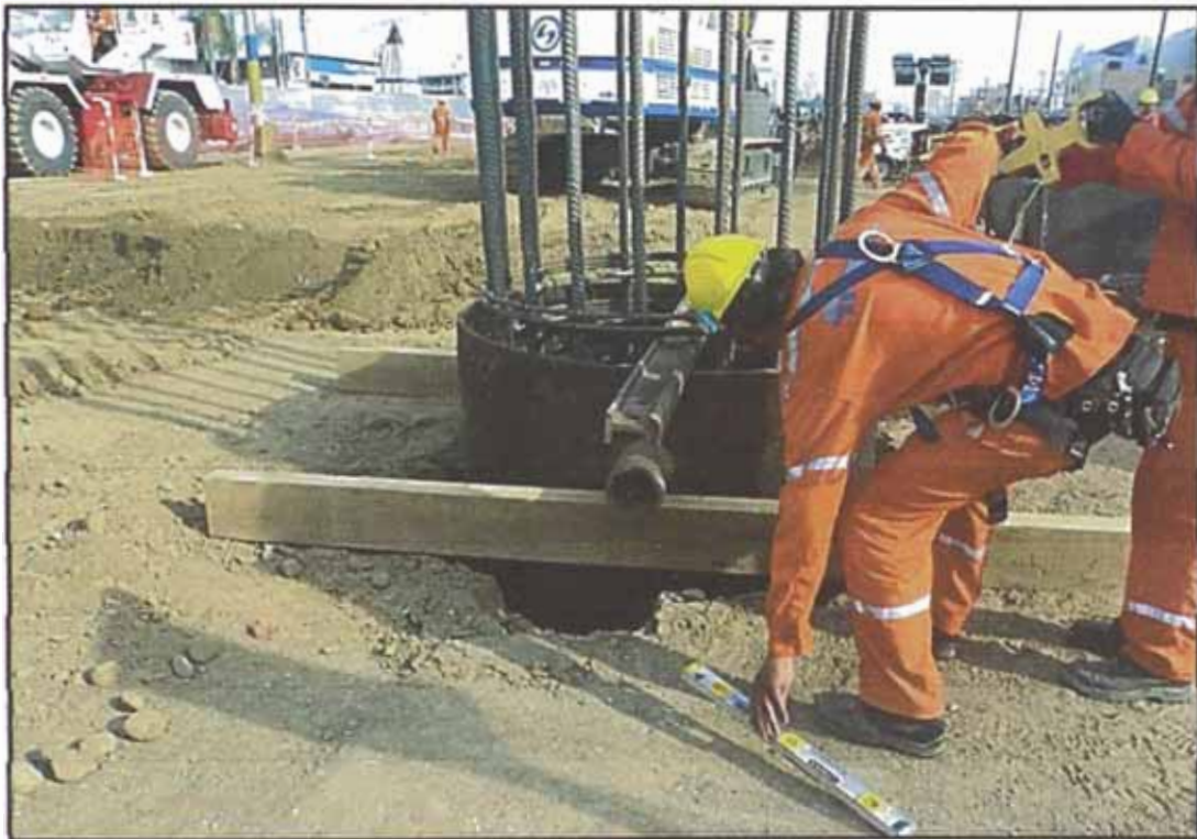
Figura N°5.7: Lectura de la profundidad de la perforación
