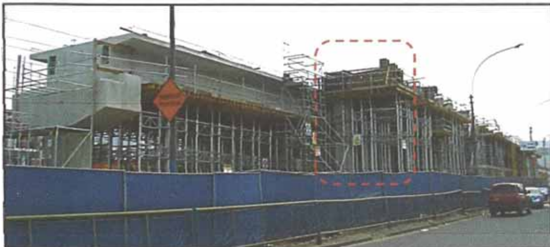
Figura N° 5.96: Columna S51P en la vía par del viaducto elevado
