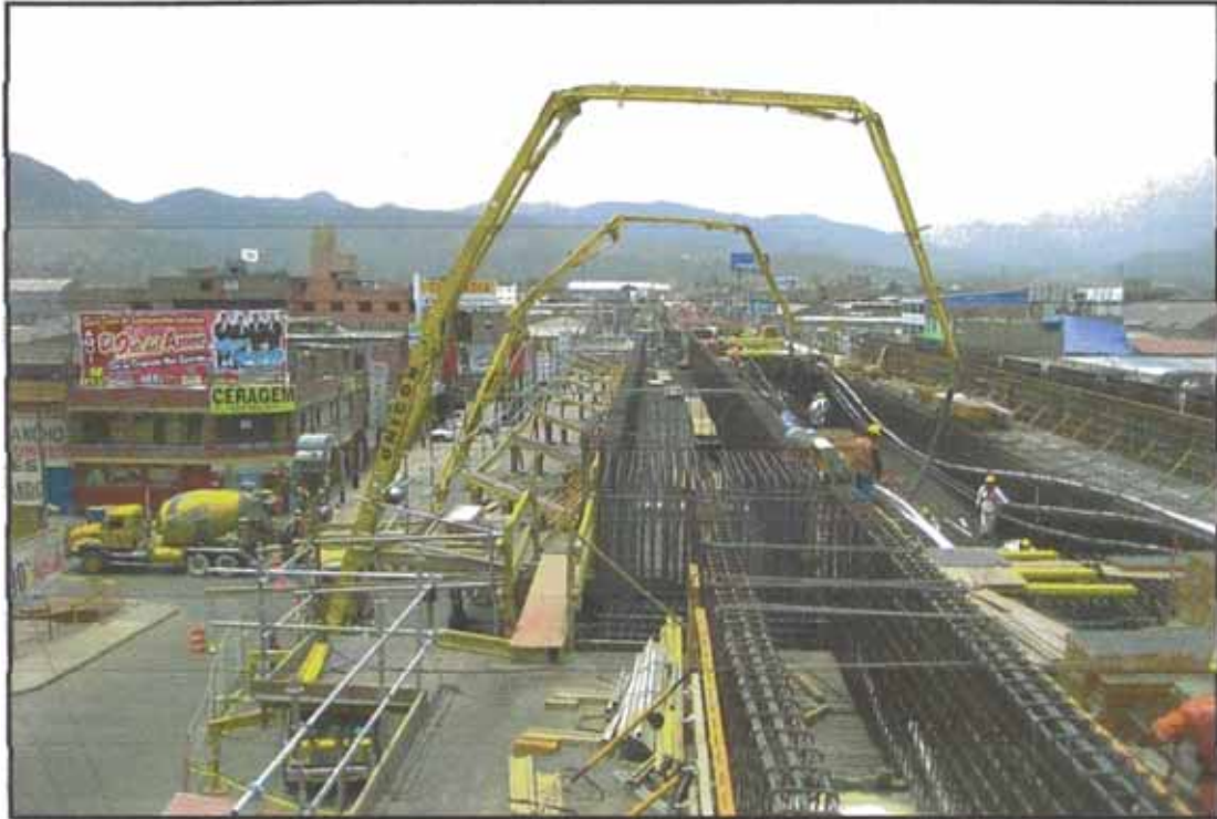
Figura N° 5.58: Secuencia de vaciado de Viga Cajón
