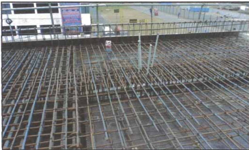
Figura N°5.44: Colocación de Chimeneas de inyección
