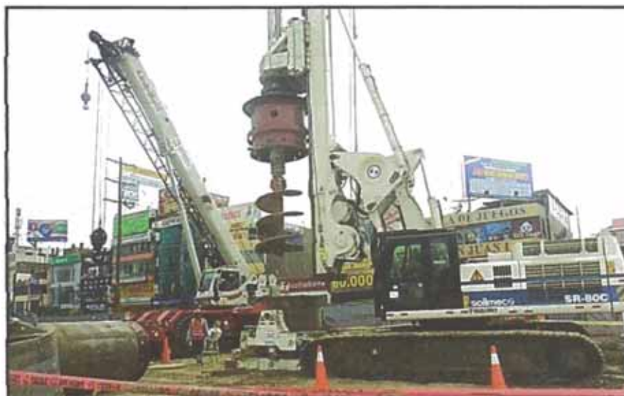
Figura N°5.3: Verificación de la colocación de la camisa mediante unas guías
