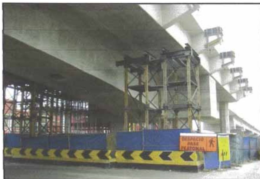
Figura N° 5.65: Retiro del apuntalamiento
