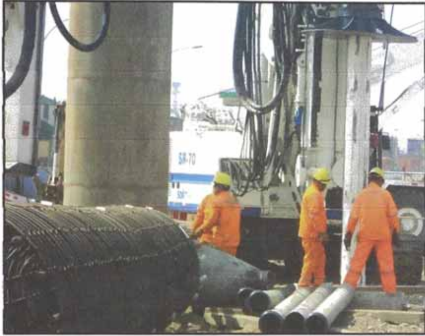
Figura N°5.5: Verificación de la posición de la camisa por parte de topografía
