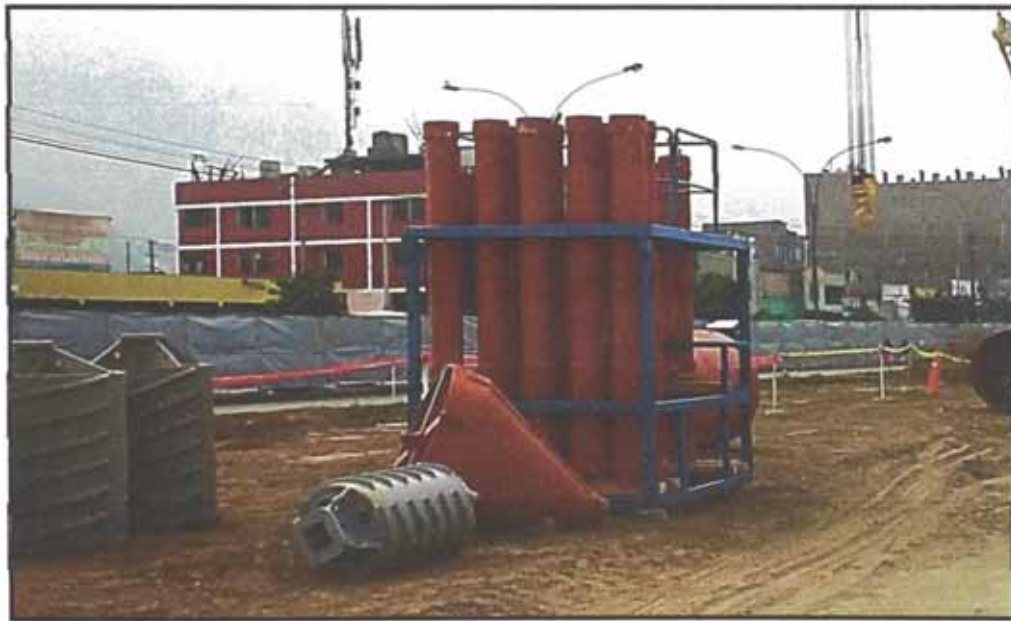
Figura N°5.12: Tuberías Tremie
