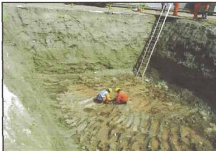
Figura N°5.1: Estabilización de taludes con lechada de cemento
