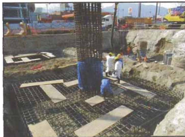
Figura N°5.24: Colocación final de columna en zapata
