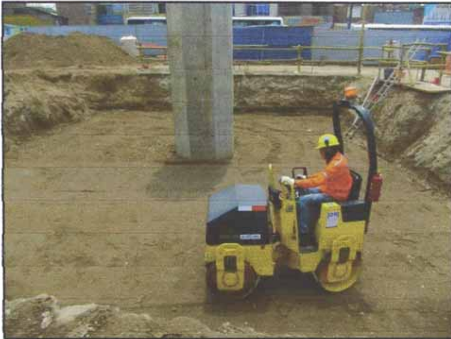
Figura N°5.31: Compactación del relleno en zapatas
