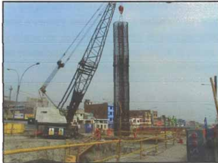
Figura N°5.23: Izaje de columnas
