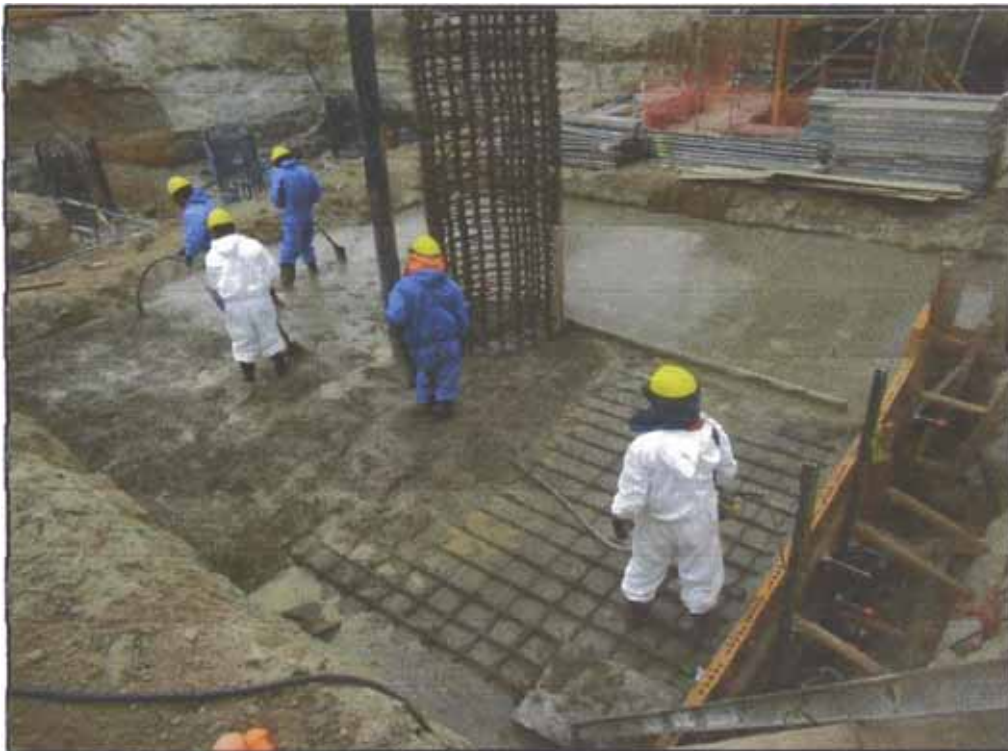
Figura N°5.26: Proceso de vaciado de concreto en zapatas
