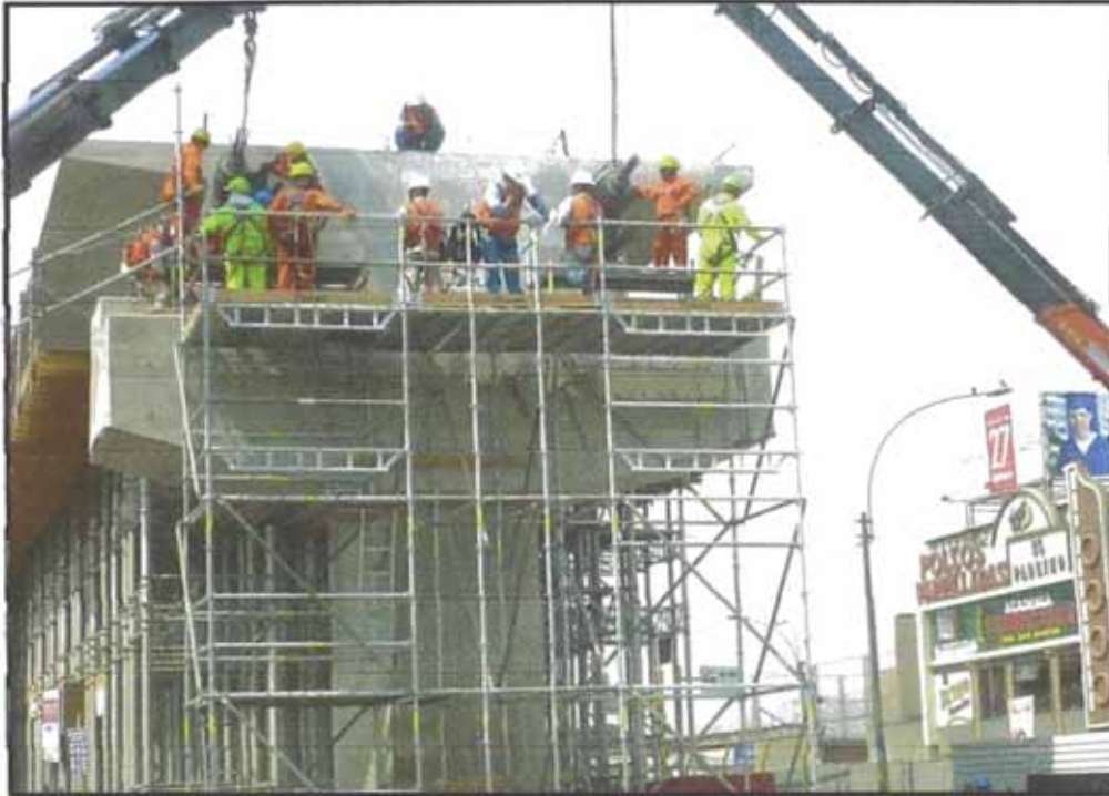
Figura N° 5.59: Postensado de la viga cajón
