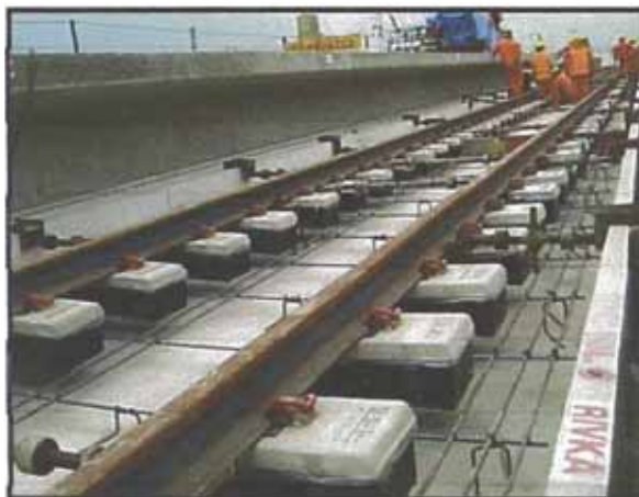
Preparación para vaciado
