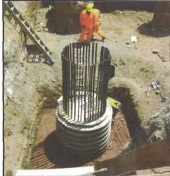
Figura N° 5.91d: Colocación de material de relleno suelo-cemento
