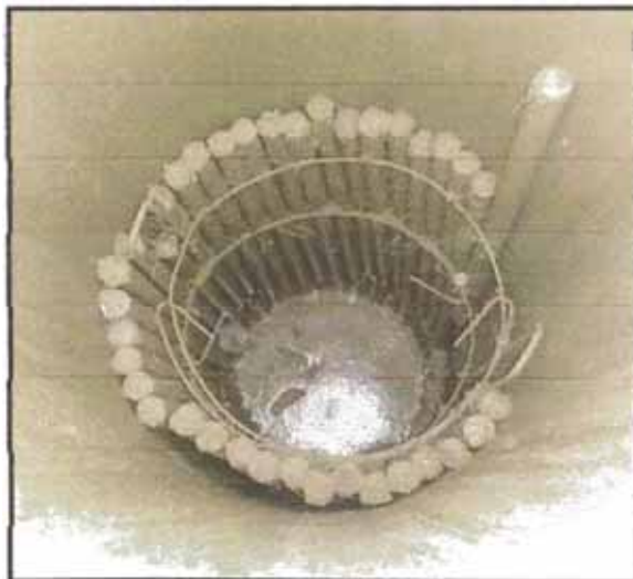
Figura N° 5.89: Interior del pilote en etapa de colocación del concreto.
