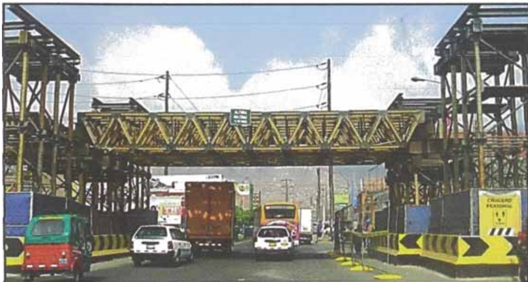
Figura N° 5.92: Encofrado del viaducto con las cerchas y torres MK
