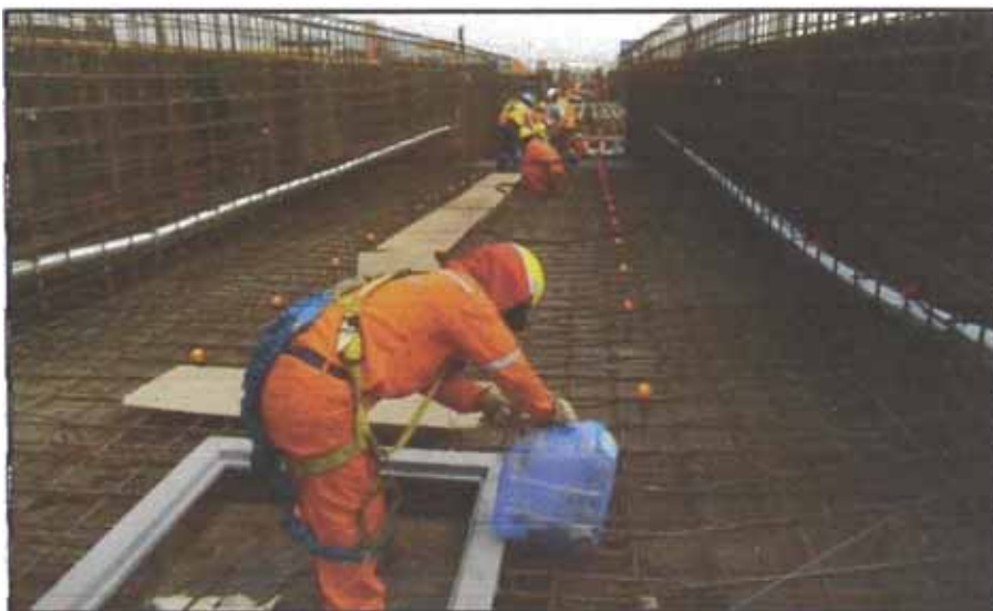
Figura N° 5.41: Ventana de inspección
