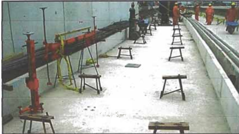
Figura N°5.80 Fijación de soportes Fuente propia
