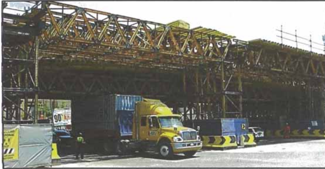
Figura N° 5.93: Encofrado del Andén con las cerchas y torres MK
