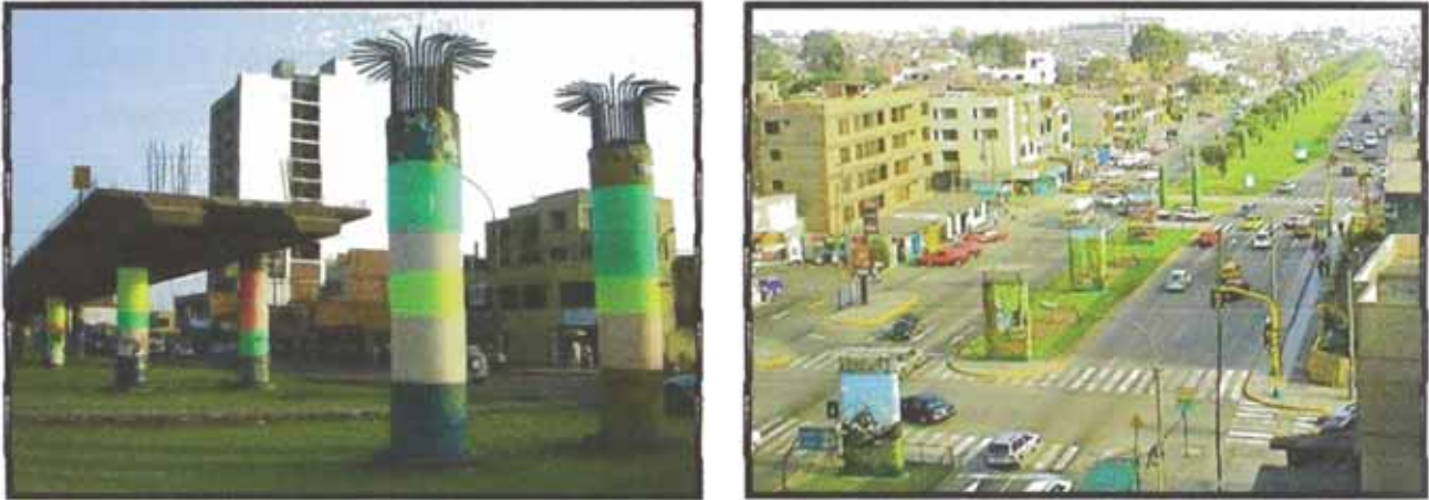
Figura N° 1.4: Viaducto inconcluso de la Línea 1 – Tramo 1 Metro de Lima
