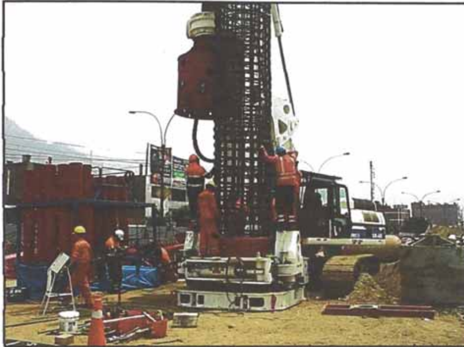
Figura N°5.10: Soldadura en los traslapes que unen 2 armaduras del pilote
