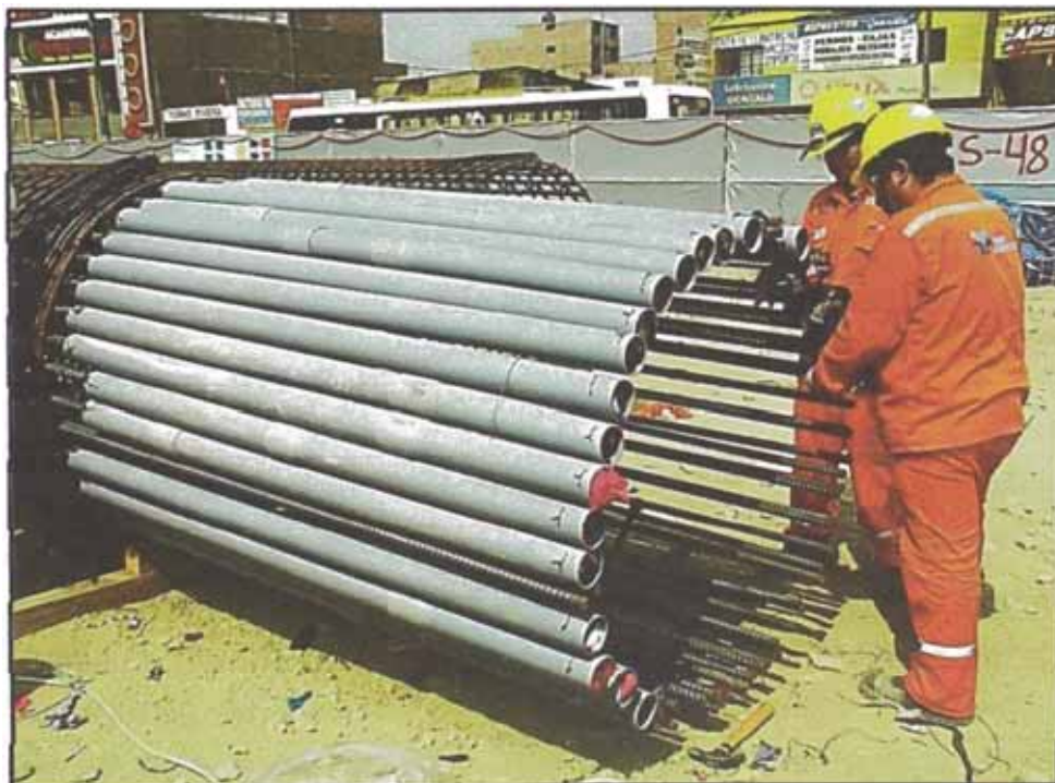
Figura N°5.11: Colocación de tubos de PVC para facilitar el descabezado
