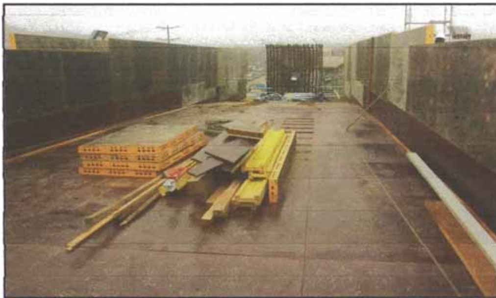
Figura N° 5.38: Encofrado lateral de almas viga cajón
