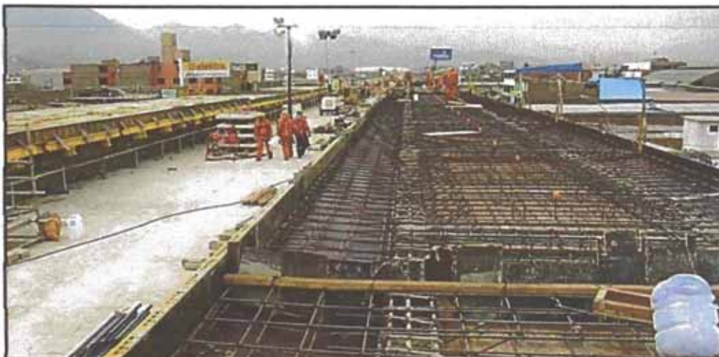
Figura N° 5.98: Armadura de refuerzo de la losa superior del andén
