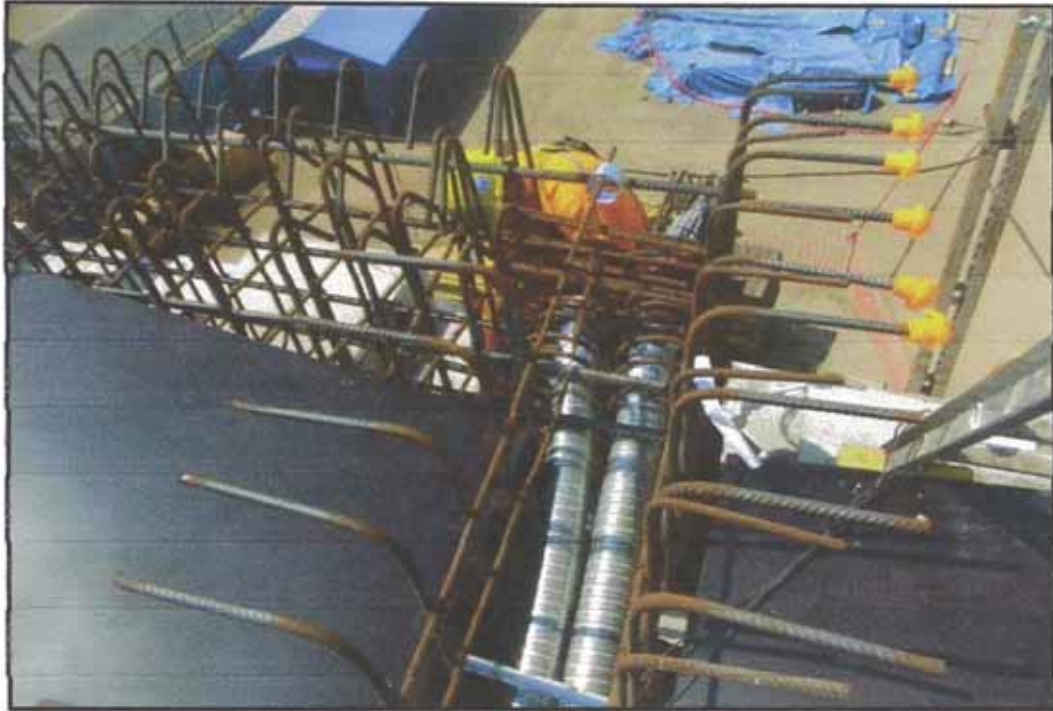
Figura N°5.45: Colocación de espiral de refuerzo y botella de anclaje
