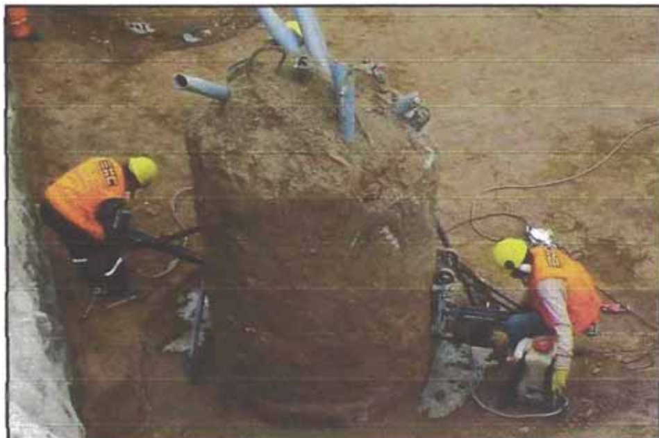
Figura N°5.14: Perforaciones del barreno para el descabezado del pilote
