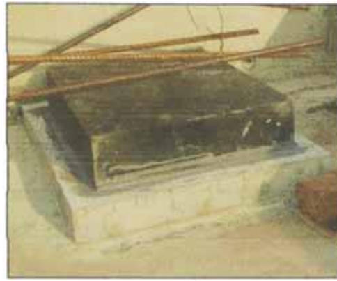
Figura N° 5.35h. Colocación del neopreno (Fuente: Propia).
