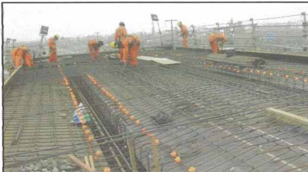
Figura N°5.48: Acero losa superior de viga cajón
