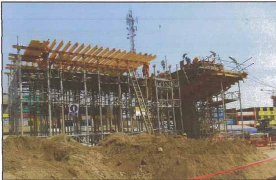
Figura N°5.34: Construcción de viga cabezal para puente
