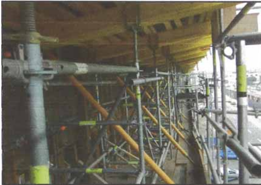
Figura N° 5.39: Encofrado de las alas de viga cajón
