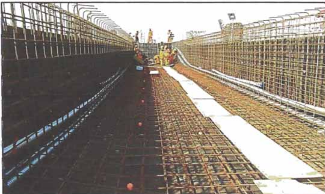
Figura N° 5.42: Colocación de armadura de refuerzo
