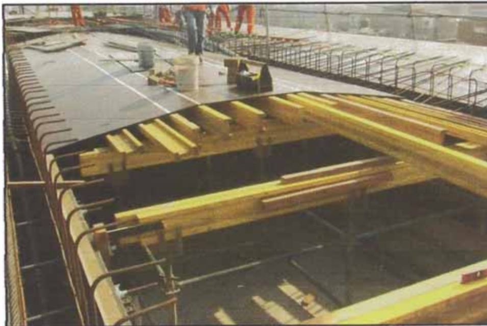
Figura N°5.47: Encofrado losa superior de viga cajón
