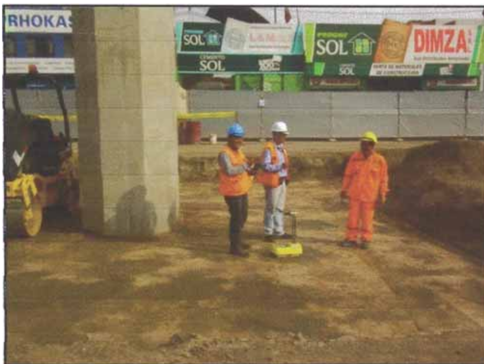
Figura N°5.33: Pruebas de Densímetro para relleno
