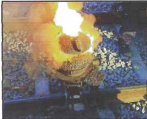
Soldadura Aluminotérmica
