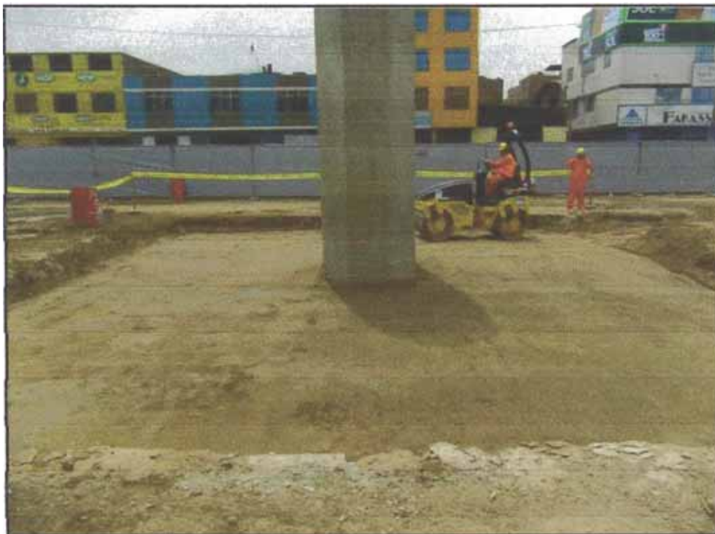
Figura N°5.32: Fin del relleno de zapatas
