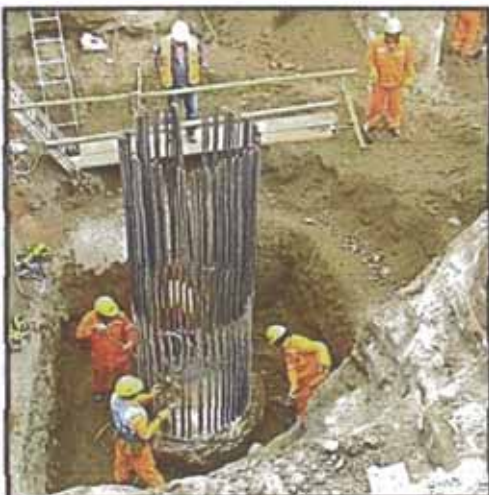
Figura N° 5.91a: Limpieza del concreto alterado por el relleno
