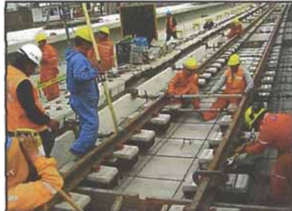
Fijación de los bloques a los rieles
