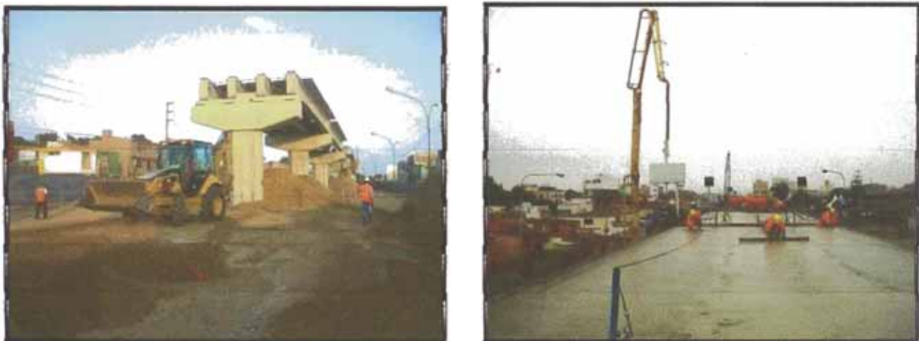
Figura N° 1.5: Construcción del Viaducto Línea 1 – Tramo 1 Metro de Lima
