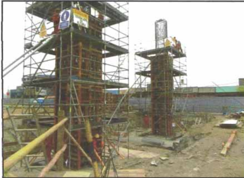
Figura N°5.28: revisión topográfica de verticalidad en columnas
