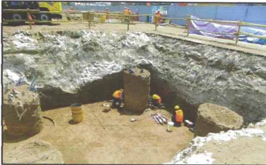
Figura N°5.15: Fracturación de la cabeza del pilote con el quebrantador hidráulico.
