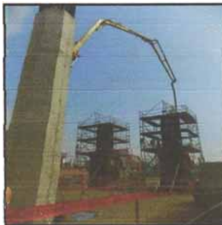
Figura N°5.29: Vaciado de concreto en columnas
