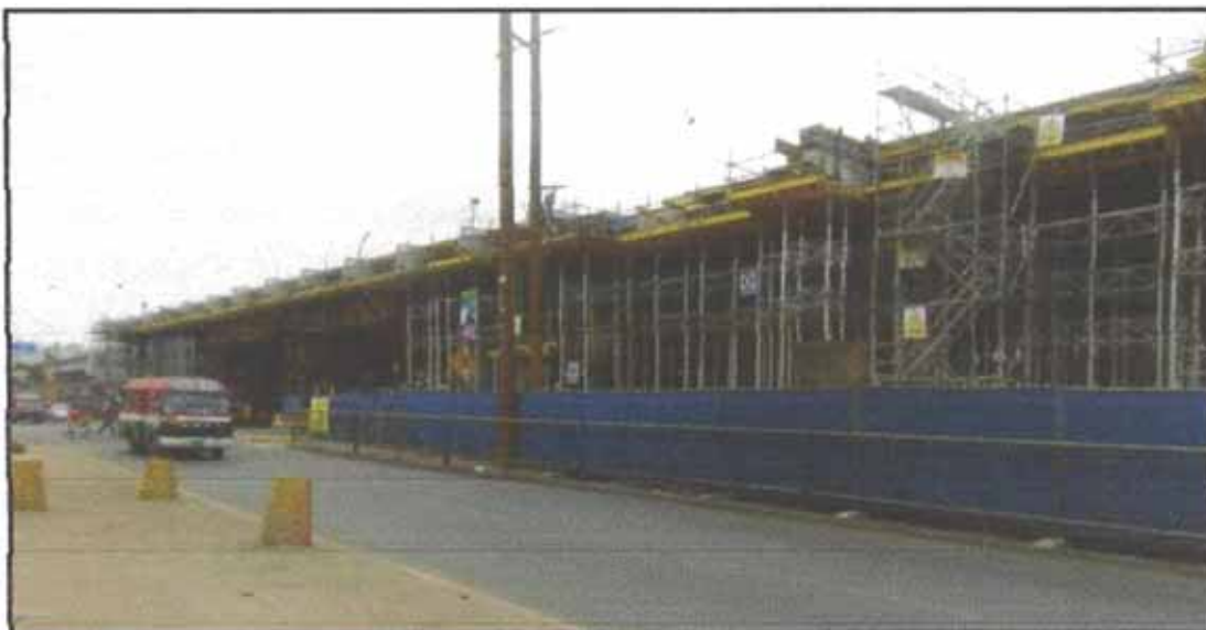
Figura N°5.36: Vista del encofrado del Cruce especial San Carlos
