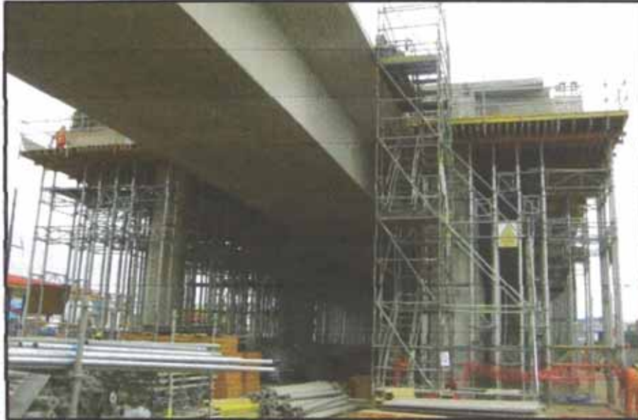
Figura N° 5.64: Reparación de burbujas superficiales
