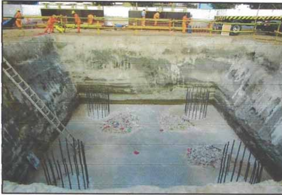
Figura N°5.21: Vaciado de Solado para zapatas
