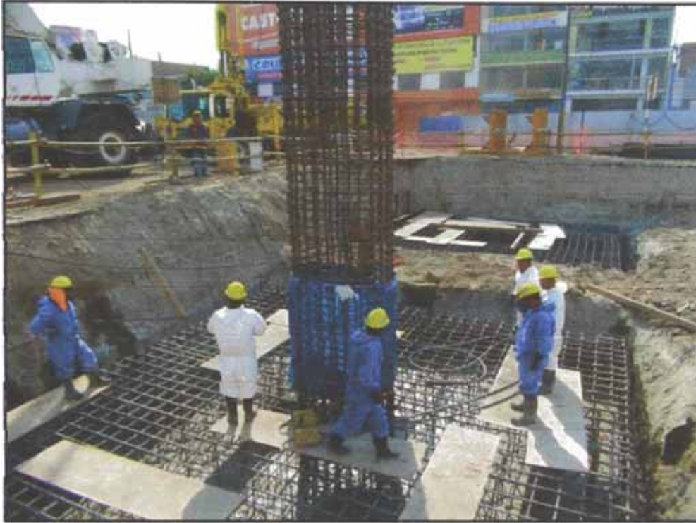
Figura N°5.25: Vaciado de concreto en zapatas
