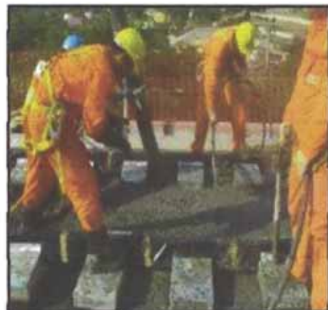
Vaciado del concreto
