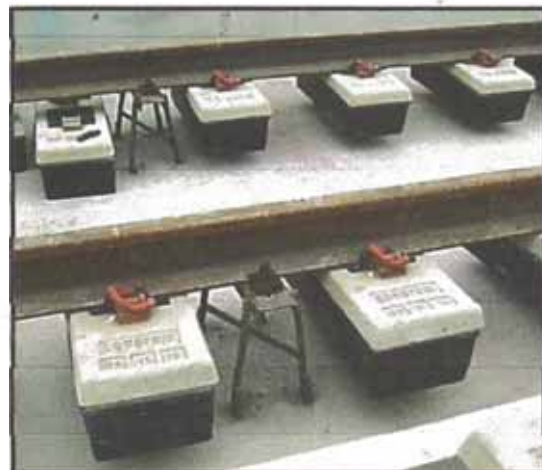
Figura. N°5.81 Soporte provisional de rieles Fuente propia
