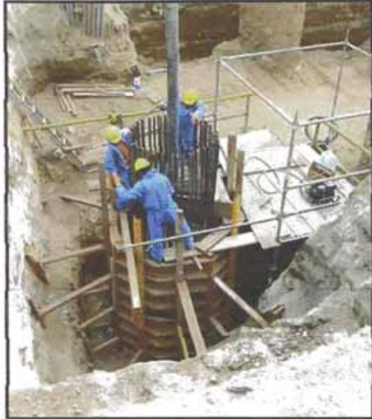
Figura N° 5.91c: Colocación del concreto en área de pilote faltante
