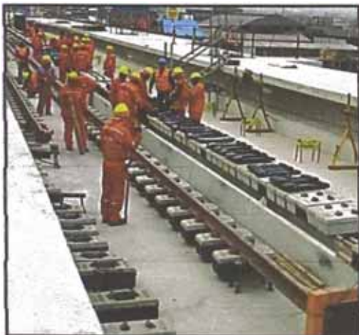
Figura. N°5.81 Soporte provisional de rieles Fuente propia
