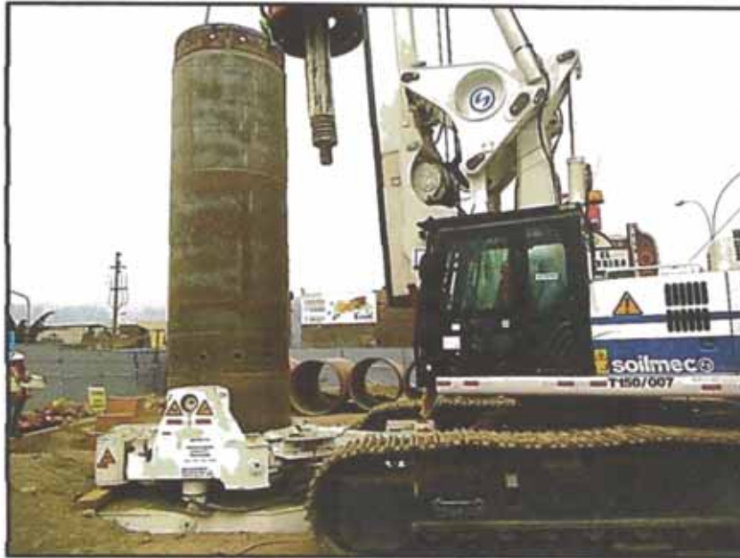
Figura N°5.4: Colocación de la camisa rotando con la KDK
