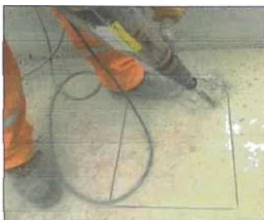
Figura N° 5.35b. Escarificado de la superficie (Fuente: Propia).
