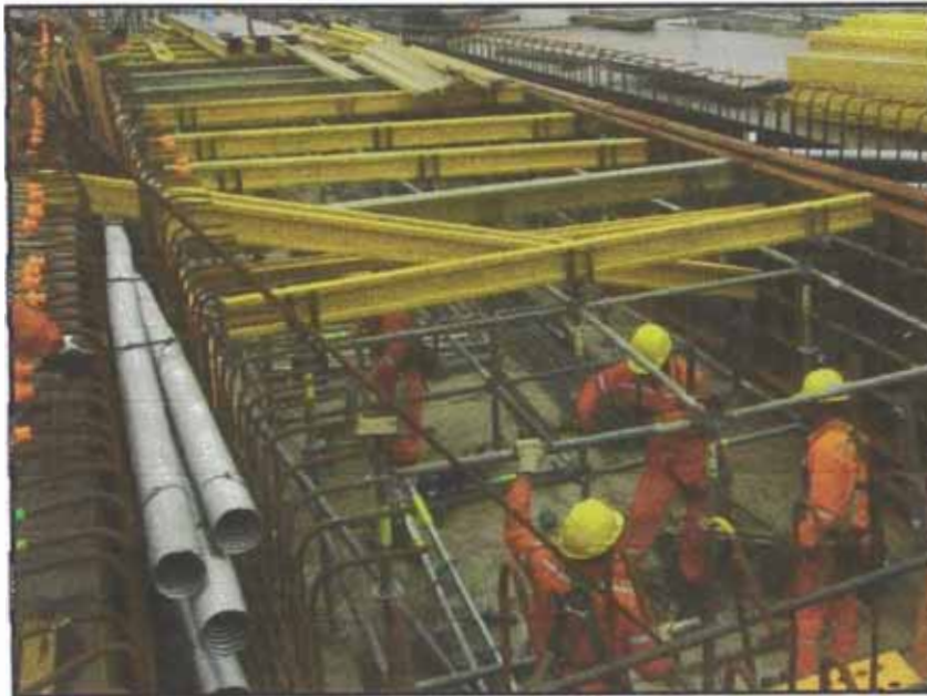
Figura N°5.46: Encofrado interno de viga cajón
