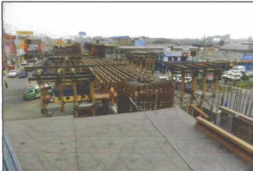
Figura N°5.37: Encofrado del fondo de viga cajón
