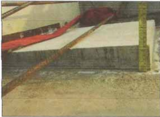
Figura N° 5.35g. Desencofrado (Fuente: Propia).
