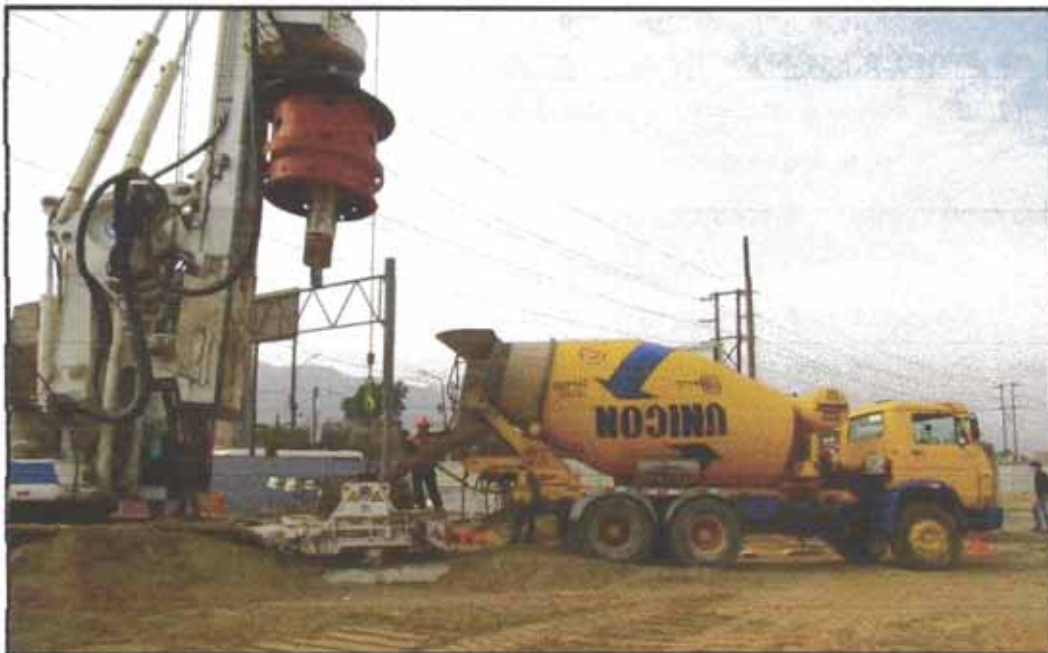
Figura N°5.13: Vaciado del pilote
