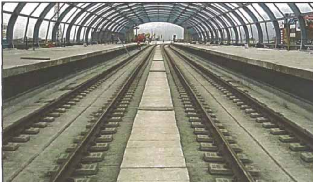
Acabado de la vía férrea
