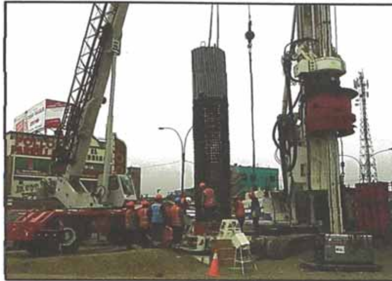
Figura N°5.8: Colocación de la armadura del pilote
