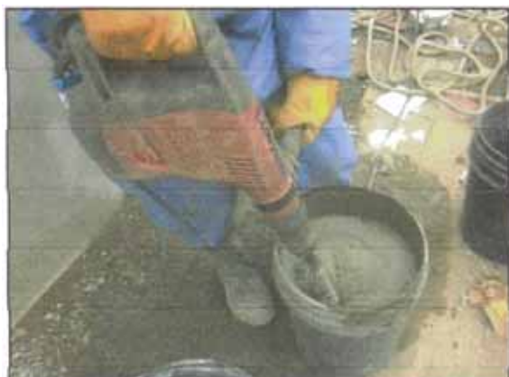
Figura N° 5.35e. Preparación de la mezcla de grout (Fuente: Propia).
