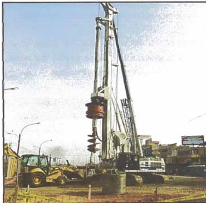
Figura N°5.6: Perforación de un pilote
