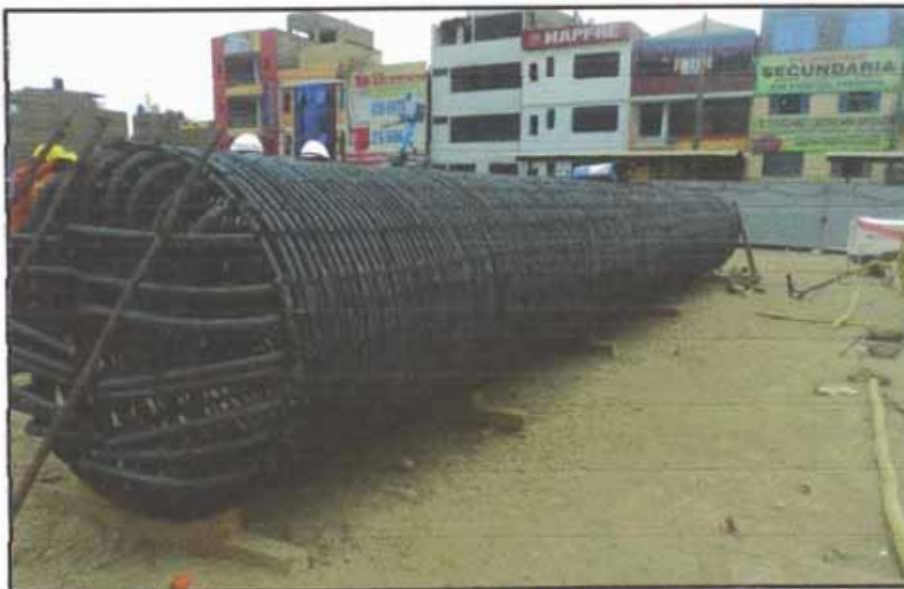
Figura N°5.22a: Armadura de acero para zapatas
