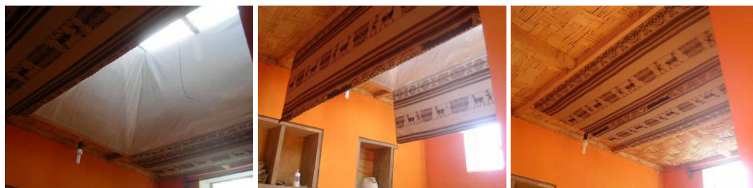
Figura 3. Claraboya implementada en la vivienda solar activa construida en Espinar, Cuzco a 4000 msnm. [27]
