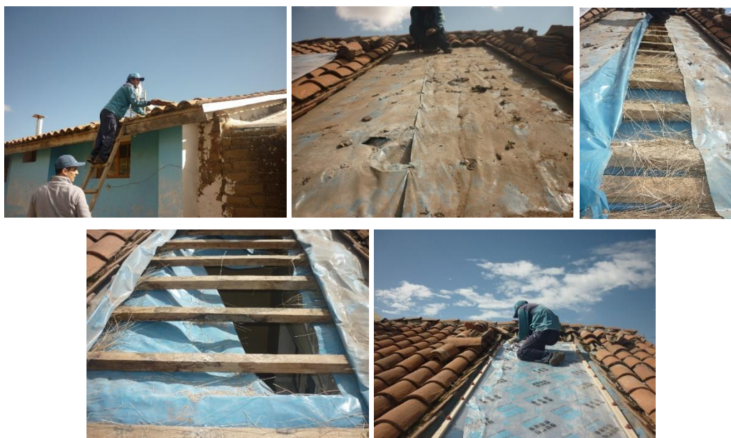
Figura 38. Proceso de implementación de las claraboyas en el año 2015.
