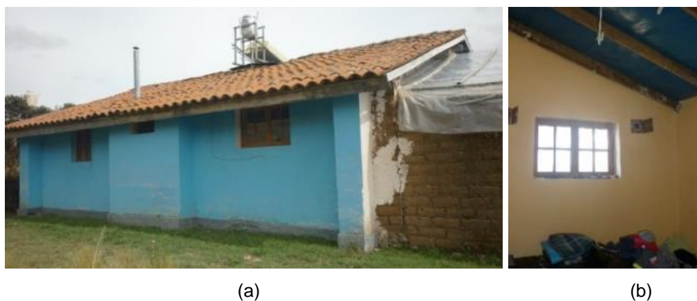
Figura 39. Albergue antes de la instalación de la claraboya, año 2014: (a) la fachada sur y (b) el ambiente interior del dormitorio D2.
