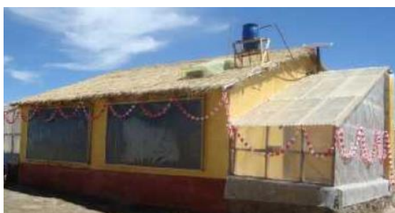
Figura 4. Vivienda construida en la comunidad Vilcallamas Arriba, Puno [28].
