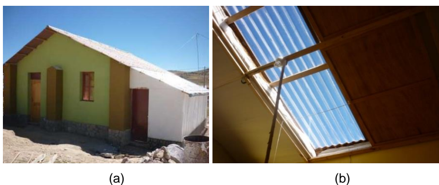
Figura 6. Vivienda construida por el CER – UNI en San Felipe, Huancavelica: (a) fotografía de la vivienda nueva y (b) fotografía de la cobertura de madera deslizable para aislamiento térmico durante la noche [31].
