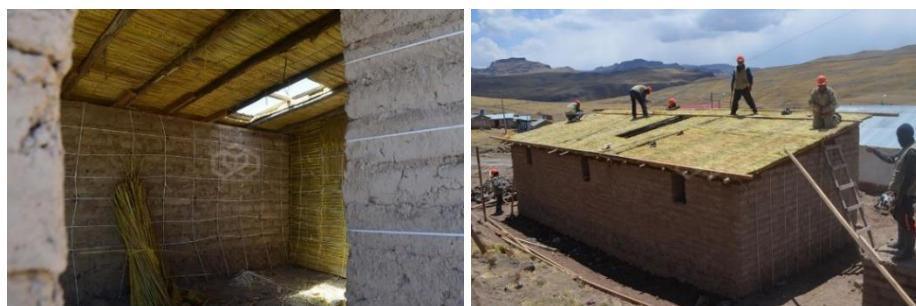
Figura 8. Construcción del prototipo de la vivienda altoandina en la Orduña, Puno (4765 msnm) desarrollado por el grupo de investigación Centro Tierra - PUCP [36].
