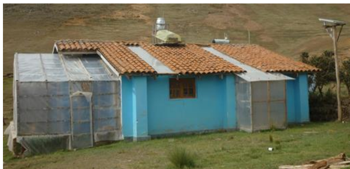
Figura 34. Fotografía del albergue de SFR, construido durante el año 2010.
