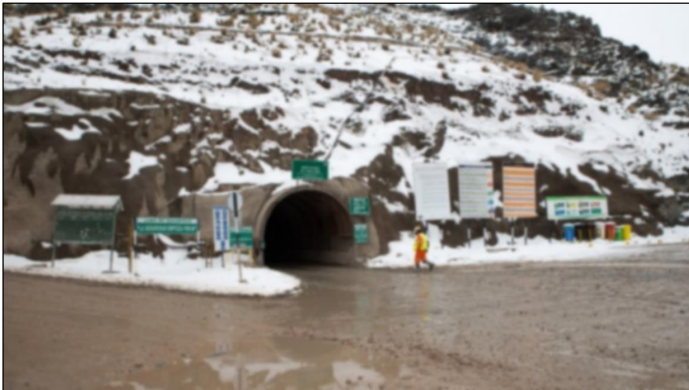
Figura 21. Entrada a operaciones en mina subterránea.
