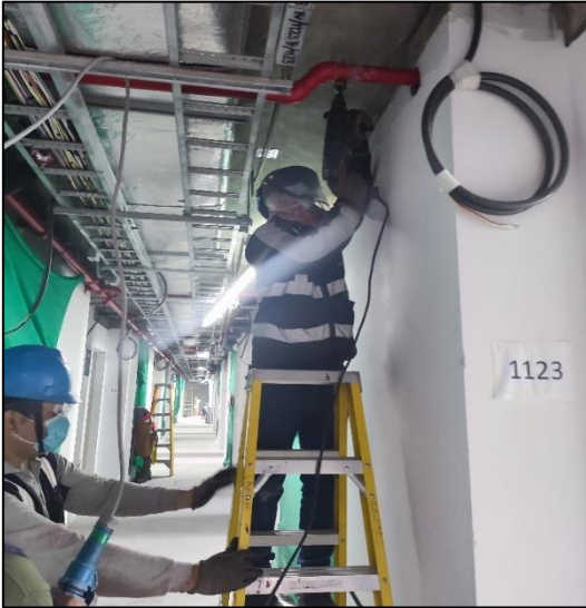
Trazado y taqueado de soportería en el proyecto Hotel Vistamar
