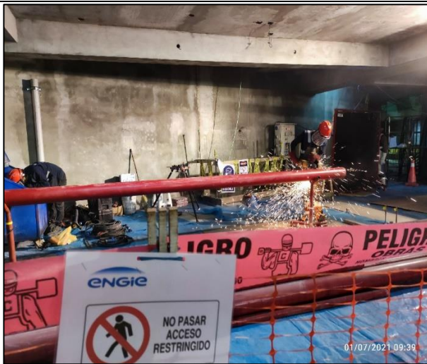
Taller de habilitado de tubería ACI
