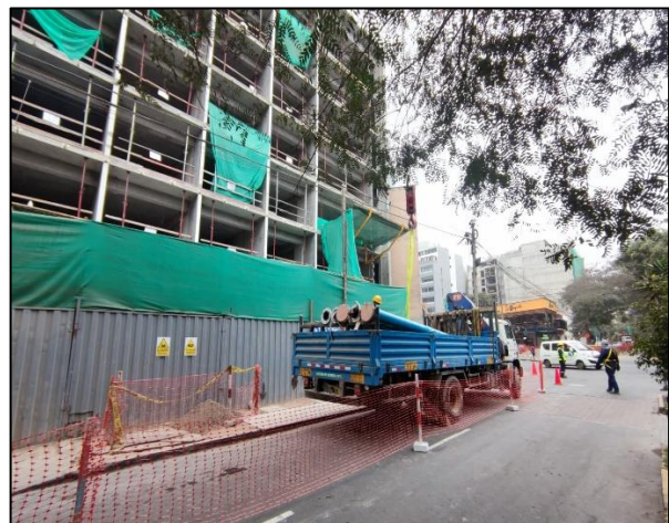
Izaje de tuberías de la línea de gas de la motobomba
