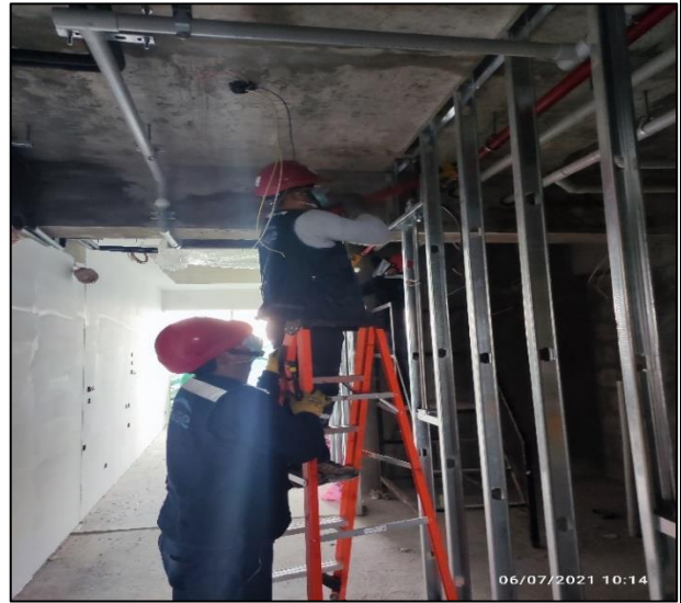
Instalación de tuberías ACI
