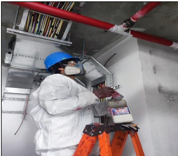
Pintado de tuberías ACI
