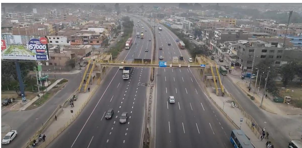
Fotografía N° 12: Puente Peatonal Los Ficus (Nogales)
