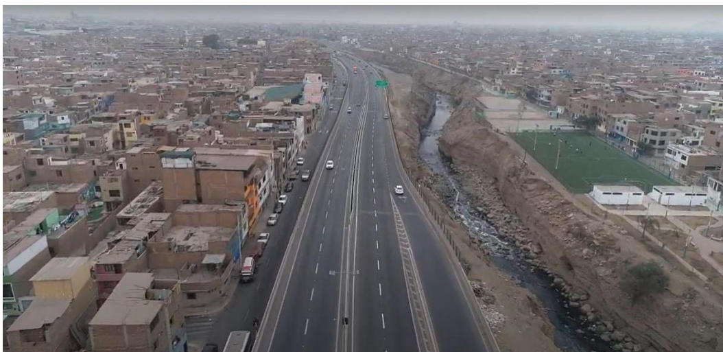
Fotografía N° 63: Estabilizador Vial N° 01
