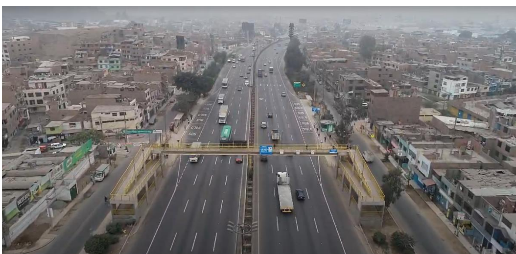
Fotografía N° 16: Puente Peatonal Manuel Ugarteche
