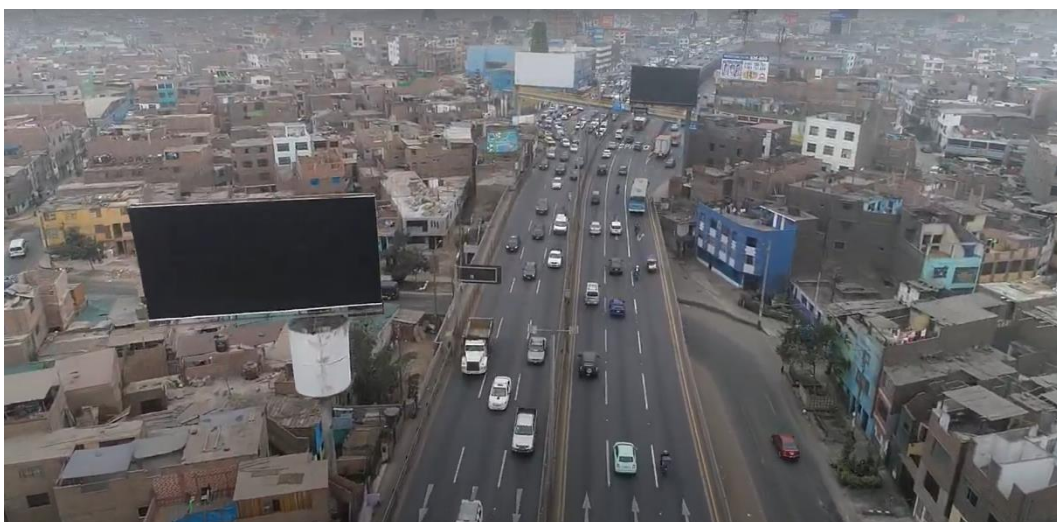
Fotografía N° 34: Puente Vehicular San Félix
