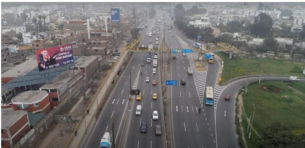
Fotografía N° 02: Puente Peatonal Paradero 11
