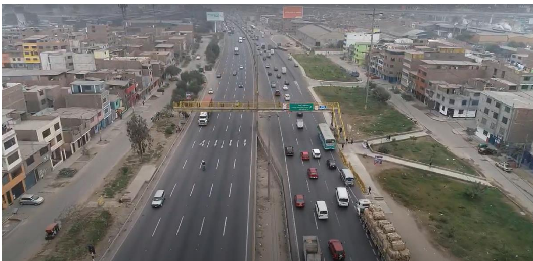
Fotografía N° 25: Puente Peatonal Primavera
