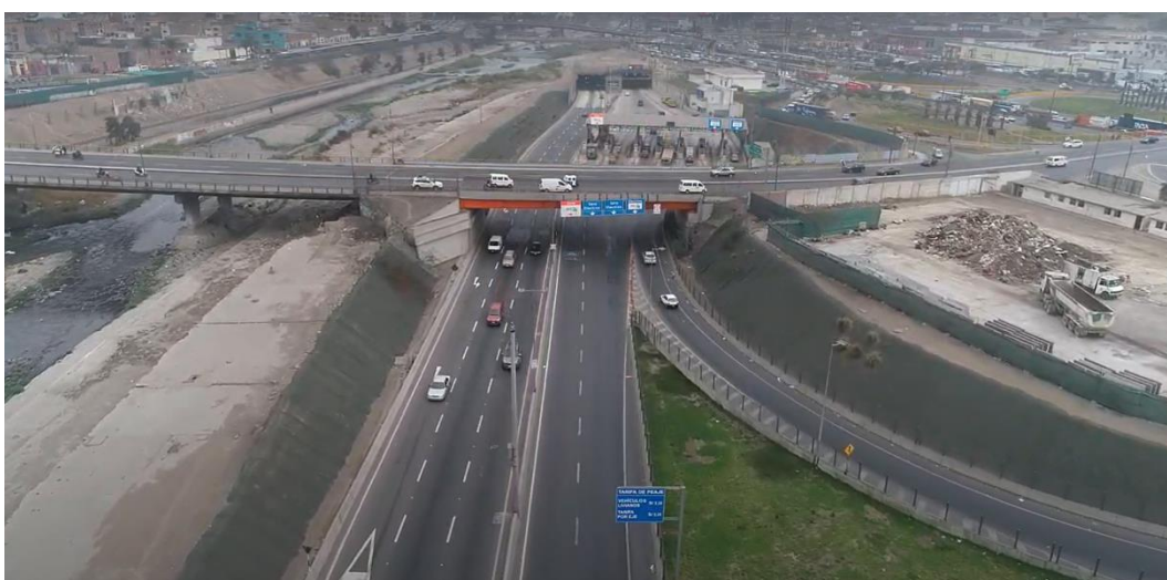
Fotografía N° 40: Paso Inferior Huánuco
