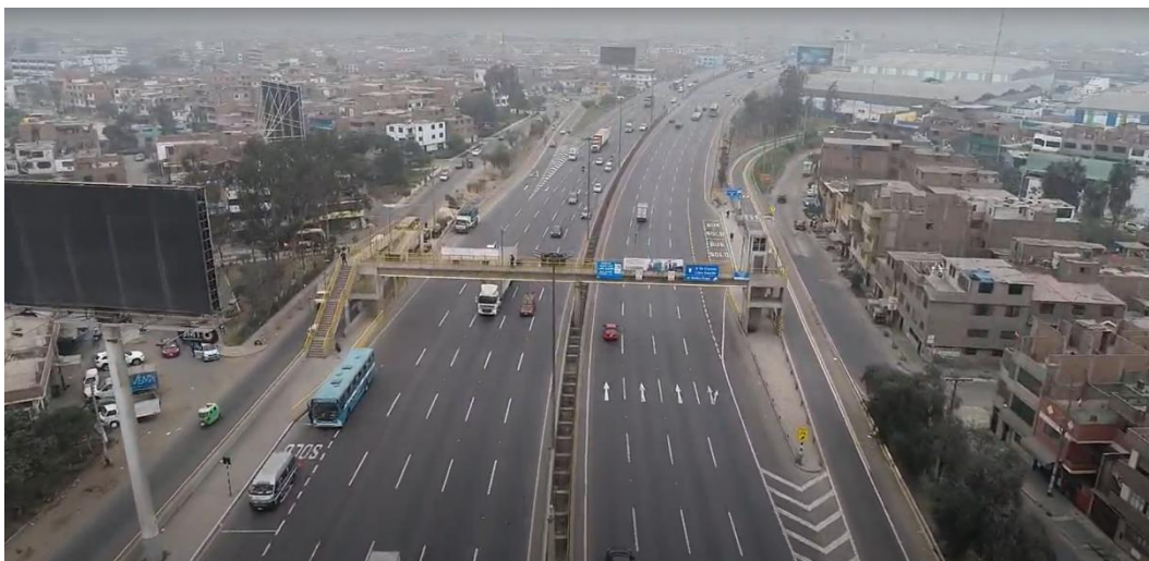
Fotografía N° 17: Puente Peatonal Atarjea (Morro)
