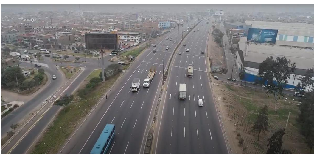
Fotografía N° 18: Puente Vehicular Atarjea
