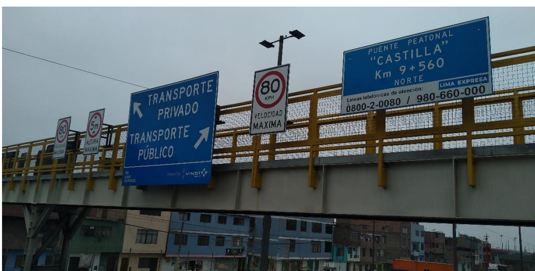
Fotografía N° 30: Puente Peatonal Castilla
