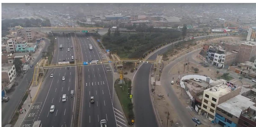
Fotografía N° 20: Puente Peatonal Ramiro Prialé
