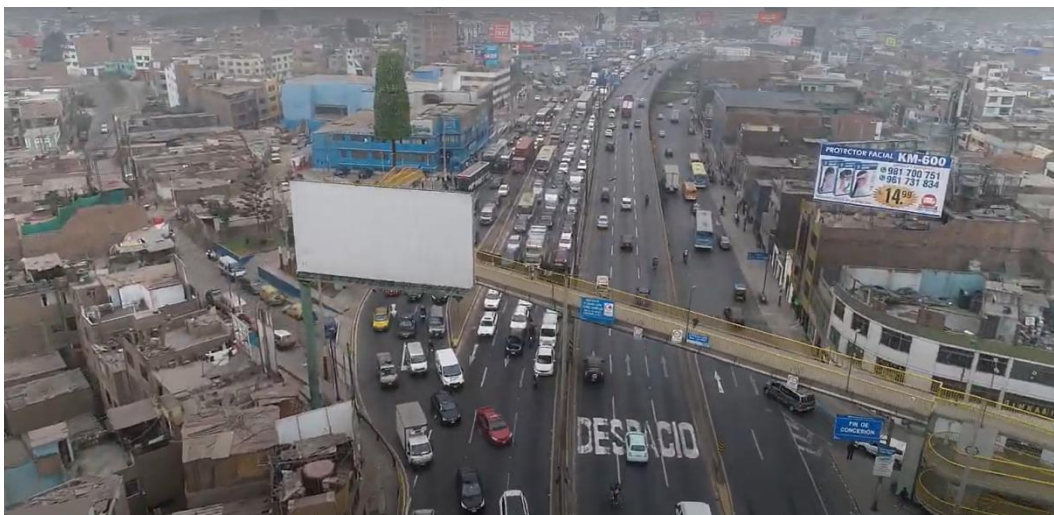
Fotografía N° 35: Puente Peatonal Municipal San Martín
