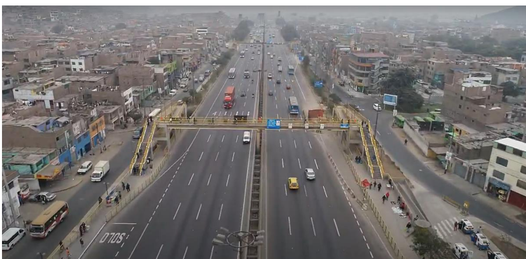
Fotografía N° 14: Puente Peatonal Cooperativa Universal (Ancash)
