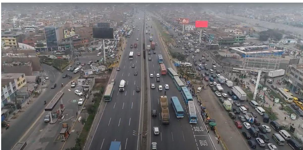
Fotografía N° 24: Puente Vehicular Nuevo
