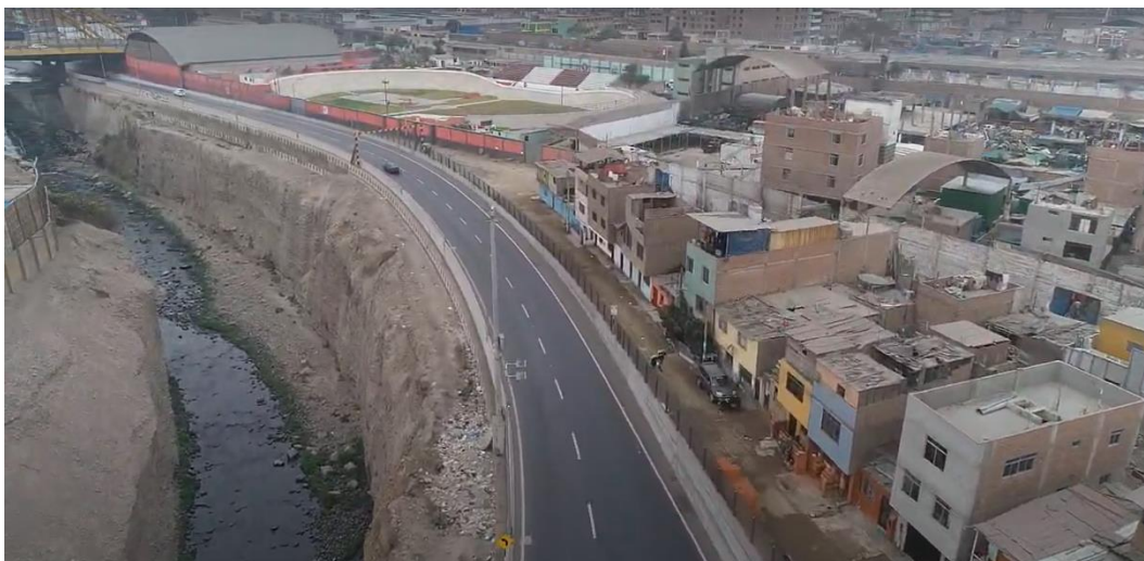
Fotografía N° 51: Estabilizador Vial N° 04
