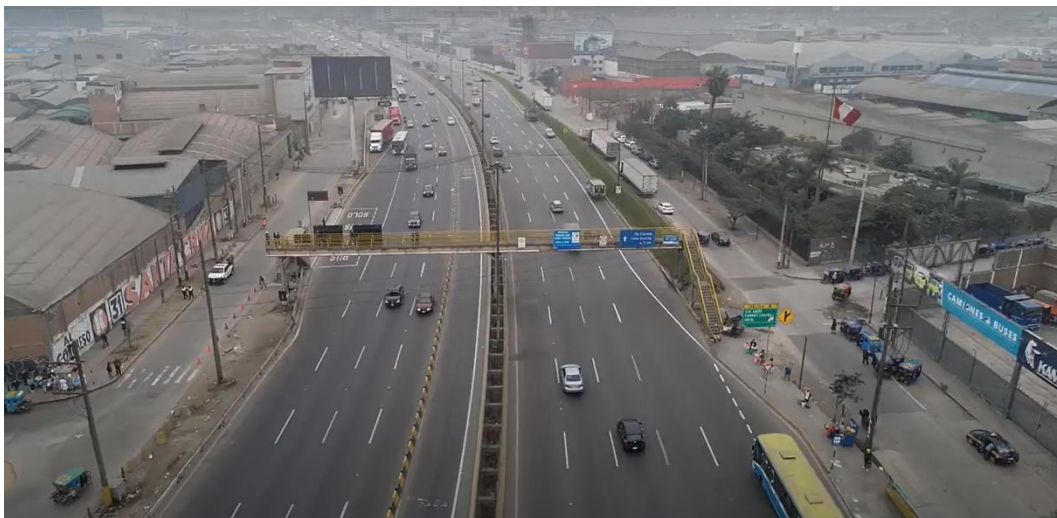
Fotografía N° 09: Puente Peatonal Santa Rosa
