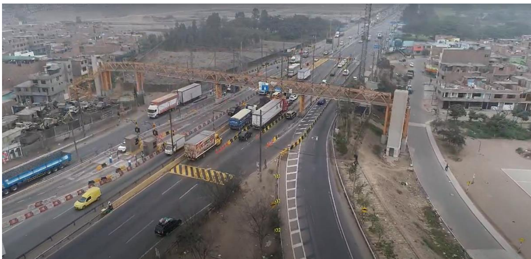
Fotografía N° 21: Estación de Peaje Ramiro Prialé y Puente Peatonal Peaje Fuente: MML
