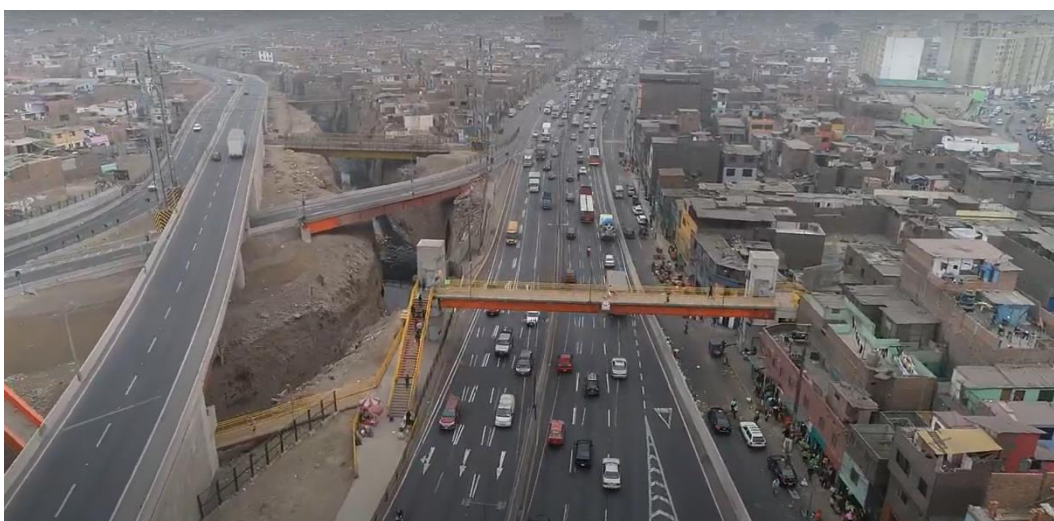
Fotografía N° 56: Puente Peatonal Nuevo Pocitos
