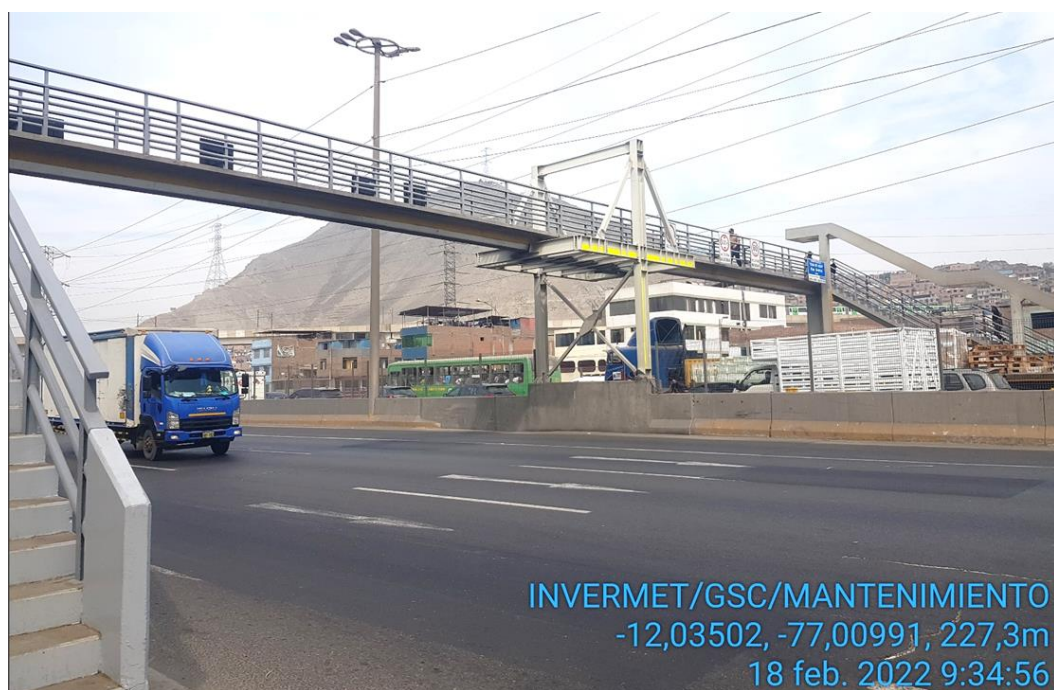
Fotografía N° 26: Puente Peatonal Caja de Agua
