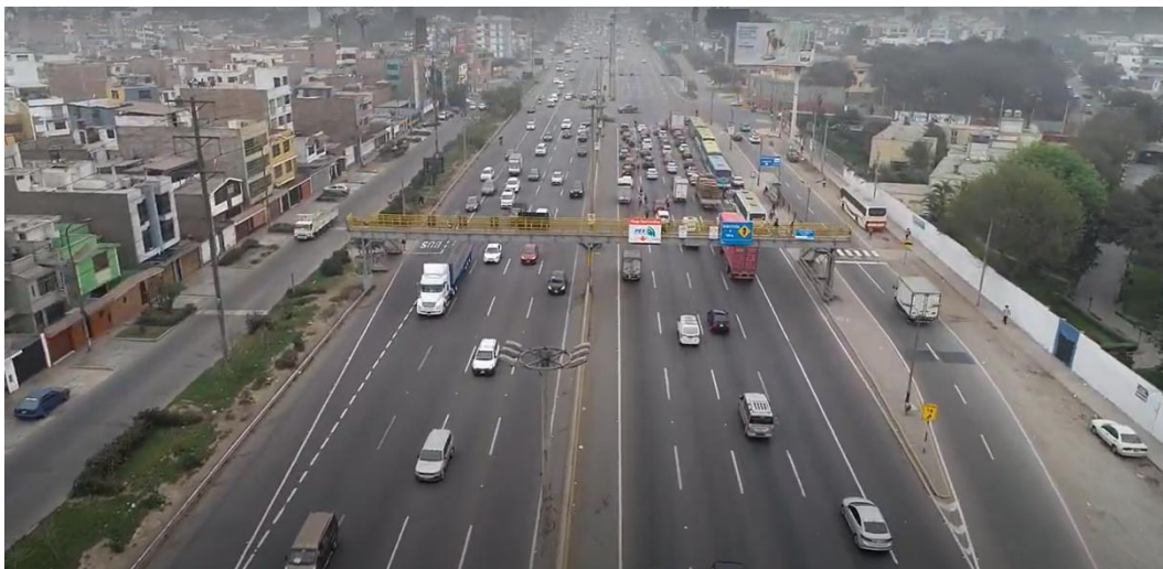
Fotografía N° 05: Puente Peatonal Las Palmeras
