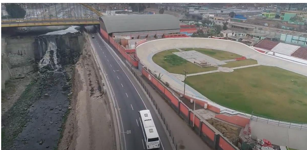
Fotografía N° 50: Estabilizador Vial N° 05
