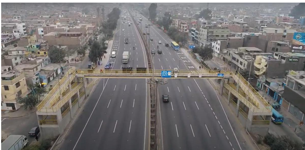
Fotografía N° 13: Puente Peatonal 07 de Junio (Brisas)
