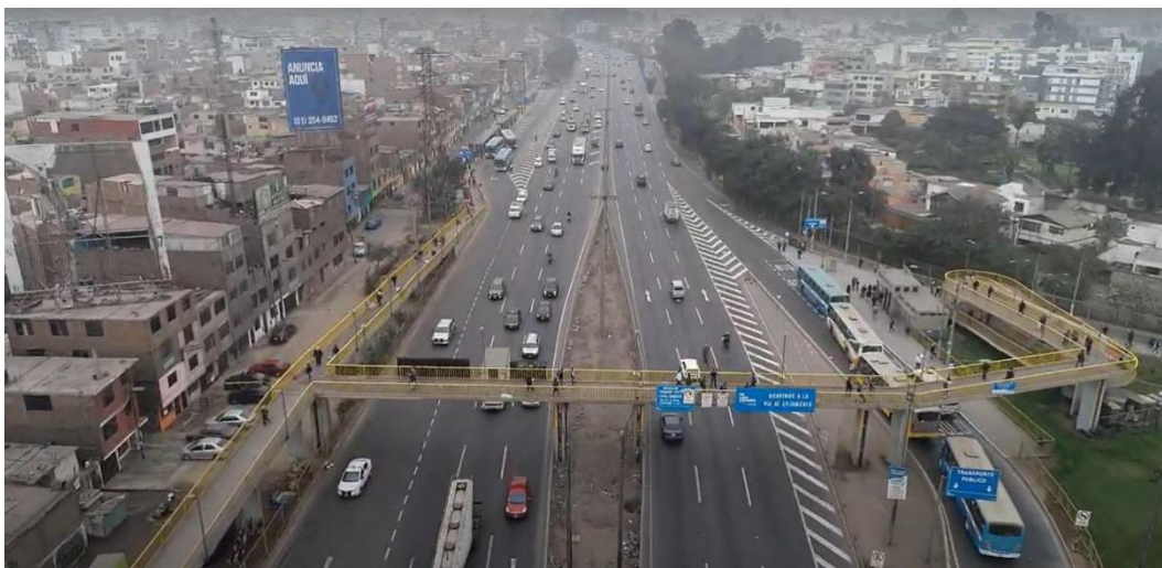
Fotografía N° 03: Inicio de la Obra Especial Cuarto Carril
