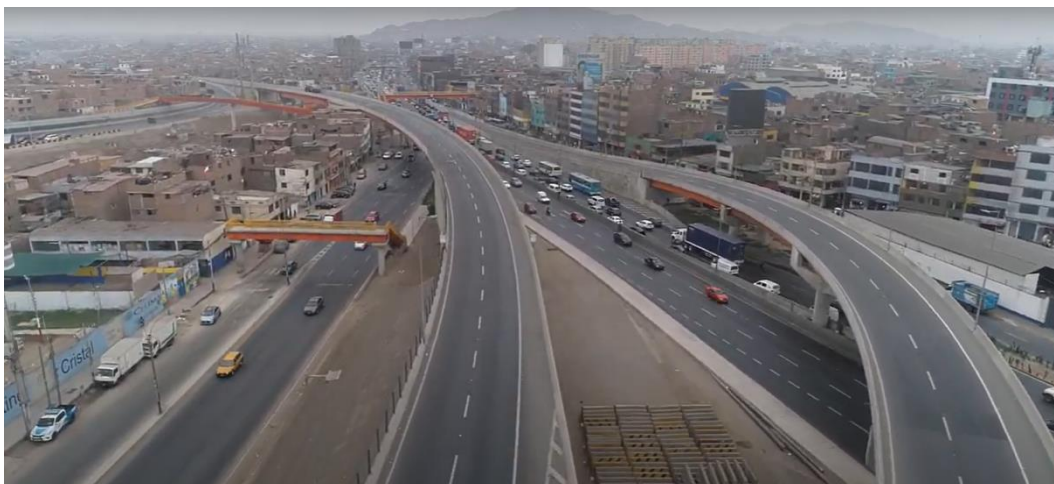
Fotografía N° 49: Puente Peatonal Colegio
