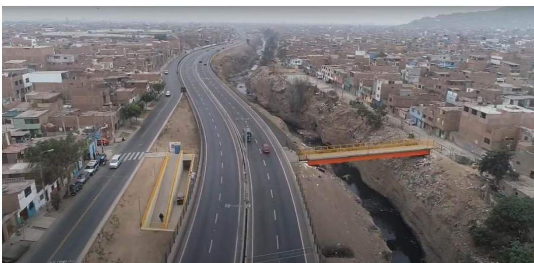
Fotografía N° 60: Puente Peatonal 03 De Mayo
