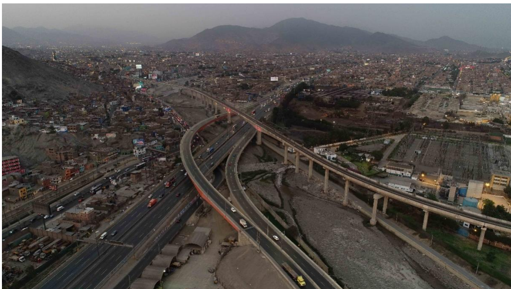
Fotografía N° 37: Viaducto N° 09 y Viaducto N° 10
