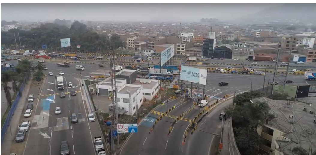
Fotografía N° 08: Estación de Peaje Separadora Industrial
