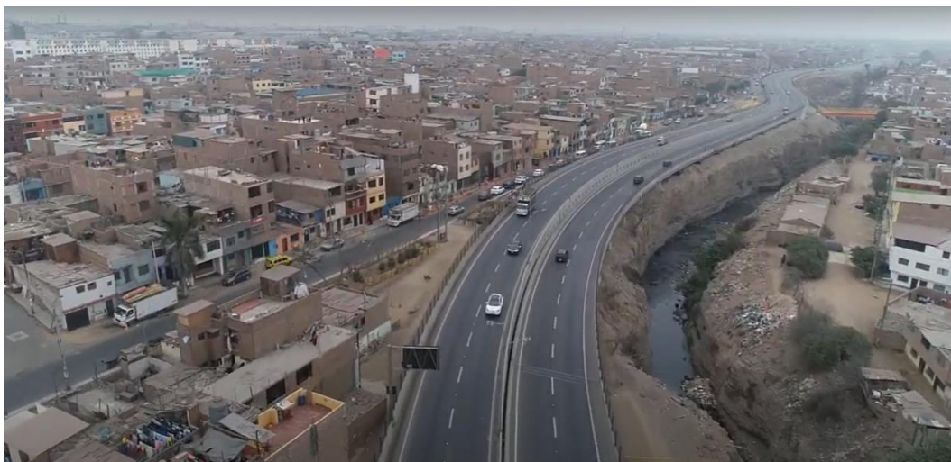
Fotografía N° 59: Estabilizador Vial N° 03
