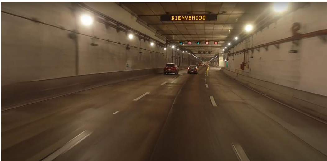
Fotografía N° 43: Interior del Túnel Línea Amarilla (Lima Expresa)
