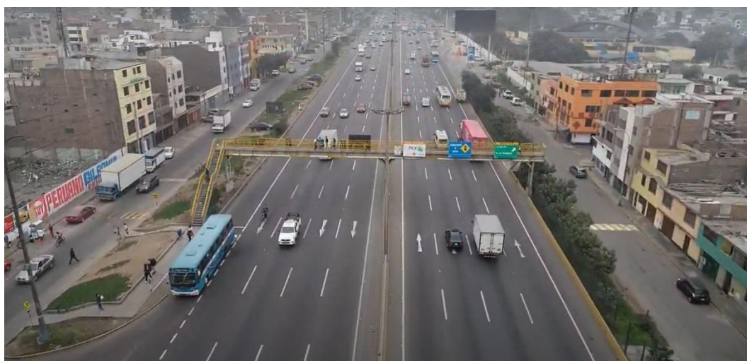
Fotografía N° 04: Puente Peatonal Los Quechuas
