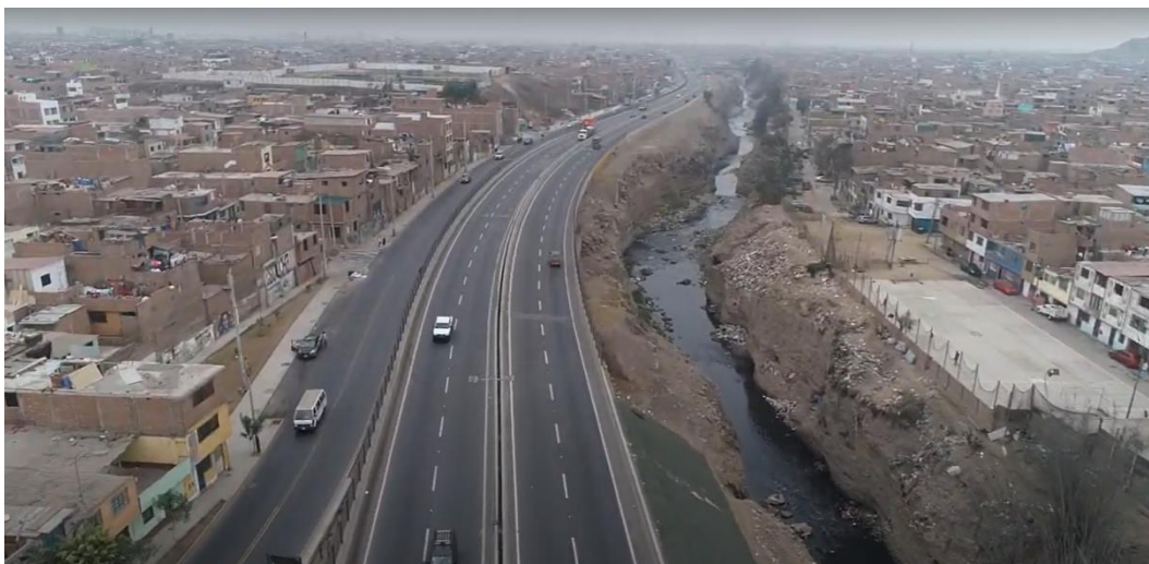
Fotografía N° 61: Estabilizador Vial N° 02
