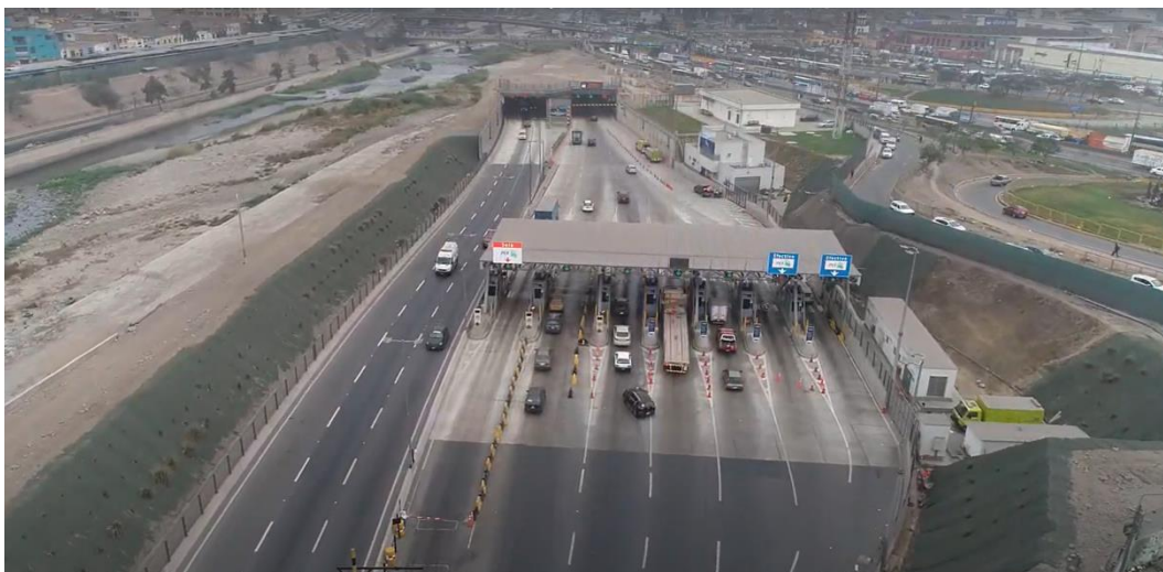
Fotografía N° 41: Peaje N° 03 (Peaje Huánuco)
