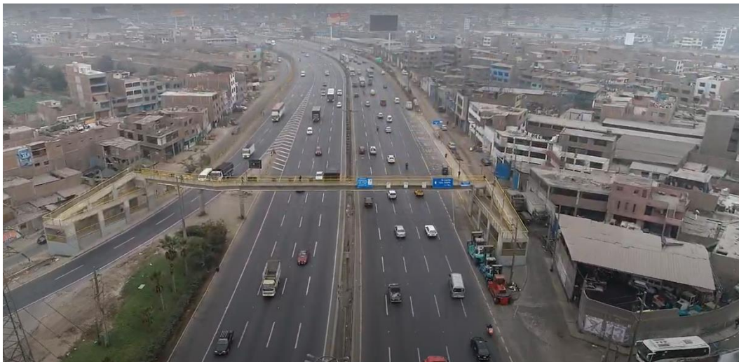
Fotografía N° 23: Puente Peatonal Perú - Japón
