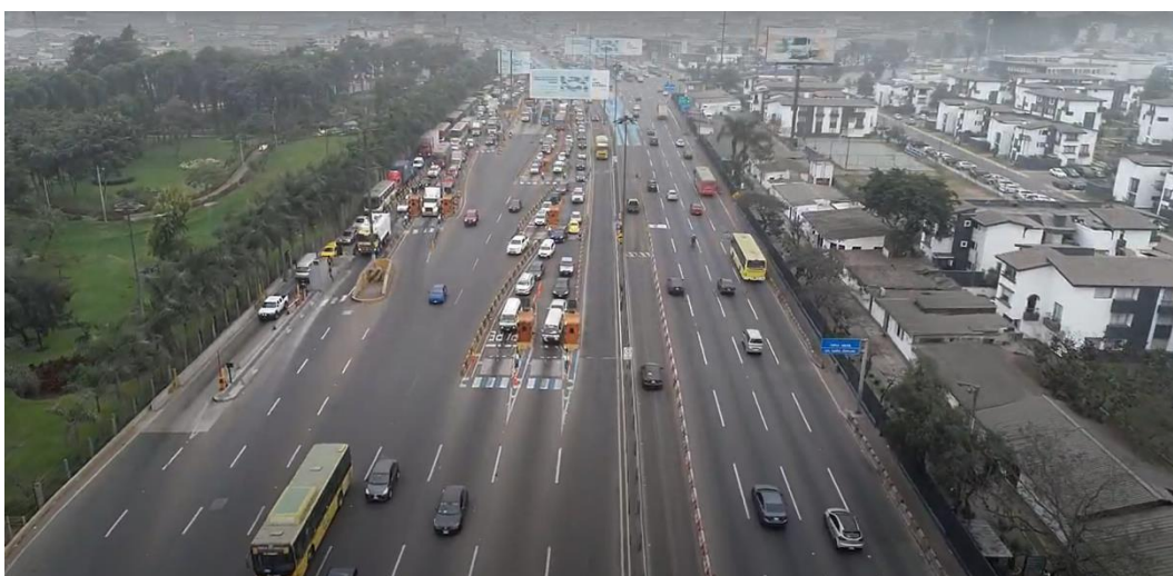
Fotografía N° 06: Estación de Peaje Monterrico Sentido Sur
