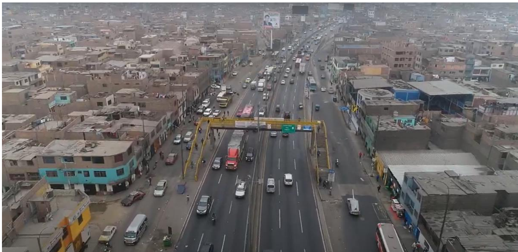
Fotografía N° 33: Puente Peatonal Control
