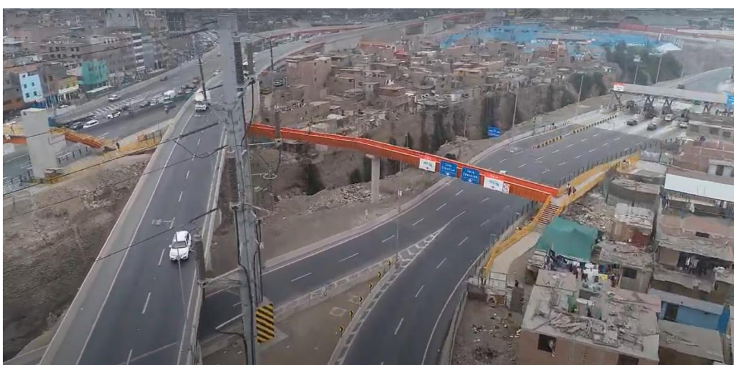
Fotografía N° 54: Puente Primero De Mayo
