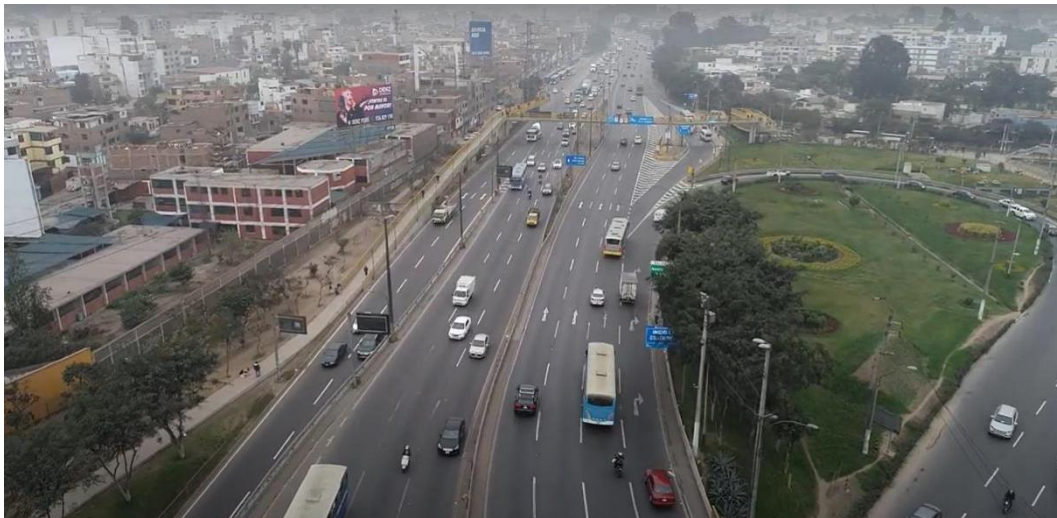
Fotografía N° 01: Trébol Javier Prado - Inicio de la Concesión
