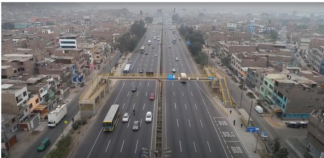
Fotografía N° 15: Puente Peatonal G. Lobatón (Vallejo)
