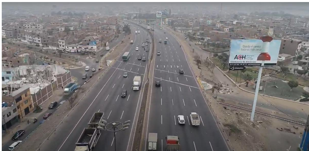
Fotografía N° 19: Puente Vehicular Ferrocarril
