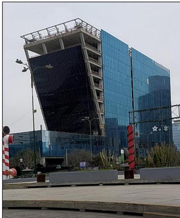
Fotografía N°12: Vista del exterior durante la ejecución del Proyecto. Instalación del muro cortina.
