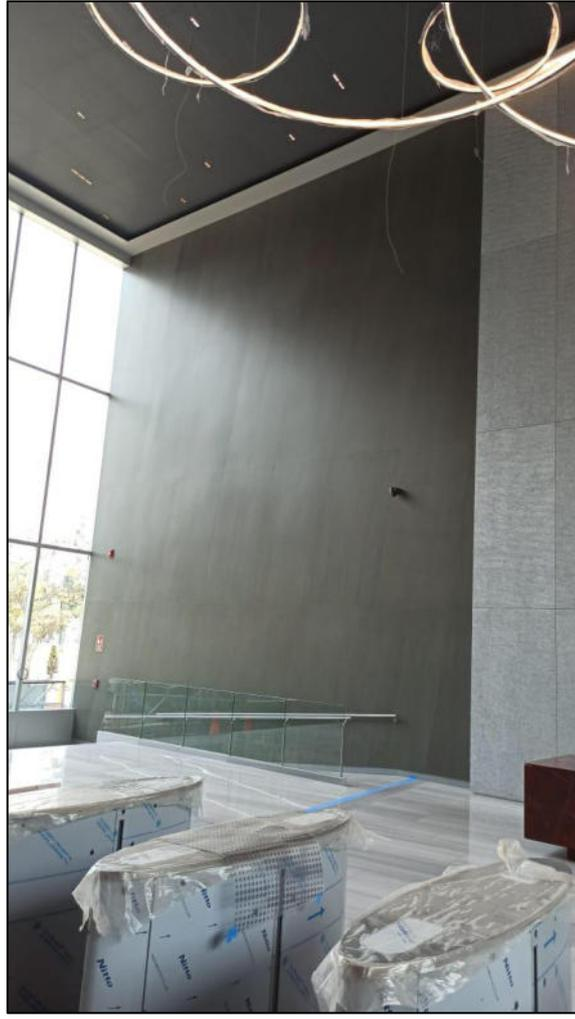
Fotografía N°6: Área del lobby principal de triple altura con laminados en muros de madera alpi y falso cielo raso de baldosas metálicas tipo ranuradas.
