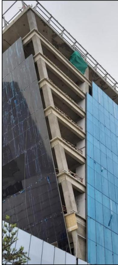
Fotografía N°13: Vista del exterior durante la ejecución del Proyecto. Instalación del muro cortina.
