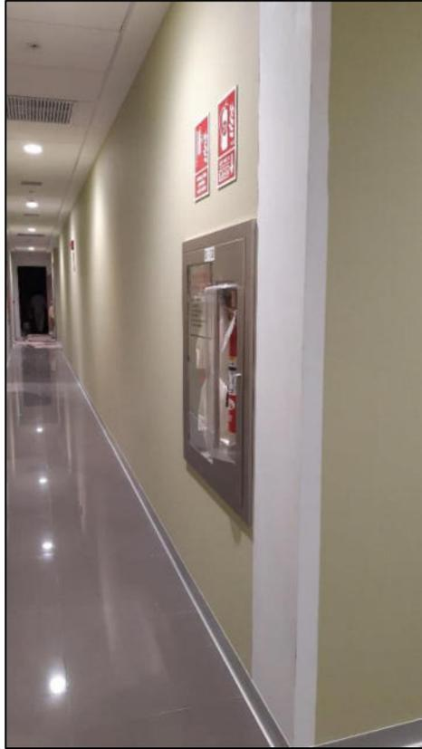
Fotografía N°10: En la Foto se muestra acabados en muros con vinil y pisos enchapados con baldosas de vinil. Los falso cielos rasos de tipo baldosas.
