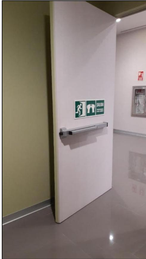
Fotografía N°11: Puerta de madera con acabado vinil. Se nota el acabado de los enchapes con porcelanato tipo pulido.
