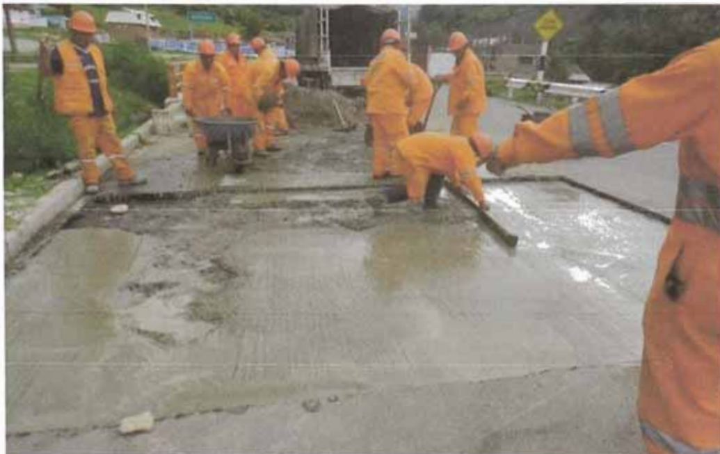
Figura N°2.4: Conservación de pavimentos rígidos
