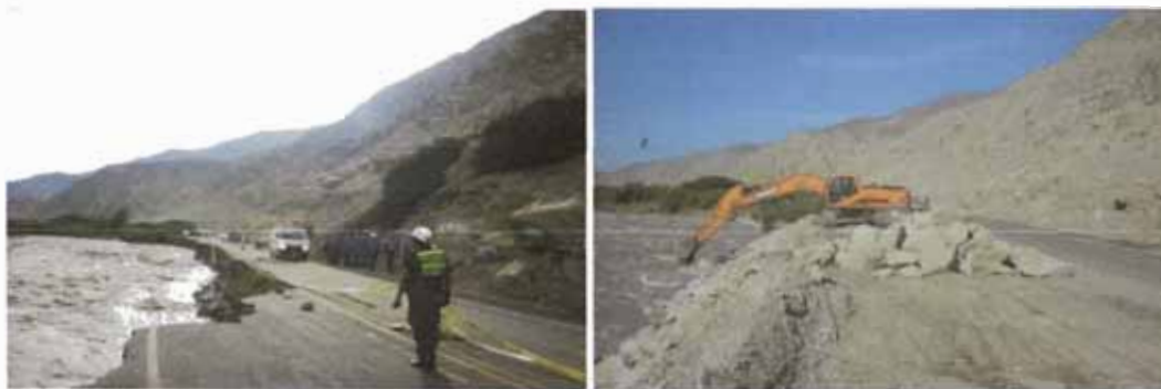
Figura N°1.9: Trabajos de emergencia
