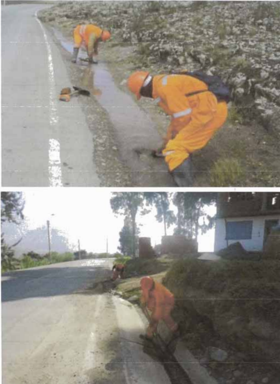
Figura N°2.5: Limpieza de cunetas revestidas y de tierra
