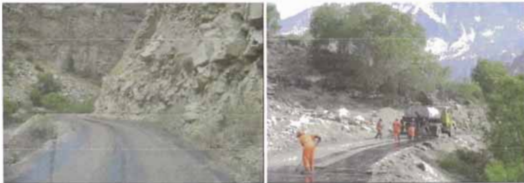
Figura N°1.7: Obras de Mantenimiento Periódico
