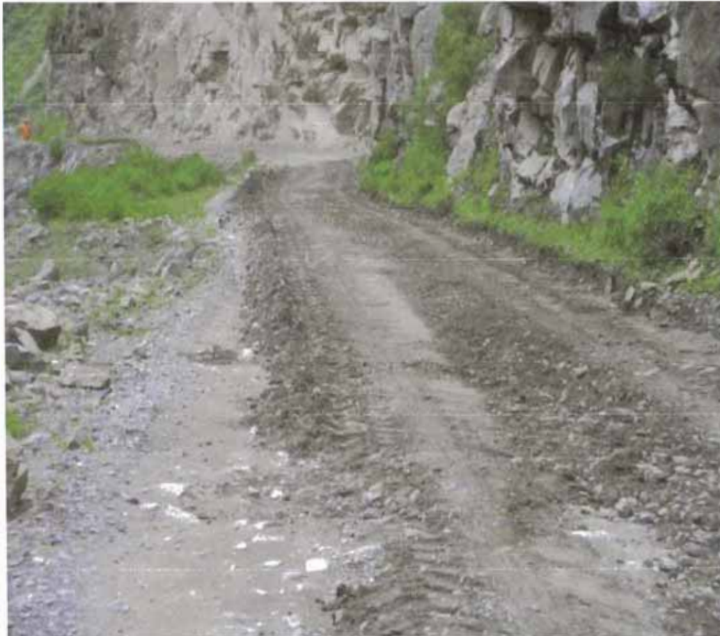
Figura N°2.2: Perfilado de la superficie sin aporte de material
