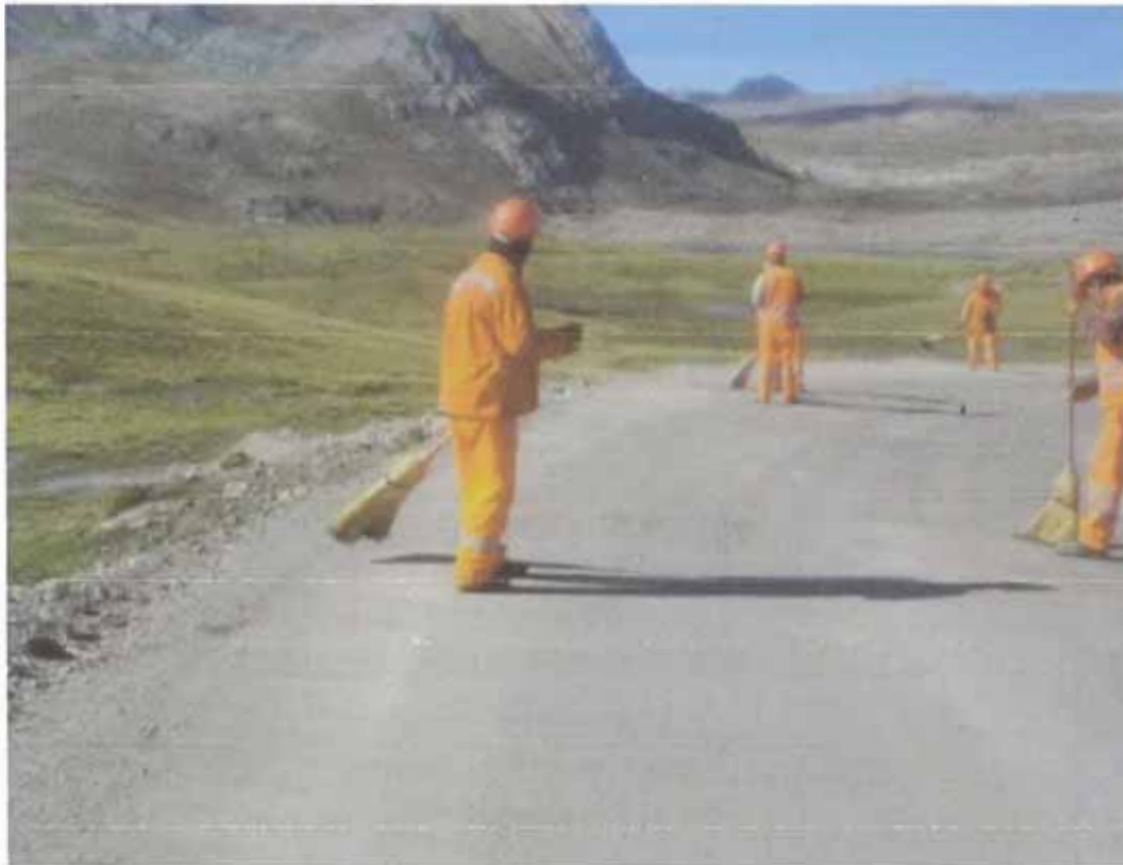
Figura N°2.8: Limpieza – derecho de vía
