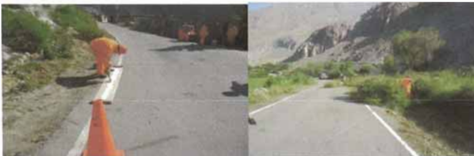
Figura N°1.6: Obras de Mantenimiento Rutinario
