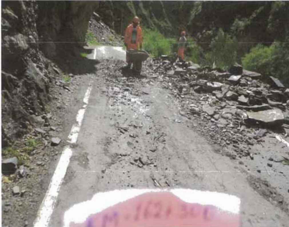
Figura N°2.1: Limpieza o remoción de derrumbes
