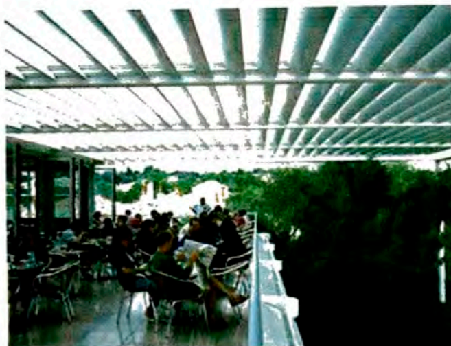
Vista - nivel superior, terraza de cafetería
