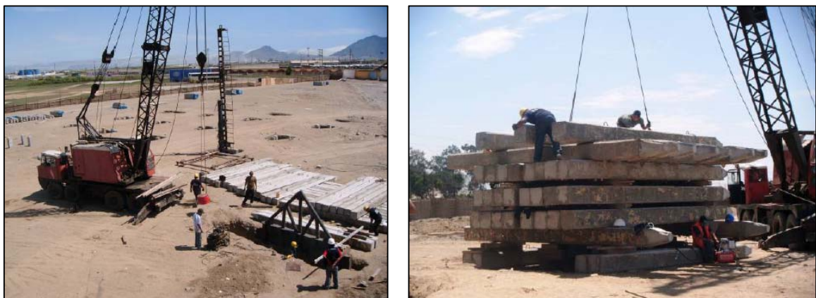
Figura 4.18: Registro Fotográfico del Proceso de PCE Compresión - Chimbote
