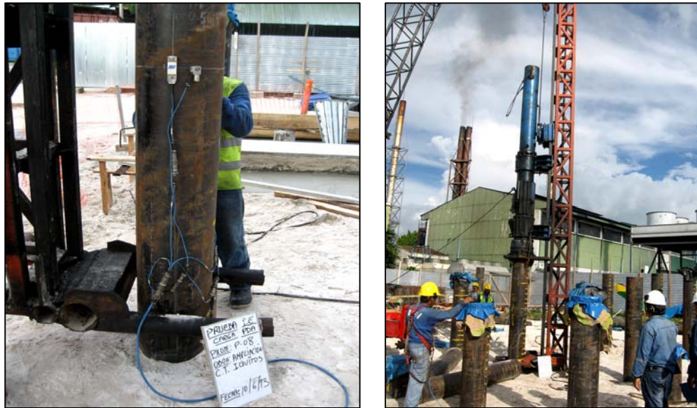
Figura 4.6: Registro Fotográfico del Proceso de Prueba de Carga Dinámica – Iquitos
