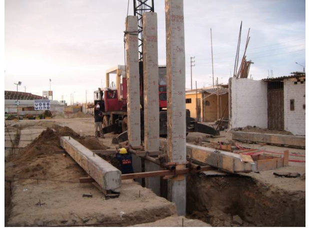
Fotografía N° 10: Montaje y alineamiento de los pilotes.
