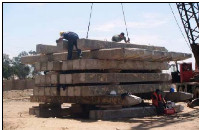
Figura 3.4: PCE a Compresión con Contrapeso para Carga de Ensayo 70 ton en Chimbote, Ancash, Perú
