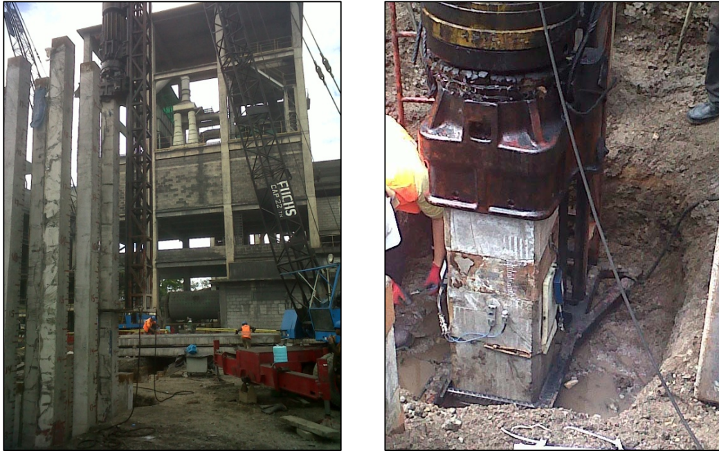
Figura 4.11: Registro Fotográfico del Proceso de Prueba de Carga Dinámica - Rioja
