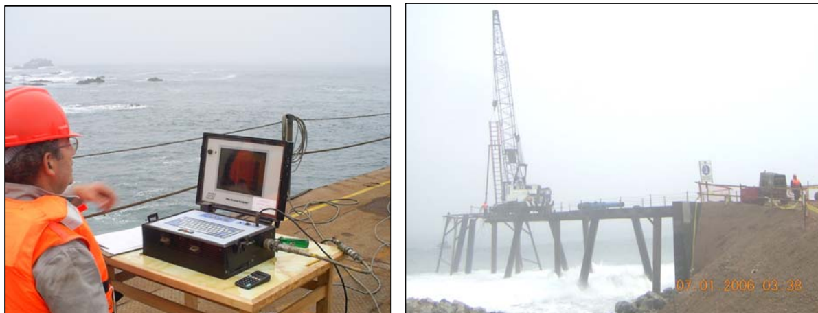
(c) Instrumentación del pilote por medio de los sensores y equipo PDA
