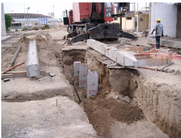
Fotografía N° 11: Posición final de los pilotes hincados.
