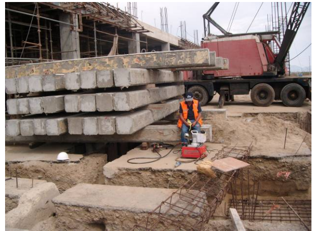
Fotografía N° 4: Ejecución del ensayo. Etapa de aplicación de carga.
