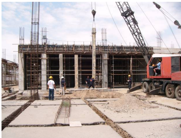
Fotografía N° 1: Posicionamiento de los pilotes previo a la etapa de hincado.
