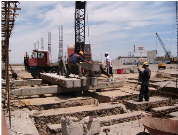
Fotografía N° 3: Colocación de pilotes para la plataforma de carga.
