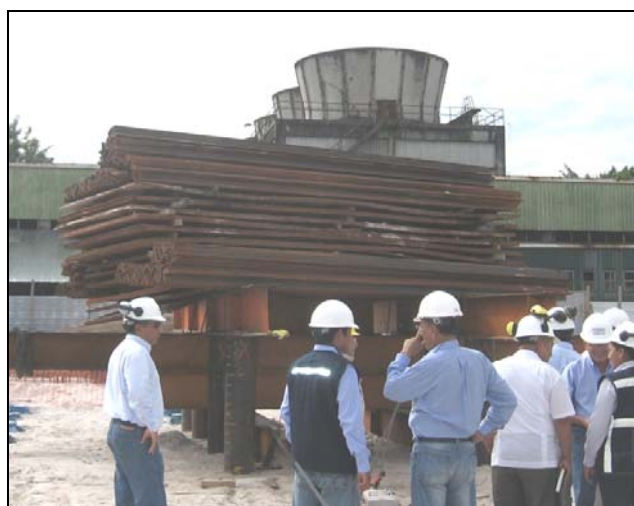
Figura 3.5: PCE a Compresión con Contrapeso + Pilotes de Reacción para Carga de Ensayo 80 ton en Iquitos, Loreto, Perú
