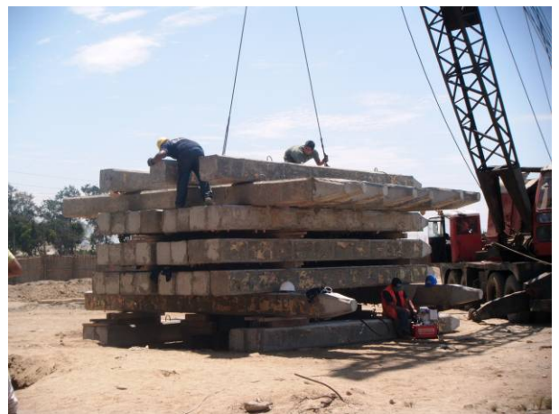
Fotografía N° 8: Colocación de pilotes para la plataforma de carga.
