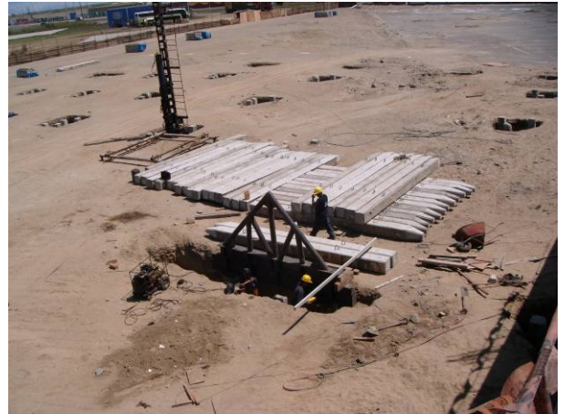
Fotografía N° 6: Soldadura y alineamiento de la viga de reacción.
