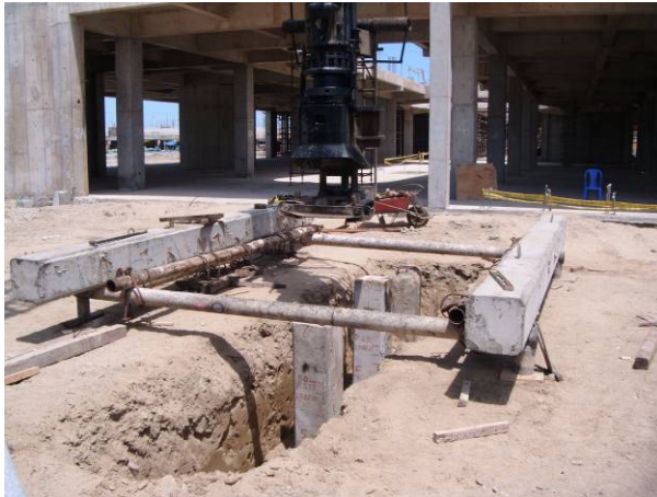
Fotografía N° 5: Posición final de los pilotes posterior al hincado.
