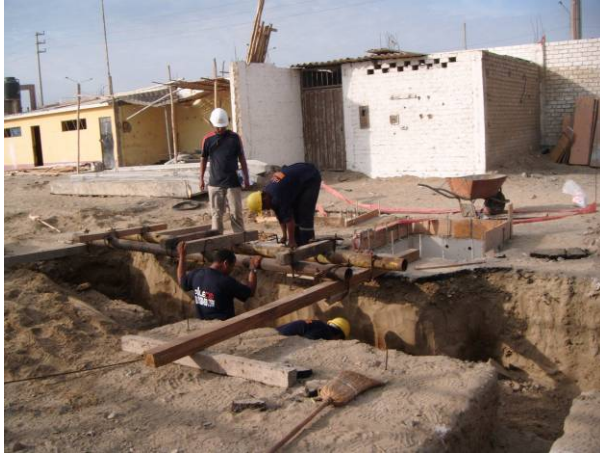
Fotografía N° 9: Colocación de las armaduras de apoyo de los pilotes.
