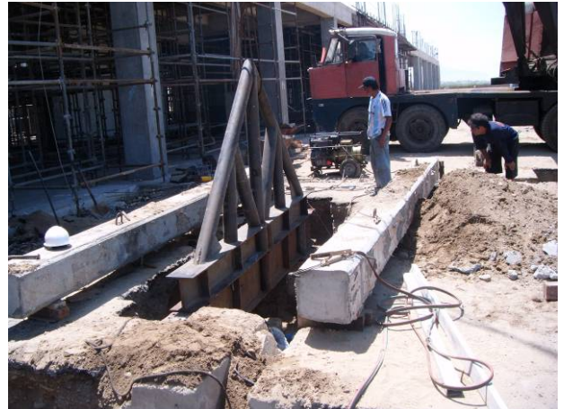
Fotografía N° 2: Montaje de la viga de reacción sobre los pilotes de apoyo.
