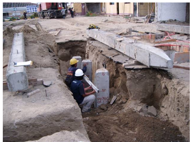
Fotografía N° 12: Marcado de la longitud de descabezamiento de los pilotes.
