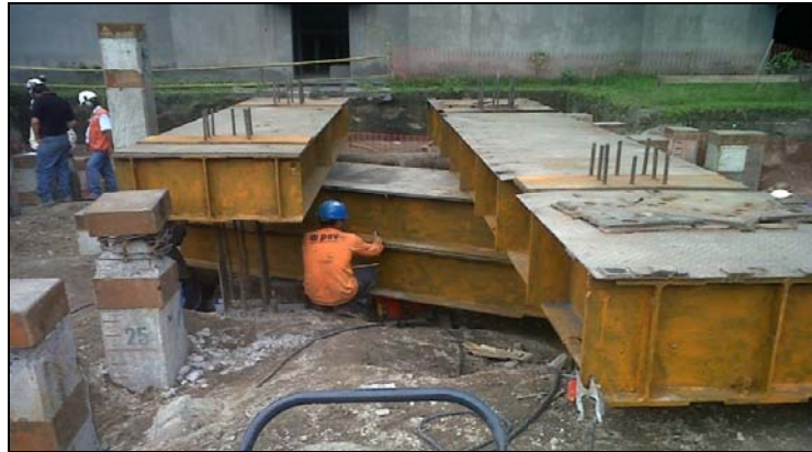
Figura 3.3: PCE a Compresión con Pilotes de Reacción para Carga de Ensayo 240 ton en Rioja, San Martín, Perú
