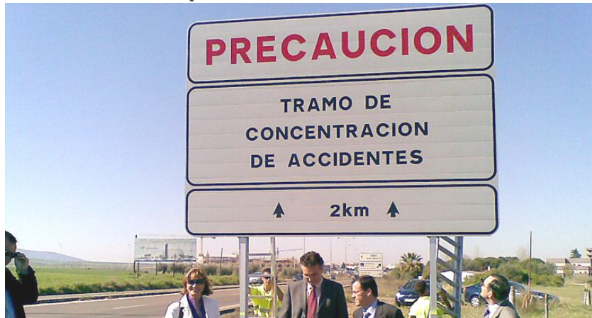
Figura 2.19: Señalización para indicar tramos de concentración de accidentes.
