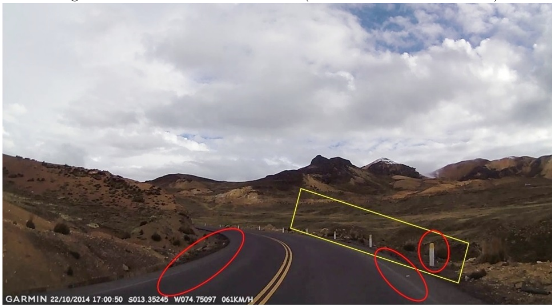
Figura 3.15: EISV en el Km 232+200 (zona con altitud > 3800msnm)
