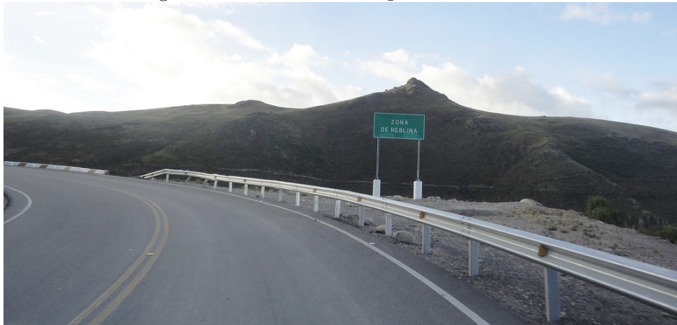
Figura 2.13: Barreras de seguridad metálicas.
