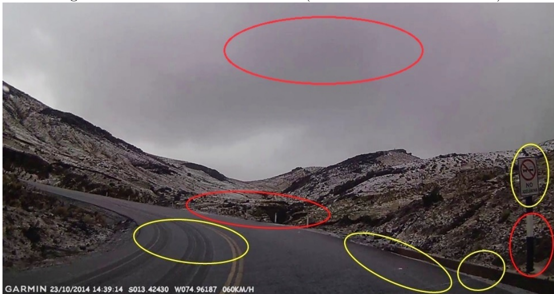
Figura 3.16: EISV en el Km 175+500 (zona con altitud > 3800msnm)
