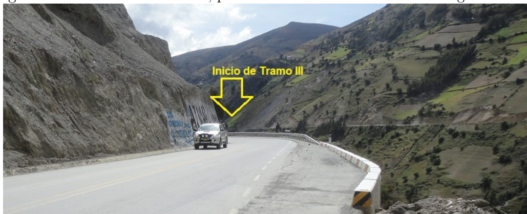
Figura 3.24: Inicio de Tramo III, para desarrollo de la Auditoría de Seguridad Vial.
