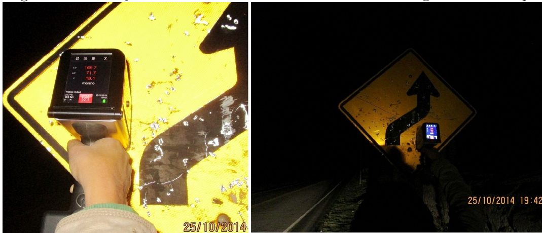
Figura 3.11: Ensayos de retrorreflectometría a señal vertical desgastada en campo.
