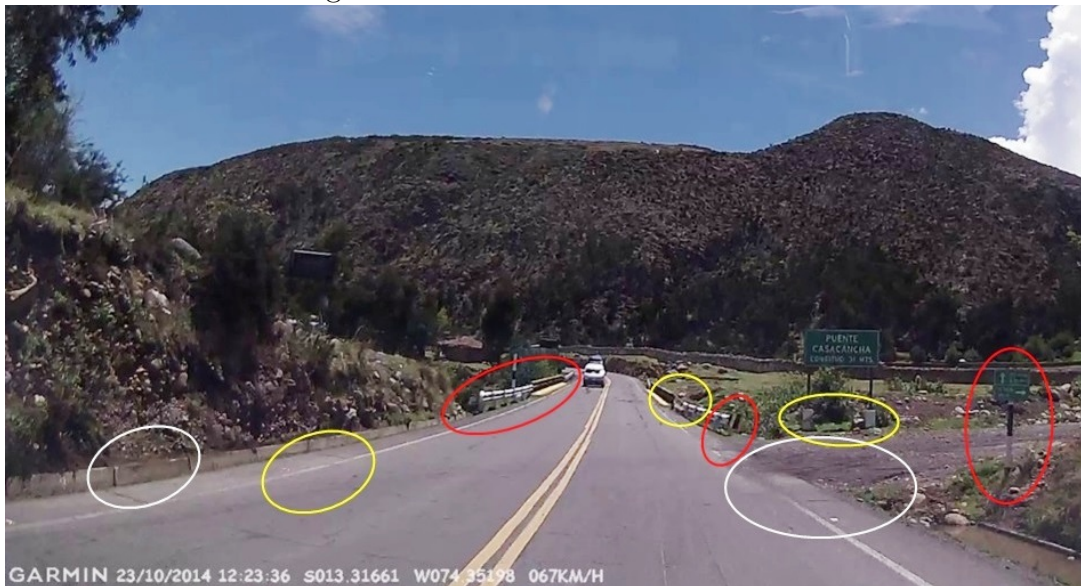
Figura 3.14: EISV en el Km 289+500.
