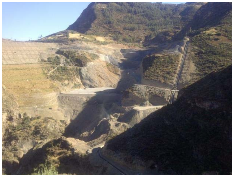
Figura 6.01: Construcción de la primera etapa del depósito de relaves Ramahuayco
