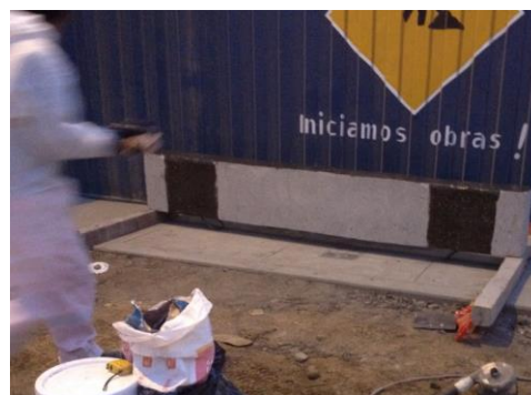
Foto 2: Aplicación del refuerzo Externo FRP – Tyfo SCH-41 en Vigas.
