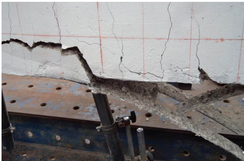
Foto 9: Detalle de Rotura de las fibras de carbono en la parte central.
