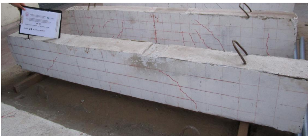
Foto 13: Elevación de Viga VF-03, después del ensayo.
