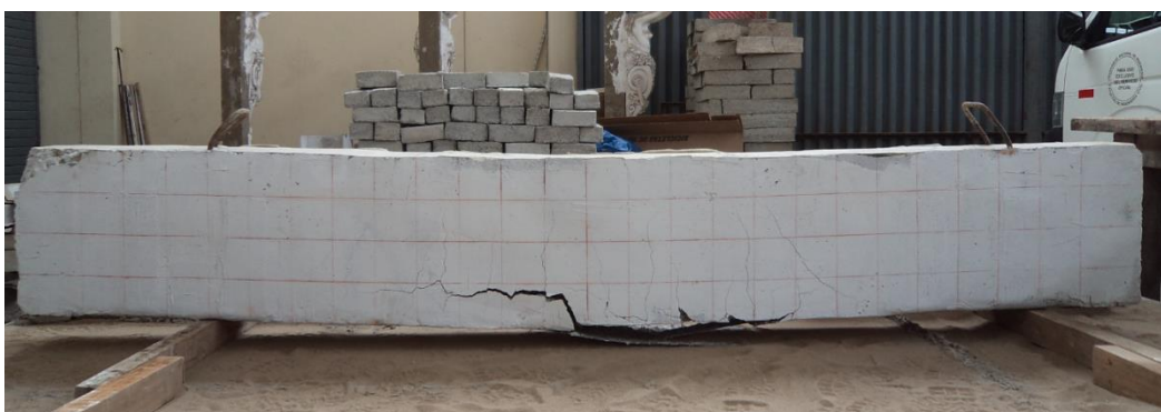
Foto 8: Elevación de Viga VF-01, después del ensayo.
