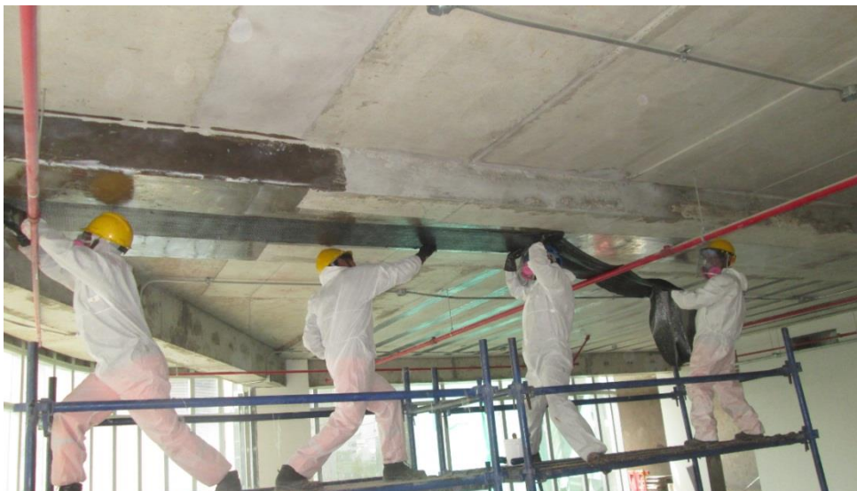
Figura 2.7: Viga de concreto pos-tensada reforzada con bandas de FRP de carbono, Lima (Cortesía: FIBRWRAP-Perú).
