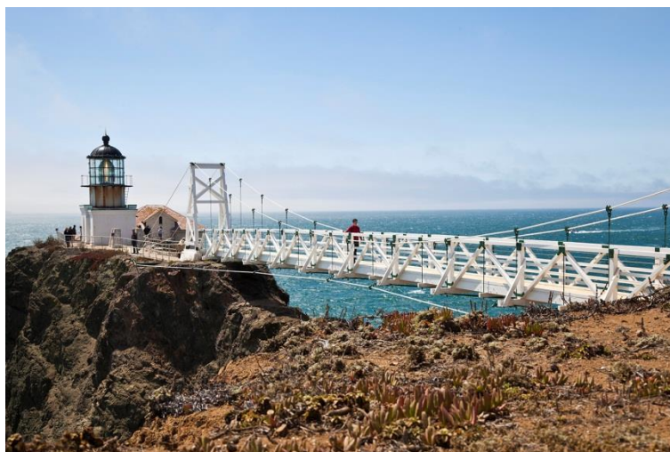
Figura 2.8: Puente peatonal tipo armadura de 124 m. en Point Bonita, Pensilvania - USA. Se utilizaron perfiles de FRP. Las principales consideraciones fueron el peso ligero y la durabilidad (fuente: Google-Imágenes).
