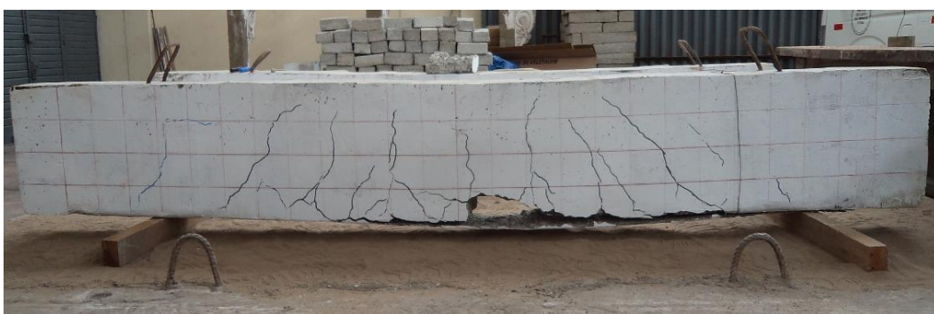
Foto 10: Elevación de Viga VF-01A, después del ensayo.
