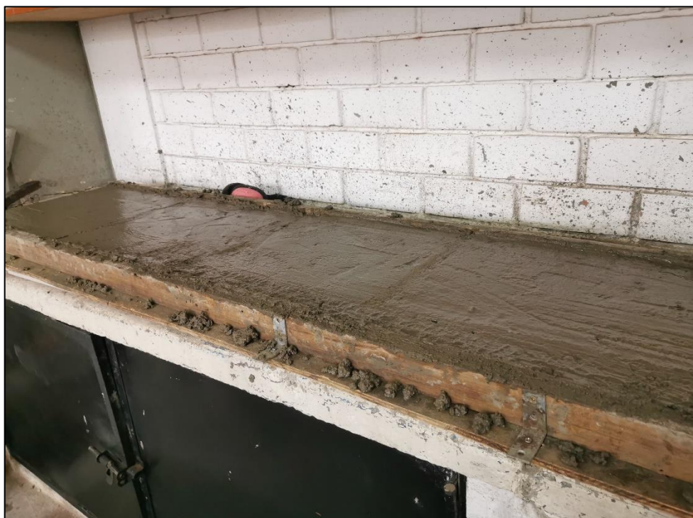
Figura N° 30. Elaboración de base de concreto para ensayo de adherencia
