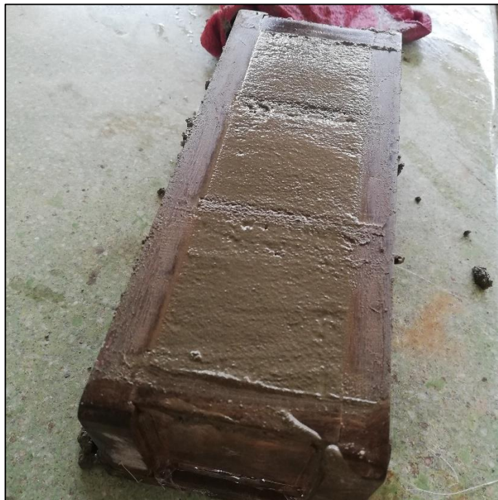
Figura N° 26. Encofrado de dados de mortero para compresión
