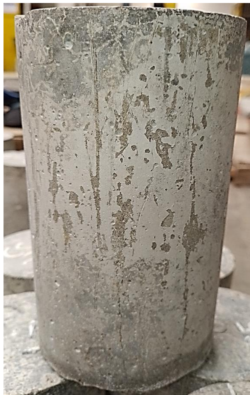
Fotografía 16 Muestras de concreto armado en el ciclo 30.
