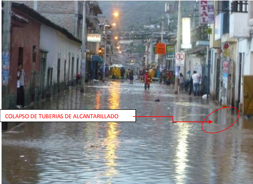
Foto N° 03. Tubería colapsada producto de las lluvias
