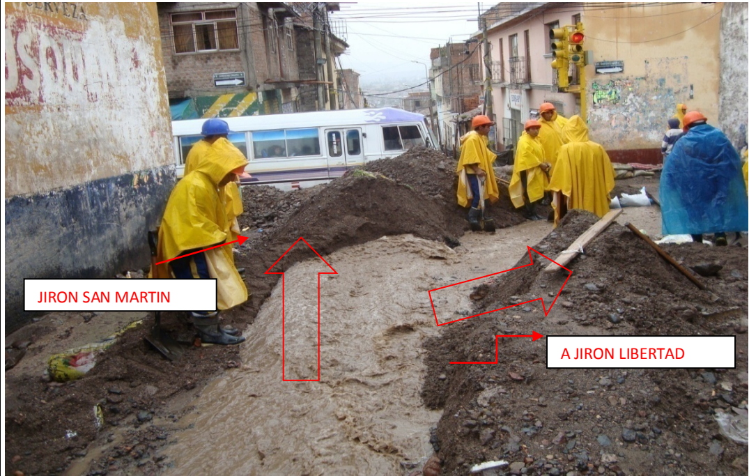
Foto N° 7. Desvío aguas pluviales y materiales sólidos hacia Jr. libertad.
