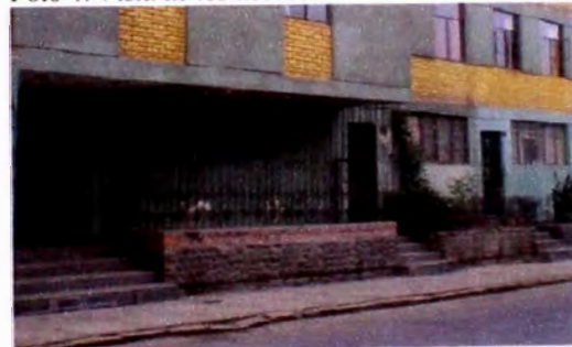
Foto 4: Vista de los accesos.
