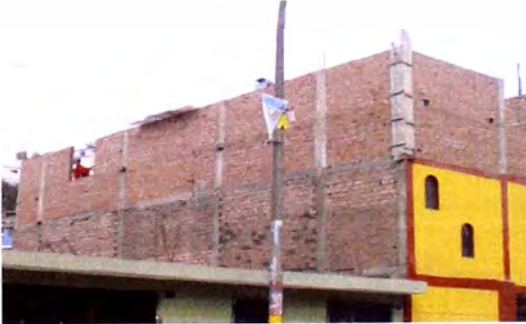
Fotos 5: Muros del tercer nivel.
