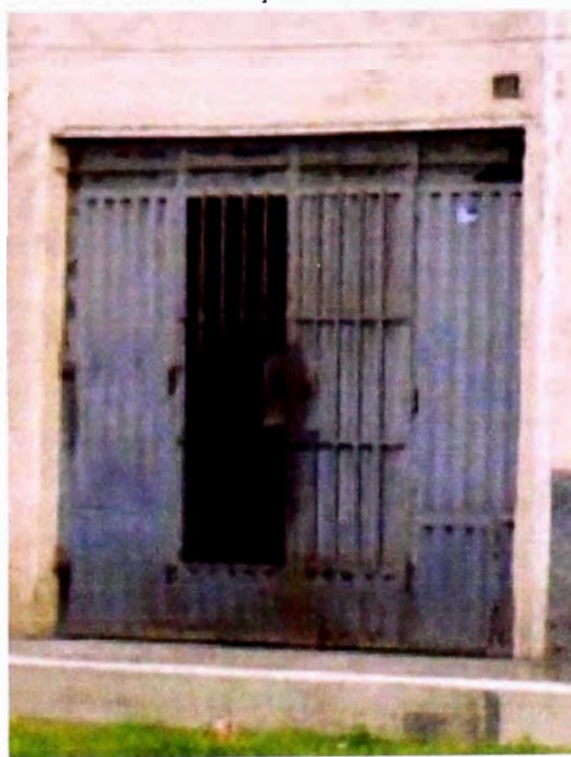
Foto 4: Vista de la carpintería metálica.
