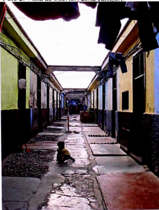
Foto 2: Vista de interior, zona callejón.
