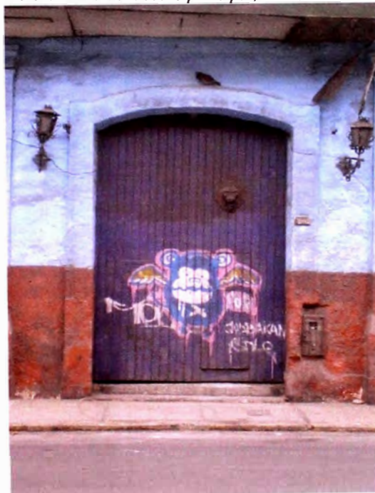
Foto 4: Vista del acceso principal, 2010.
