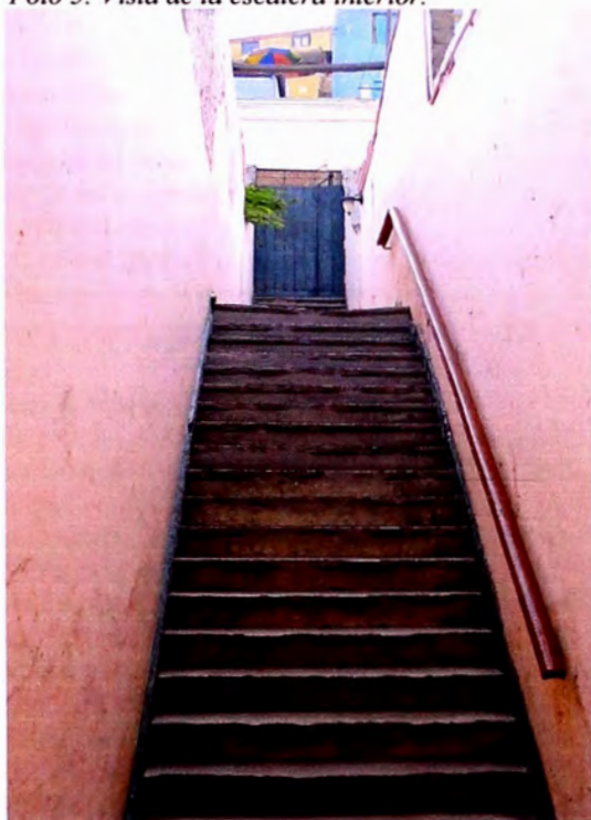
Foto 5: Vista de la escalera interior.
