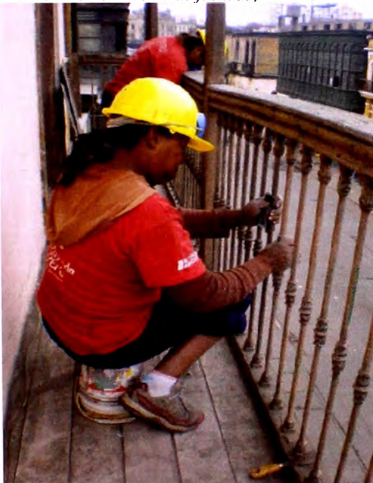
Foto 5: Mantenimiento de fachada, 2008. 2
