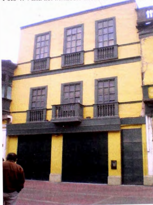
Foto 4: Vista del inmueble desde el Jr. Trujillo.
