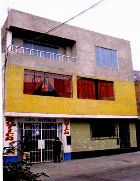
Foto 2: Edificio desde el Jr. Descalzos.
