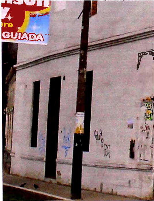
Foto 3: Carpintería de la fachada principal.
