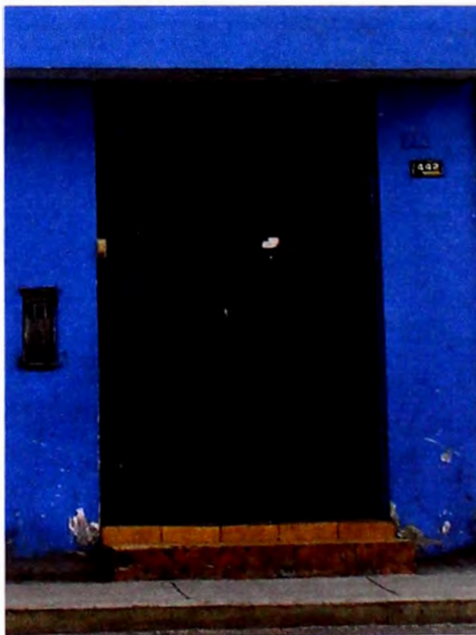
Foto 3: Vista del acceso.
