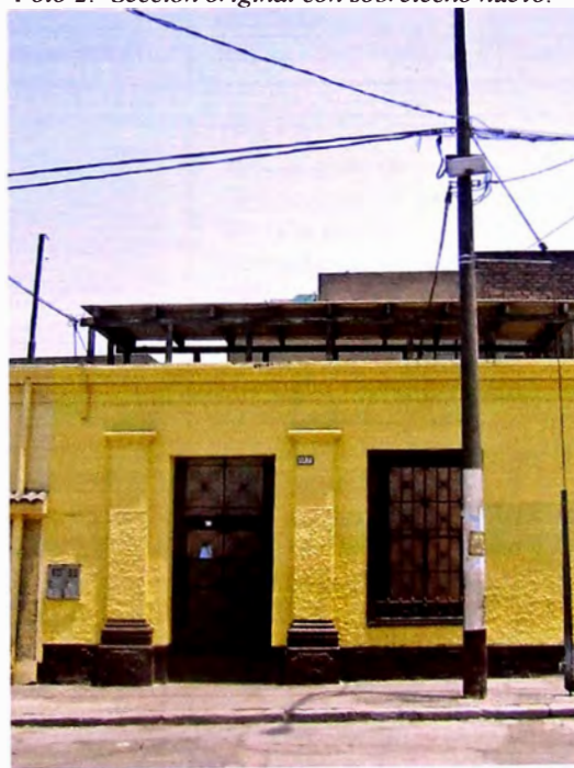
Foto 2: Sección original con sobretecho nuevo.
