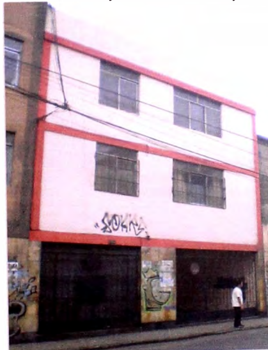
Foto 4: Vista del edificio desde el Jr. Chiclayo.
