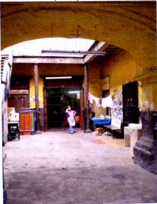
Foto 3: Vista del primer patio.
