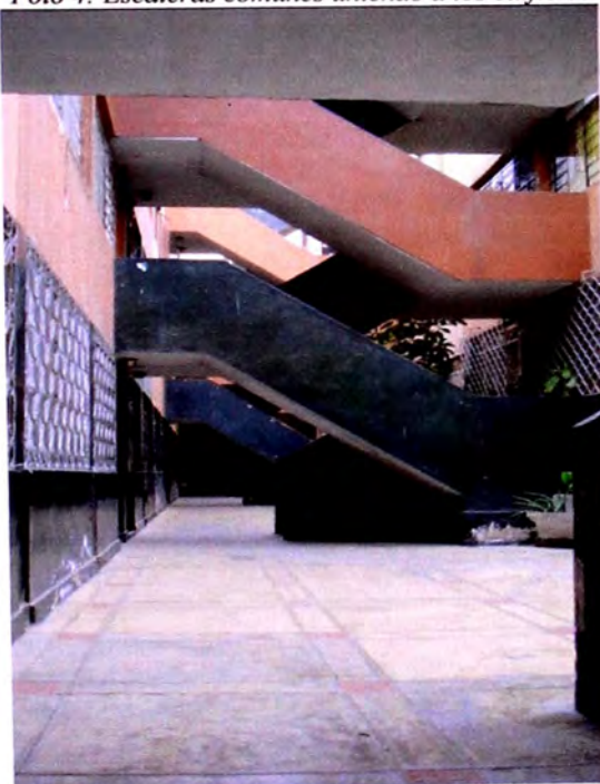
Foto 4: Escaleras comunes uniendo a los edificios.
