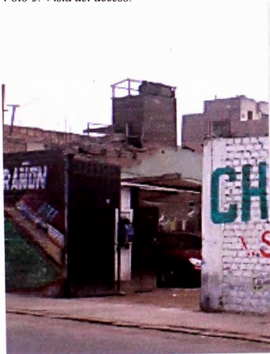
Foto 3: Vista del acceso.
