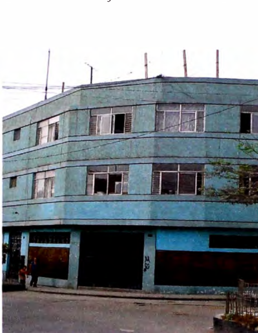
Foto 1: Vista del edificio desde el Jr. Descalzos.
