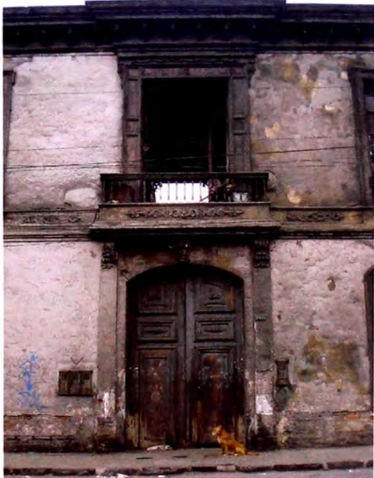
Foto 3: Vista del acceso principal, lado derecho
