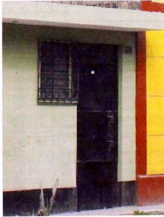
Foto 4: Ventana alta y puerta peatonal.
