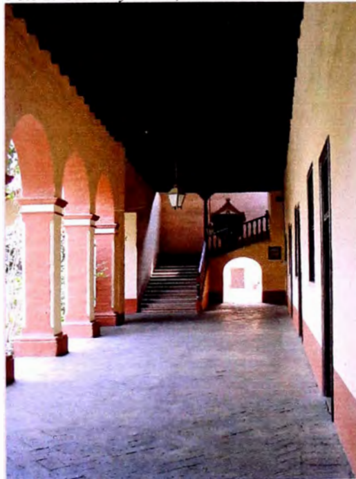
Foto 2: Galería y celdas, Claustro del Guardianal.
