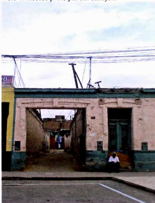
Foto 1: Acceso principal del callejón.
