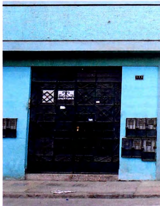
Foto 3: Acceso común sobre el Jr. Descalzos.
