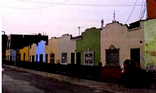
Foto 6: Sección derecha (viviendas).
