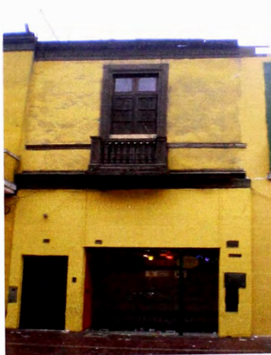
Foto 4: Vista general del inmueble.
