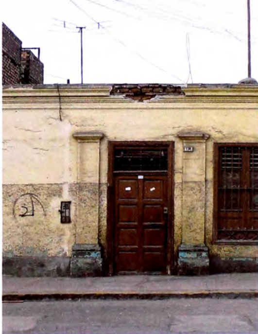
Foto 2: Vista del acceso.
