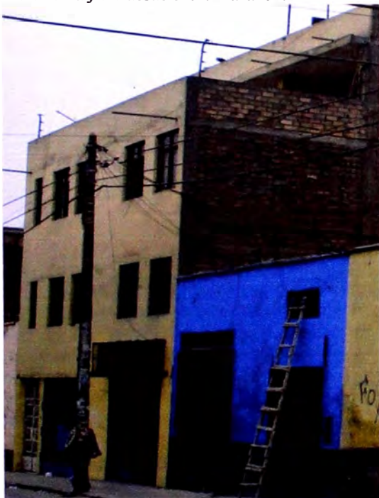
Foto 2: Edificio desde el Jr. Marañón.
