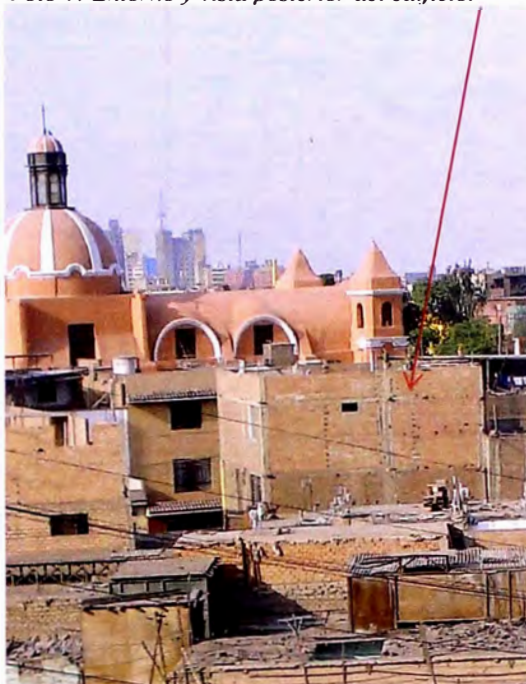
Foto 1: Entorno y vista posterior del edificio.
