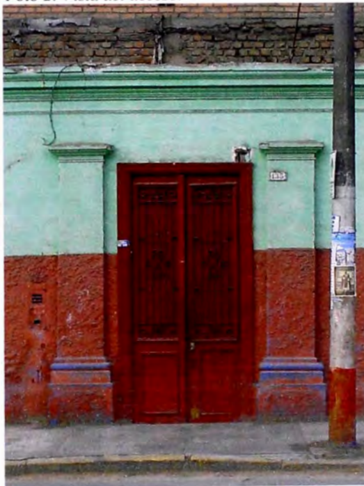
Foto 2: Vista del acceso.
