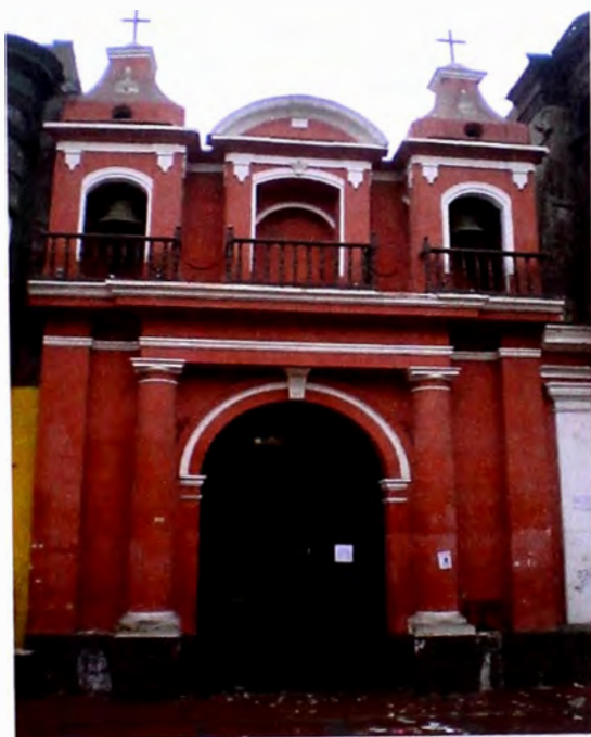
Foto 1: Vista desde Jr. Trujillo.
