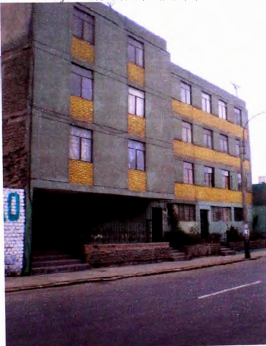
Foto 3: Edificio desde el Jr. Marañón.
