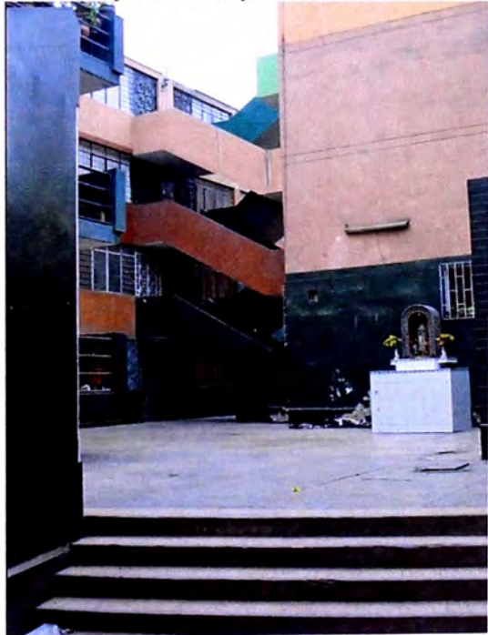
Foto 3: Edificio interior y área central.
