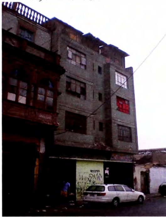
Foto 1: Edificio desde Jr. Casma
