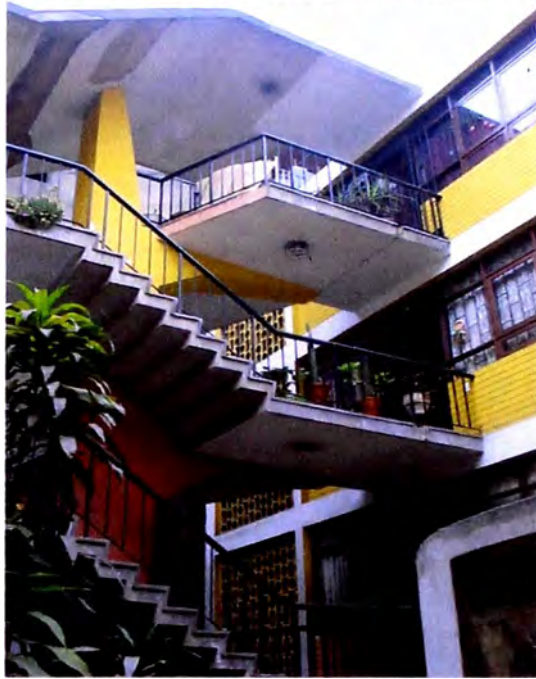
Foto 1: Vista del Segundo al cuarto piso.
