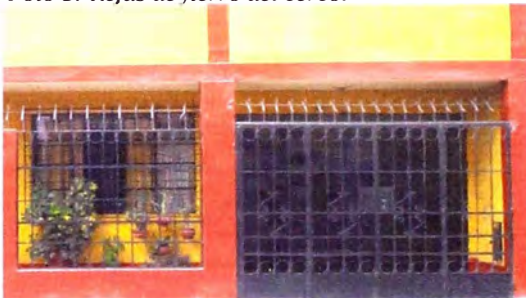
Foto 3: Rejas de fierro del cerco.
