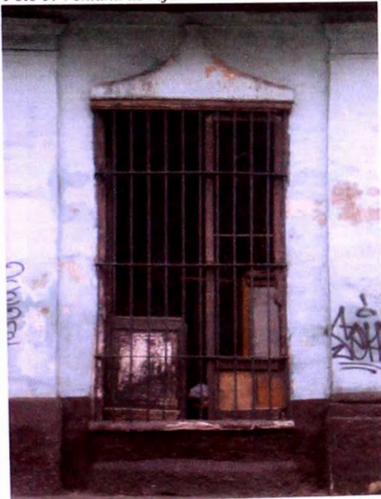
Foto 5: Ventana de reja.
