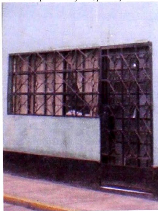
Foto 4: Carpintería de fierro, puerta y ventana.
