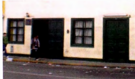
Foto 3: Vista de los accesos.
