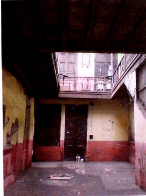
Foto 5: Vista interior del primer piso.
