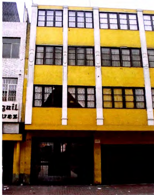
Foto 1: Acceso común, Jr. Trujillo
