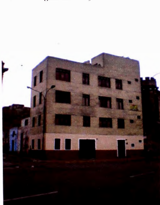
Foto 3: Vista general del edificio.
