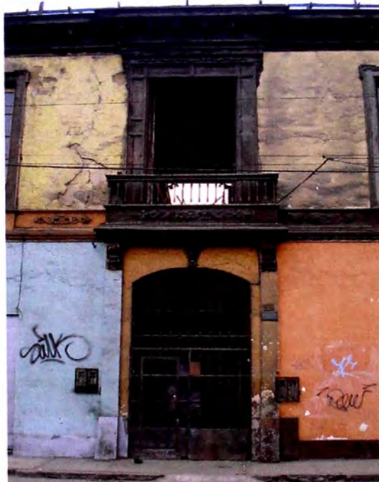
Foto 2: Vista del acceso principal, lado izquierdo
