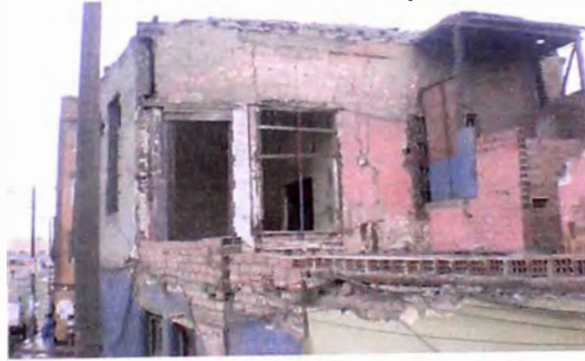
Foto 5: Sección central, derrumbe parcial.
