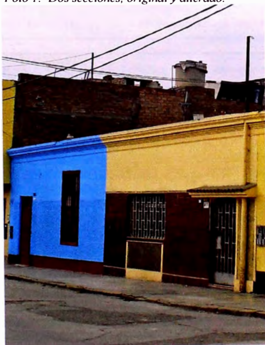
Foto 1: Dos secciones, original y alterado.
