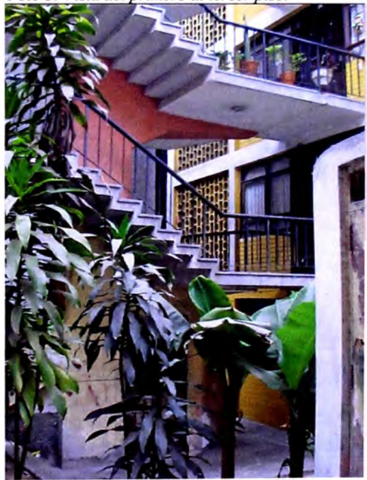
Foto 3: Vista del primero al tercer piso.
