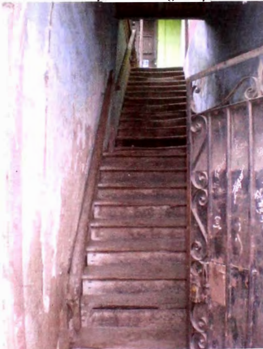
Foto 8: Escalera que lleva al segundo piso.
