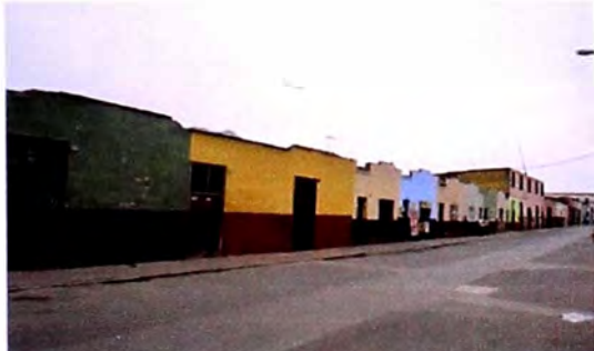
Foto 5: Sección derecha (viviendas).
