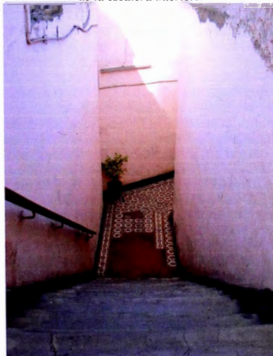
Foto 7: Vista de la escalera interior.
