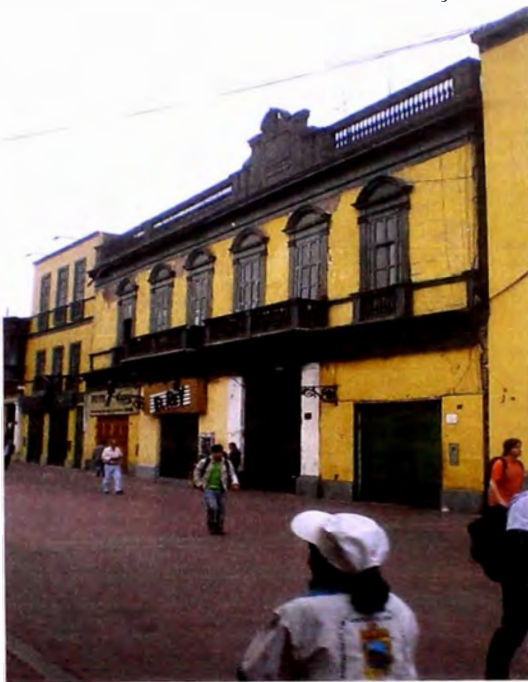
Foto 1: Vista del inmueble desde el Jr. Trujillo
