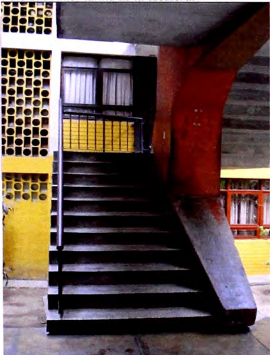
Foto 2: Primer tramo de la escalera.
