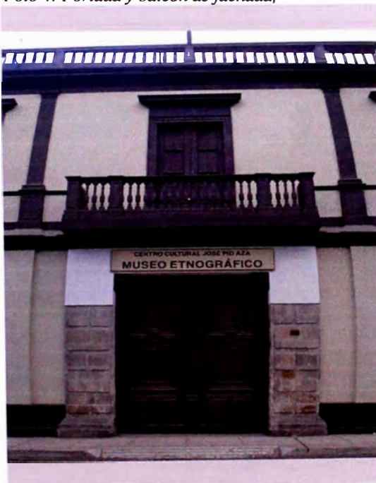
Foto 4: Portada y balcón de fachada,
