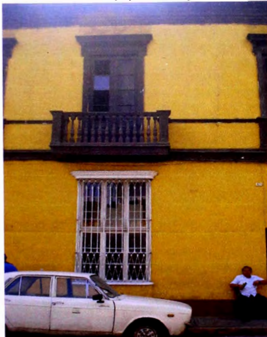
Foto 3: Ventana de reja y balcón cajón abierto.
