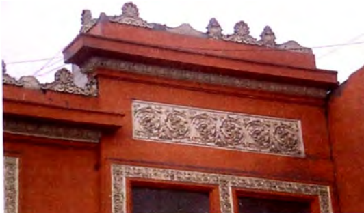
Foto 3: Detalle de la cornisa y las chambranas.
