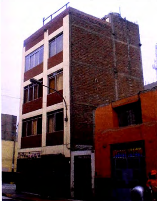
Foto 3: Vista del edificio desde Jr. Rufino Torrico
