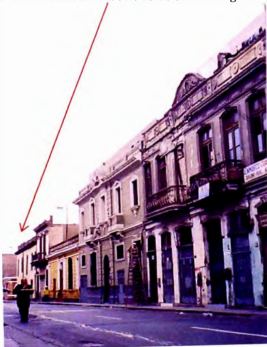
Foto 1: Vista del inmueble desde el Jr. Azángaro.
