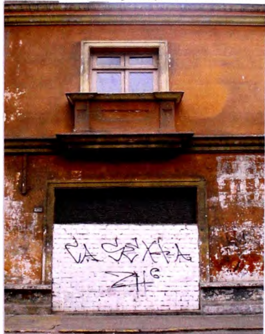
Foto 4: Balcón de antepecho y vano clausurado.
