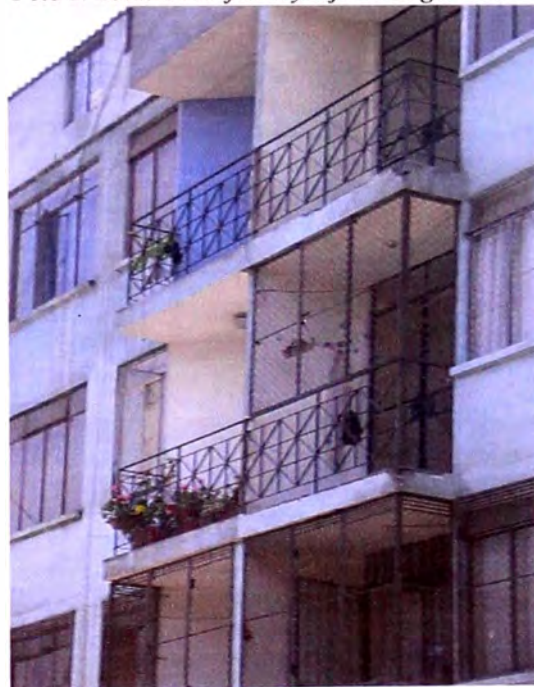
Foto 2: Balcones de fierro y rejas de seguridad.
