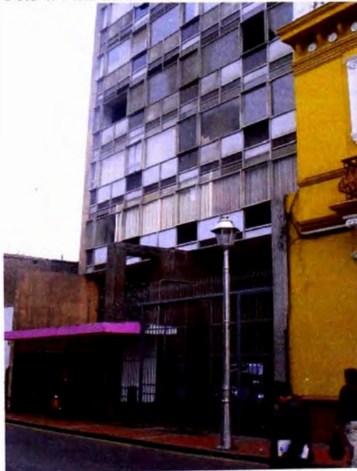
Foto 4: Vista del acceso.
