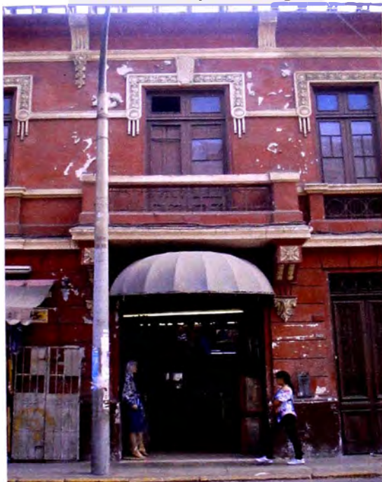
Foto 4: Vista del sector izquierdo, original.
