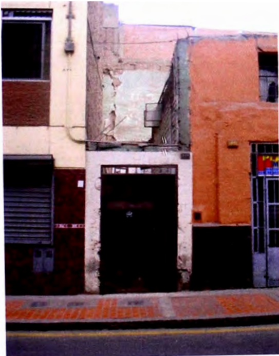
Foto 3: Vista del acceso al corralón.
