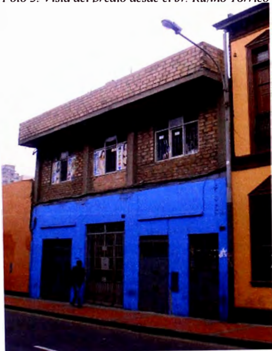
Foto 3: Vista del predio desde el Jr. Rufino Torrico
