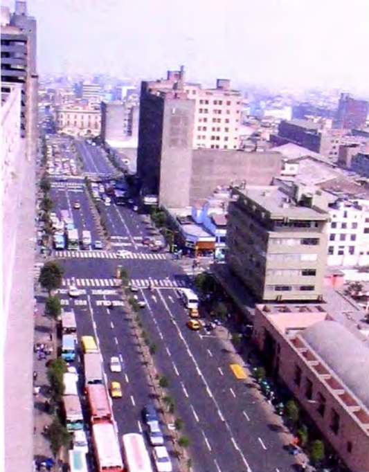
Foto 5: Vista aérea del edificio y la Av. Tacna. 2
