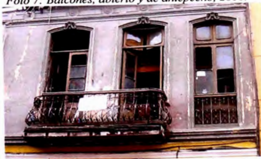
Foto 7: Balcones, abierto y de antepecho, 2010.
