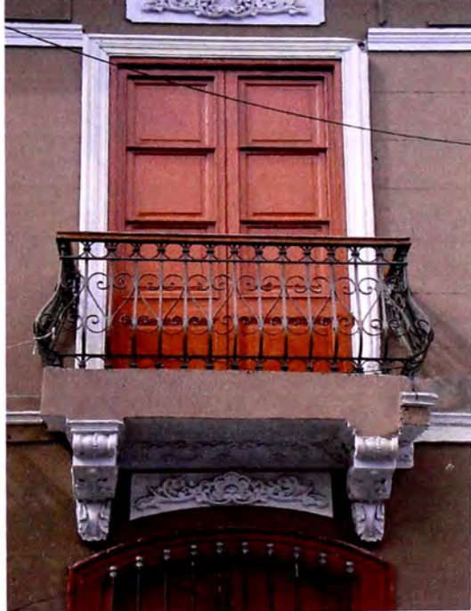
Foto 3: Balcón de cajón abierto lateral.
