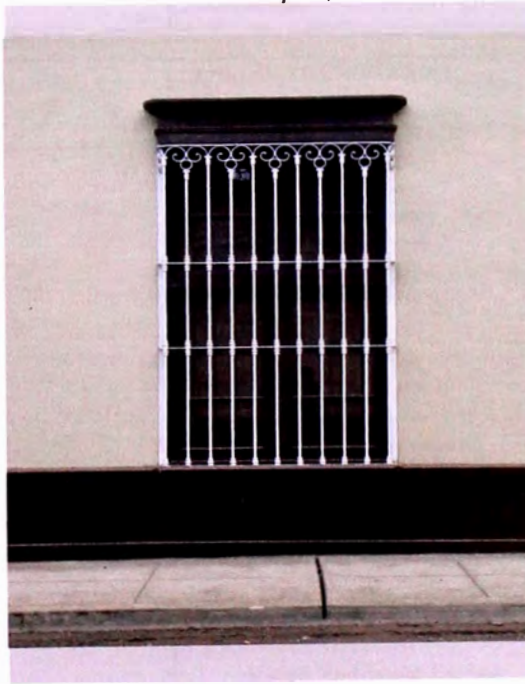
Foto 5: Ventana exterior típica,
