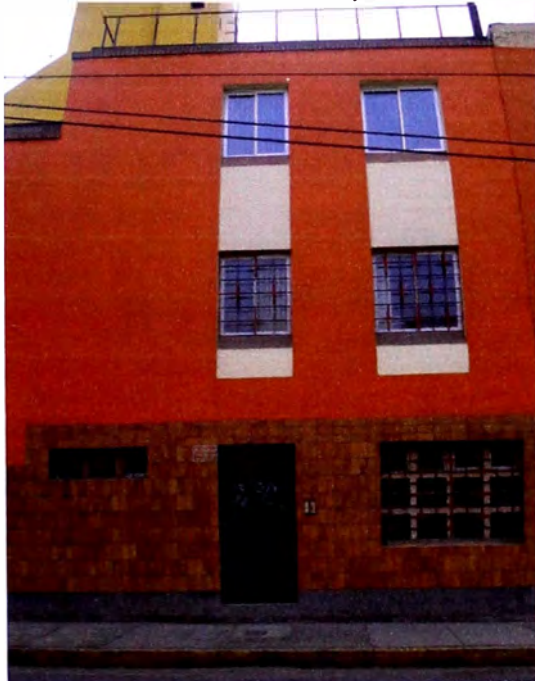
Foto 1: Vista desde el Jr. Chancay.
