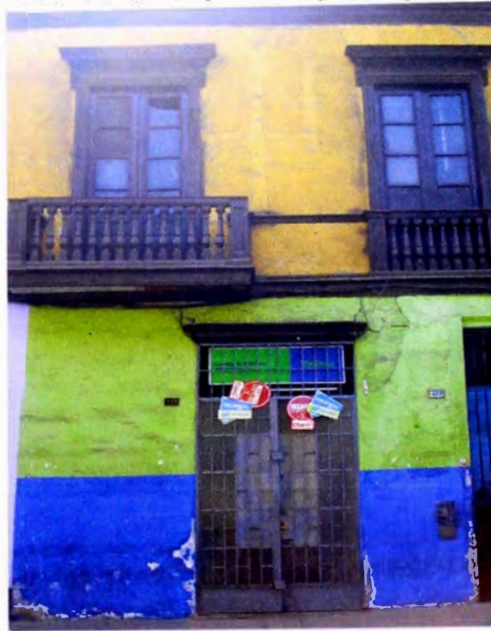
Foto 4: Balcónes, cajón abierto y de antepecho.
