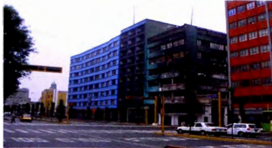
Foto 2: Vista del edificio desde la Av. Tacna, 2008.
