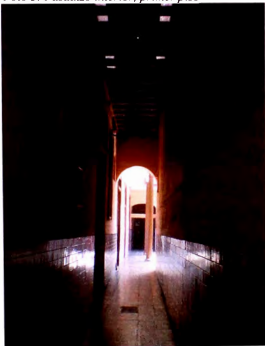
Foto 3: Pasadizo interior, primer piso
