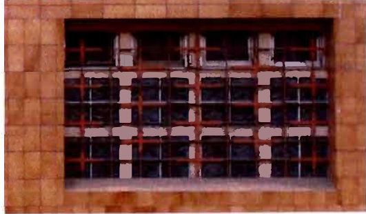
Foto : Ventana con bloques de vidrio, primer piso.
