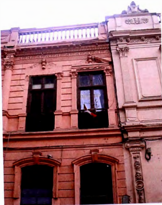
Foto 5: Balcones de antepecho y molduras.
