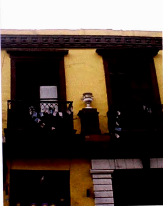
Foto 4: Balcones de cajón abierto.
