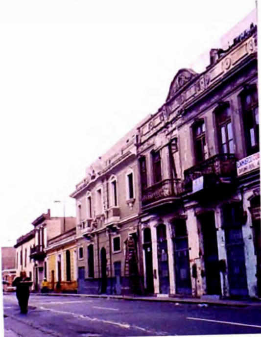
Foto 2: Vista del inmueble desde el Jr. Azángaro.
