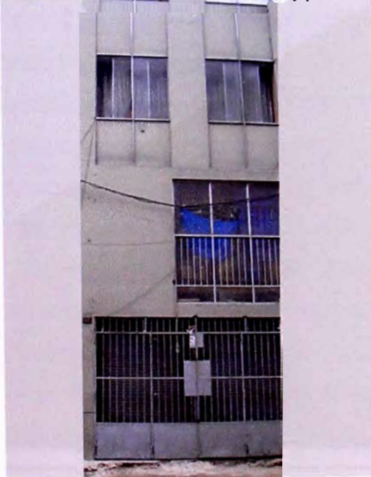
Foto 3: Detalle de carpinteria, ventanas y puertass
