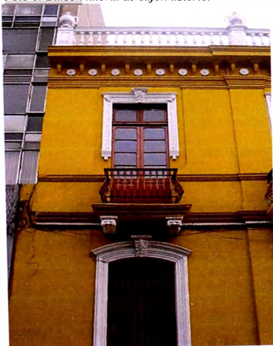
Foto 6: Balcón lateral de cajón abierto.
