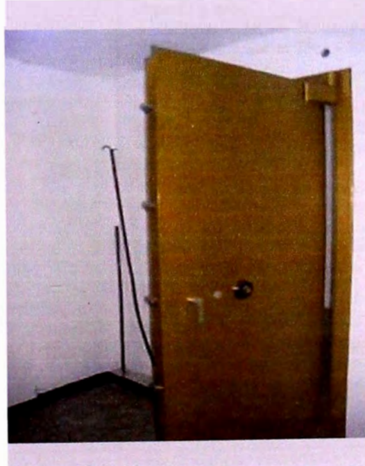
Foto 5: Bóveda del local.
