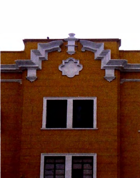
Foto 3: Detalle de la cornisa de remate.
