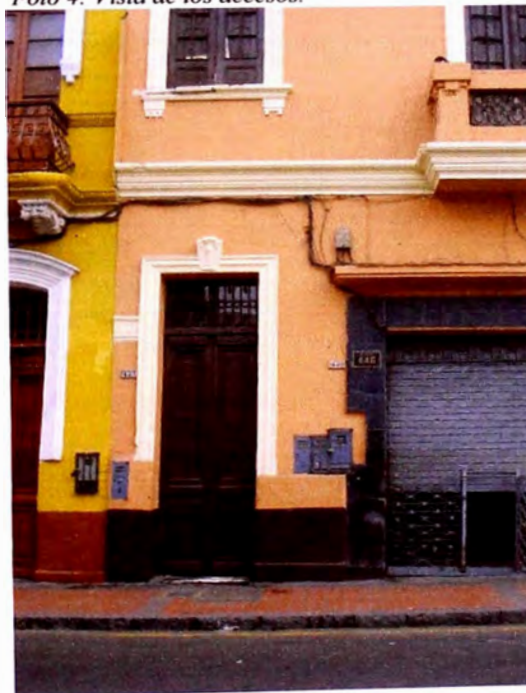
Foto 4: Vista de los accesos.
