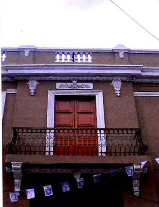
Foto 2: Balcón de cajón abierto central.
